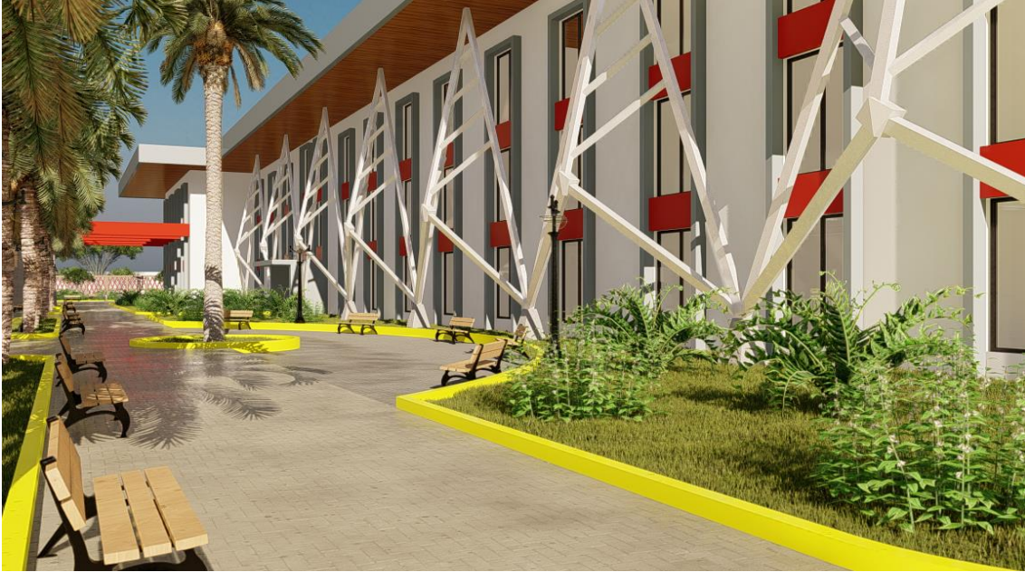
Figura 111. Modulo Principal 3 – Ventanas de Vidrio Templado.
