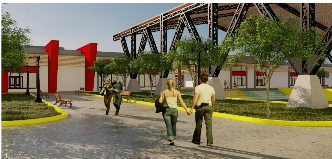
Vista 3D. Exteriores CANCHA DEPORTIVA CON DADOS DE MORTERO ARMADO Y ACERO INOXIDABLE TRIANGULAR PARA EL ZOPORTE ESTRUCTURAL DE LA COBERTURA
