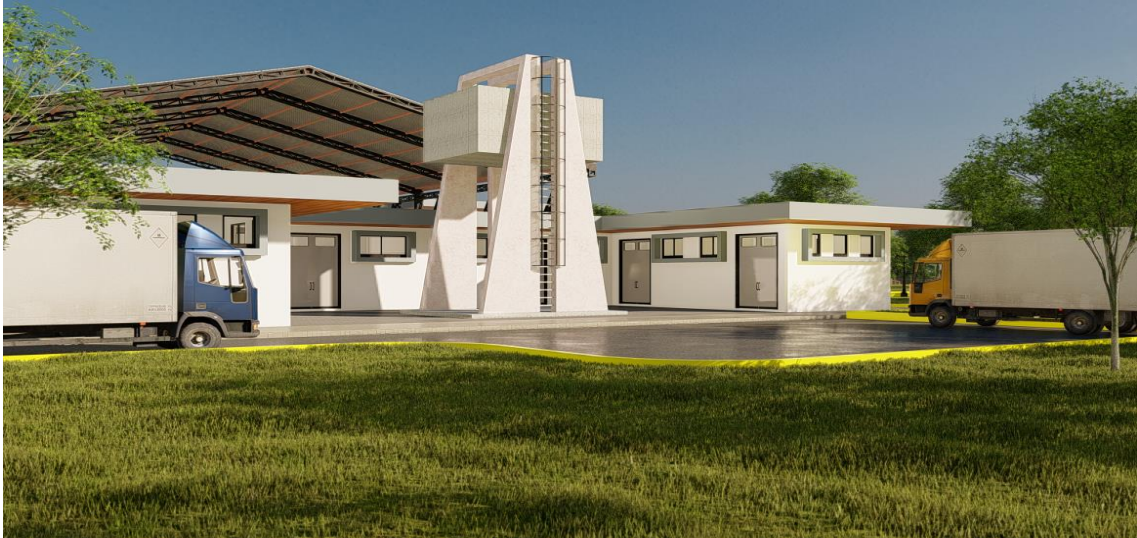
Figura 103. Tanque Elevado – Hecho de Mortero Armado.
