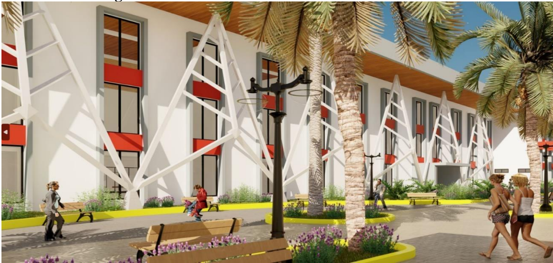
Figura 163. Protectores Solares en Fachadas Laterales.
