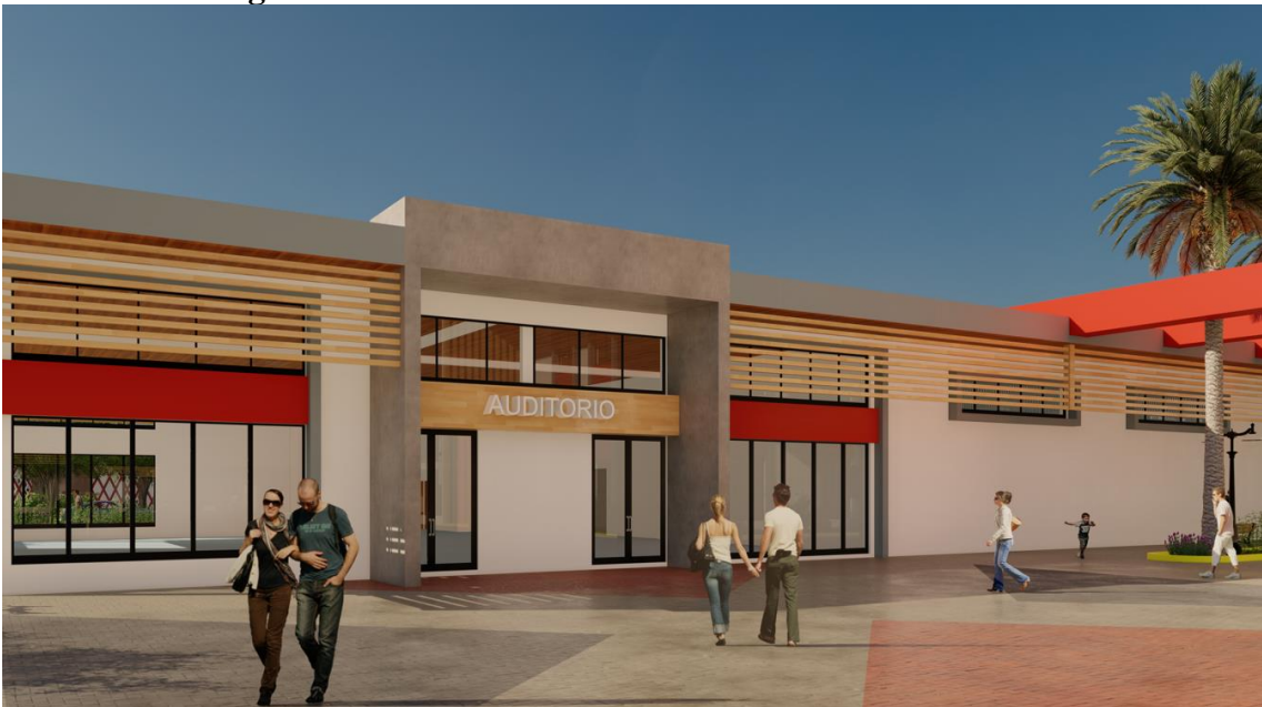
Figura 107. Auditorio vista Lateral Derecho 1 – Celosías.
