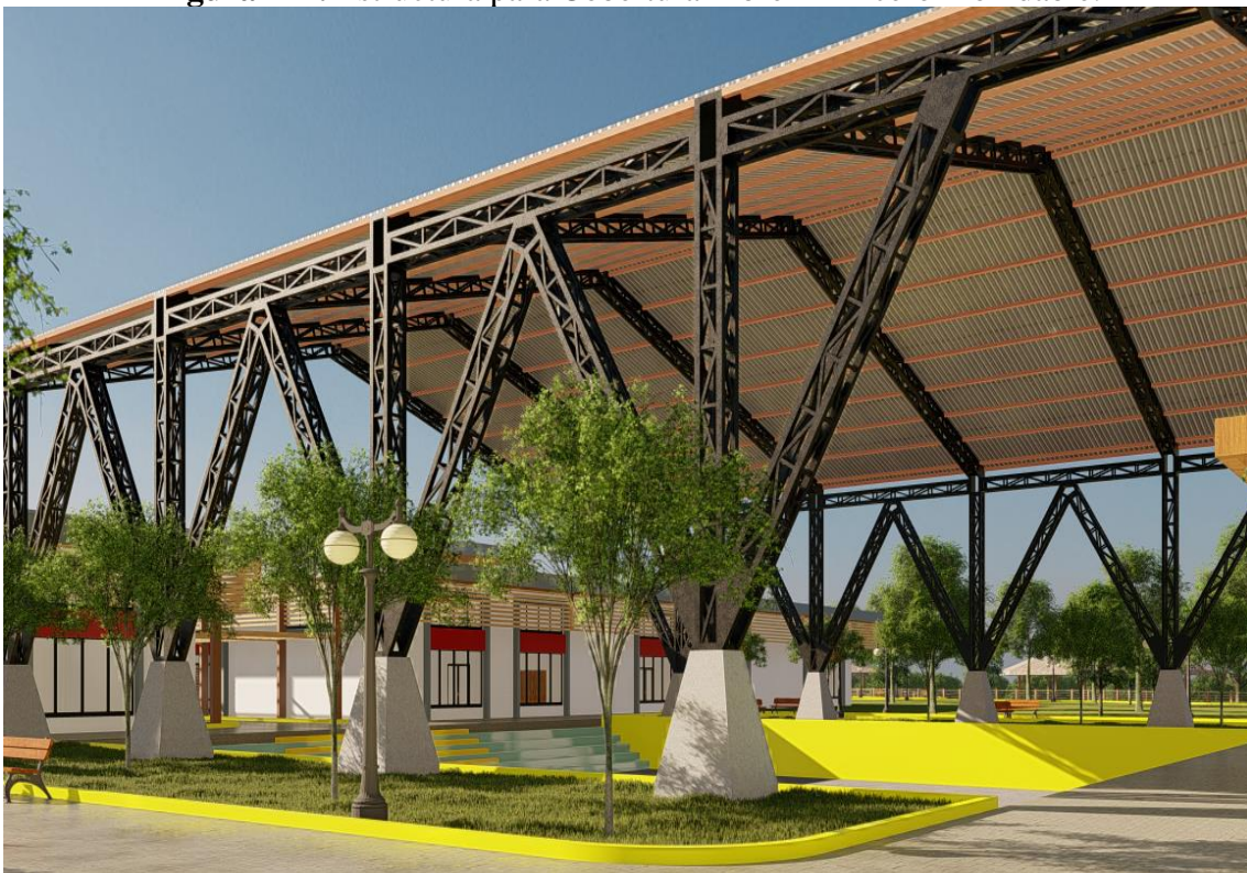
Figura 121. Estructura para Cobertura Libre 1 – Acero Inoxidable.
