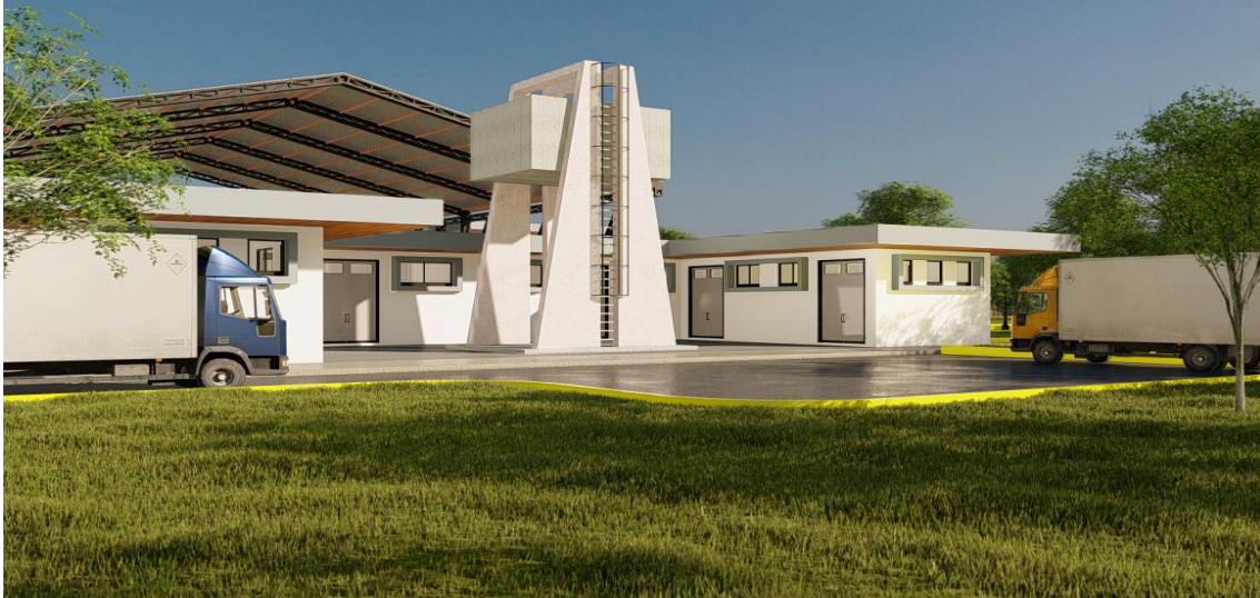
Figura 103. Tanque Elevado – Hecho de Mortero Armado.
