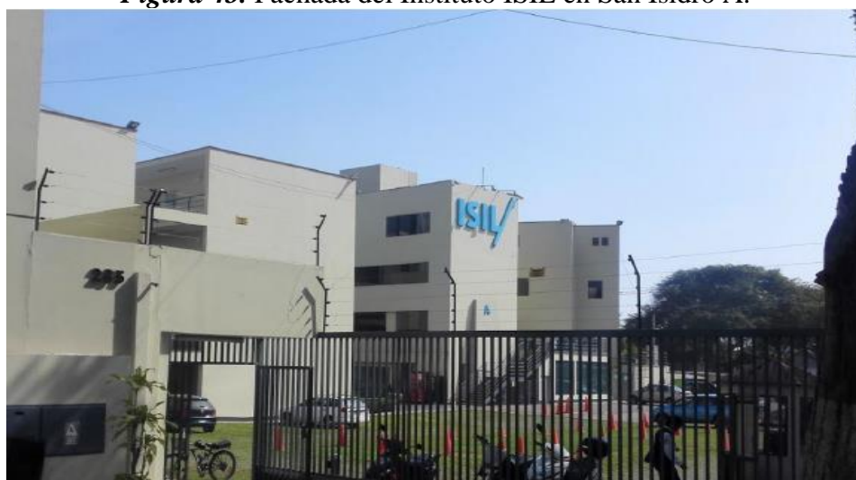
Figura 43. Fachada del Instituto ISIL en San Isidro A.
