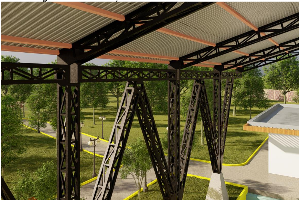
Figura 123. Estructura para Cobertura Libre 3 – Acero Inoxidable.
