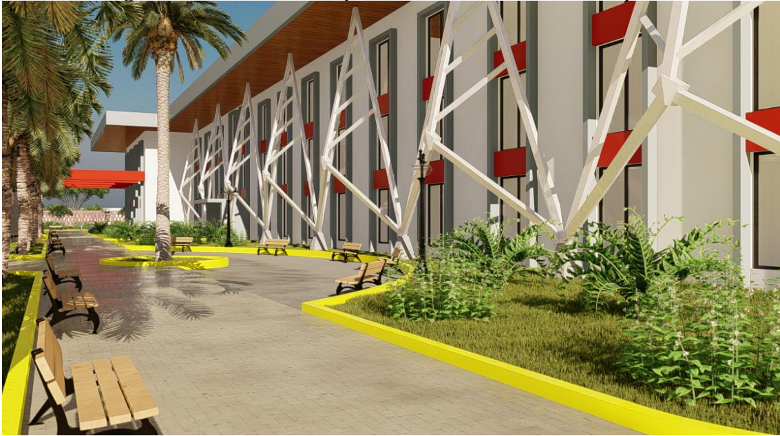
Figura 111. Modulo Principal 3 – Ventanas de Vidrio Templado.
