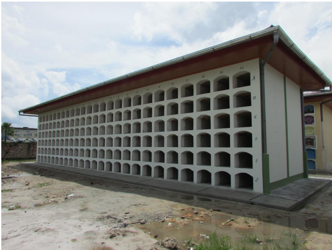
Foto N° 01: Pabellón de nichos
