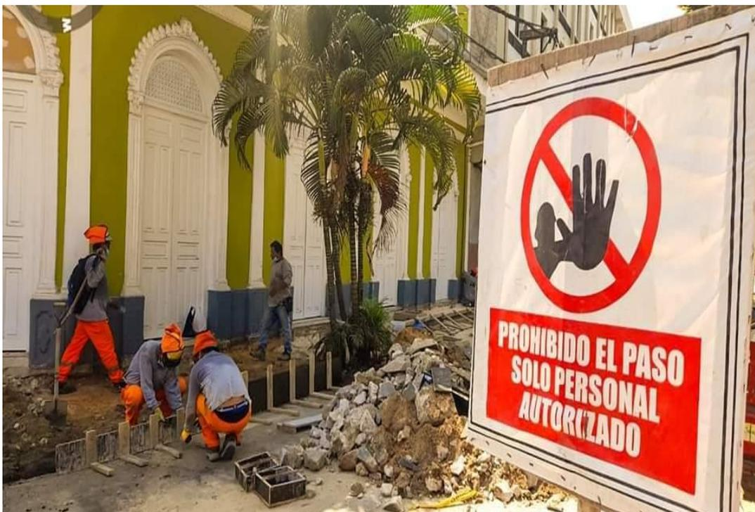
*Figura 21: encofrado de vereda*
