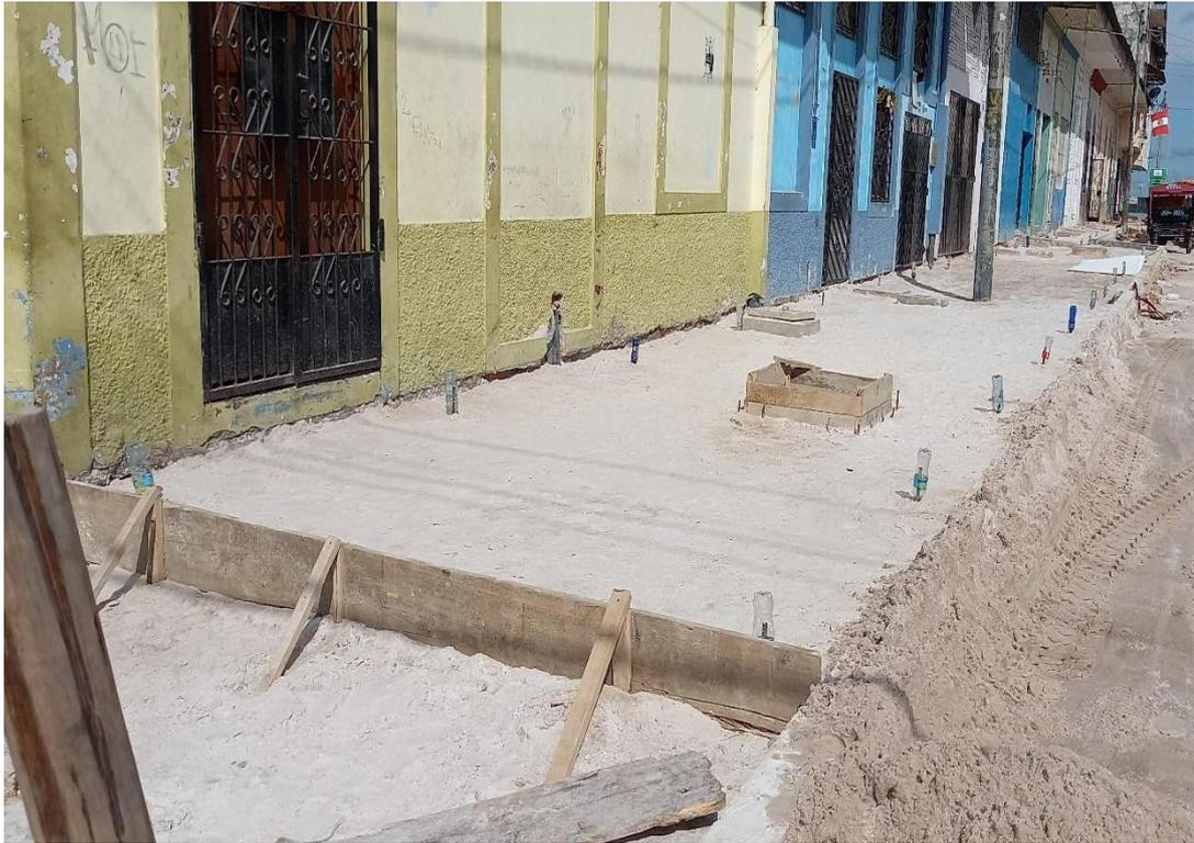
*Figura 23: Encofrado de vereda calle Nauta*
