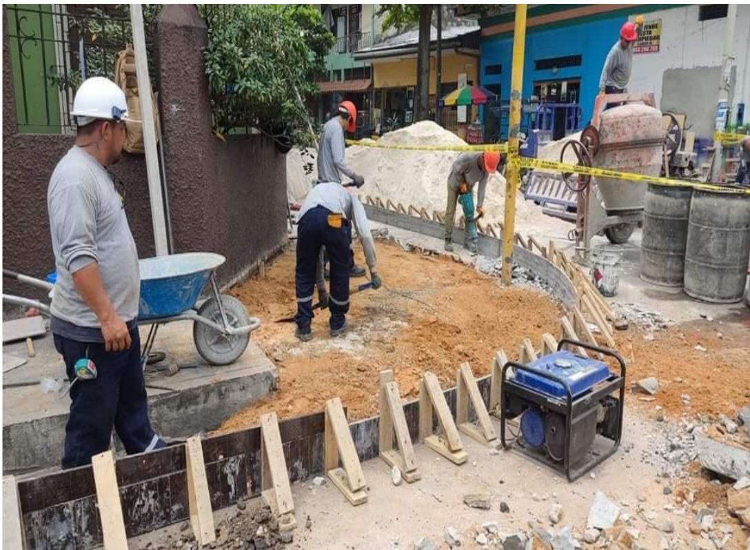
*Figura 24: Encofrado de Martillo*
