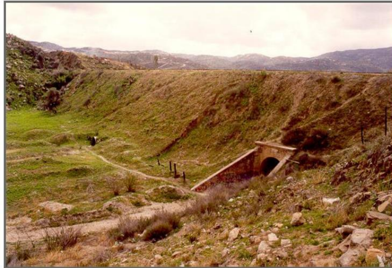
Fig 2. Alcantarilla debajo de la línea de ferroxarril Cañada Joel Bill, Tecate, Baja California, Mexico
