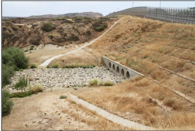
Fig. 1 Alcantarilla del Cañón Yogurt, en la frontera internacional entre California, EE.UU. y Baja California, México.
