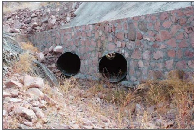
Fig 6. Un conjunto de dos alcantarillas de acero corrugado.
