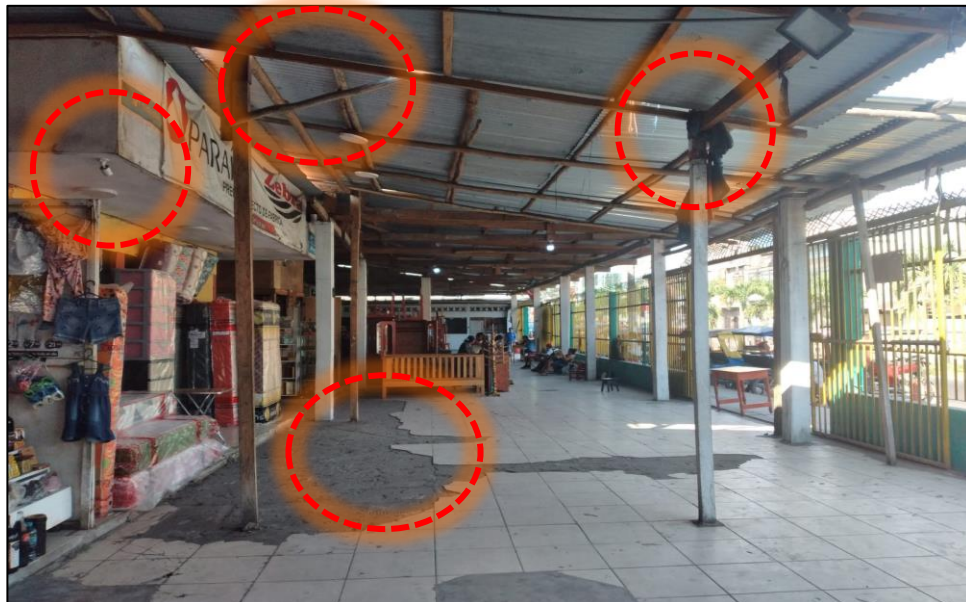
FIGURA 29: ESTADO ACTUAL INTERIOR
