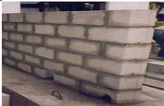
Figura N° 01 : Muro de Ladrillo de Mortero.
