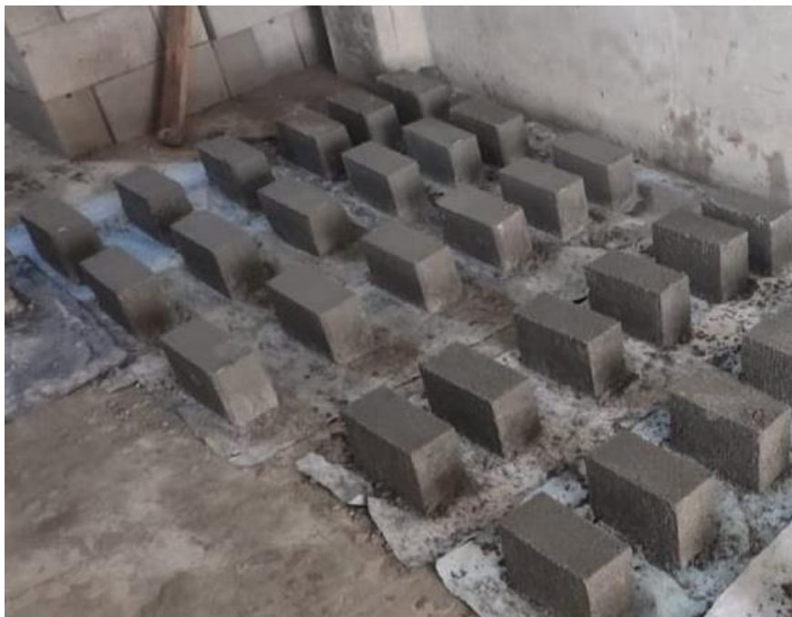
Foto N° 21 : Ladrillos de Concreto, para orearse y el secado a temperatura ambiente.
