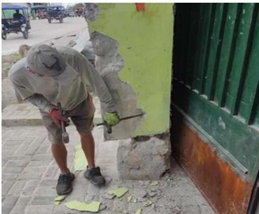
Foto N° 02 : Extracción del Material – Residuos de Tarrajeo para la Elaboración del Ladrillo.
