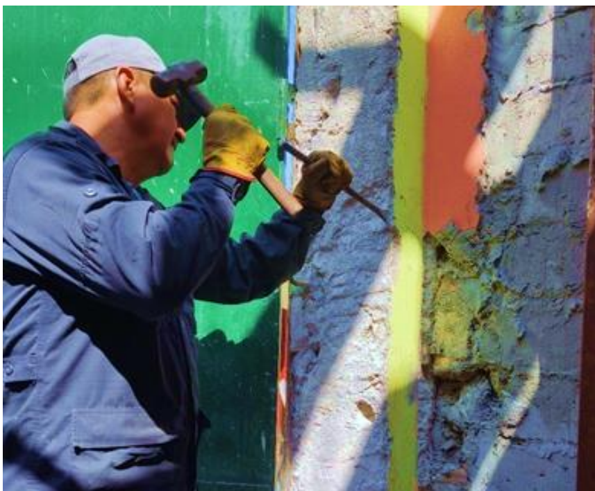
Foto N° 01 : Extracción del Material – Residuos de Tarrajeo para la Elaboración del Ladrillo.
