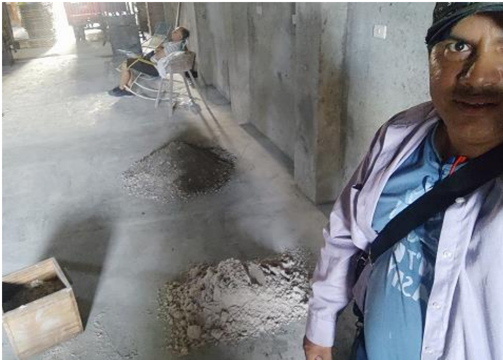
Foto N° 07 : Medición y Proporcionalidad del Agregado Fino para la Elaboración del Ladrillo Convencional de Mortero.
