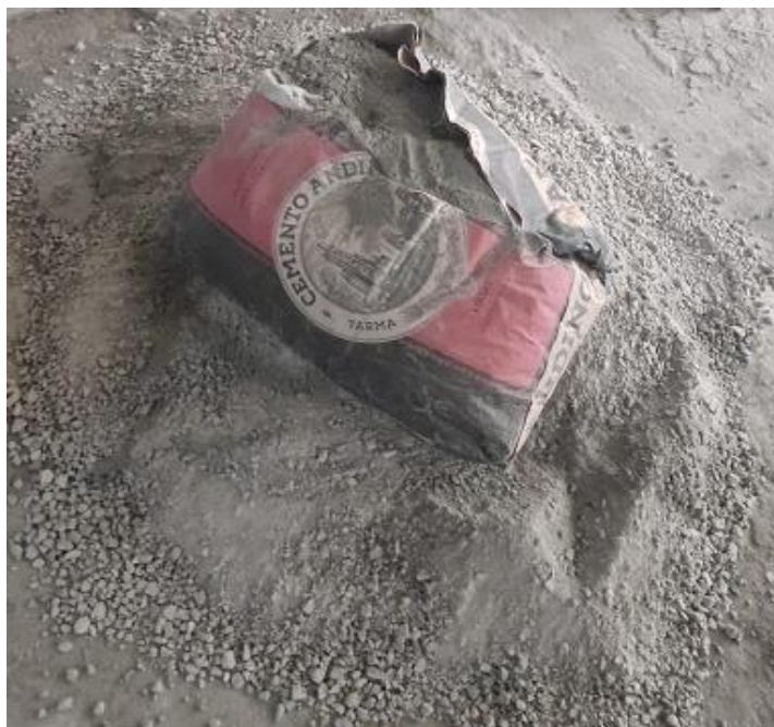
Foto N° 18 : Materiales: Cemento y Residuos de Tarrajeo para la Elaboración del Ladrillo de Concreto.
