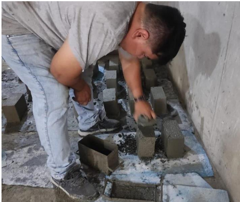
Foto N° 13 : Desmoldeo de los ladrillos convencionales de Mortero, para luego orearse.
