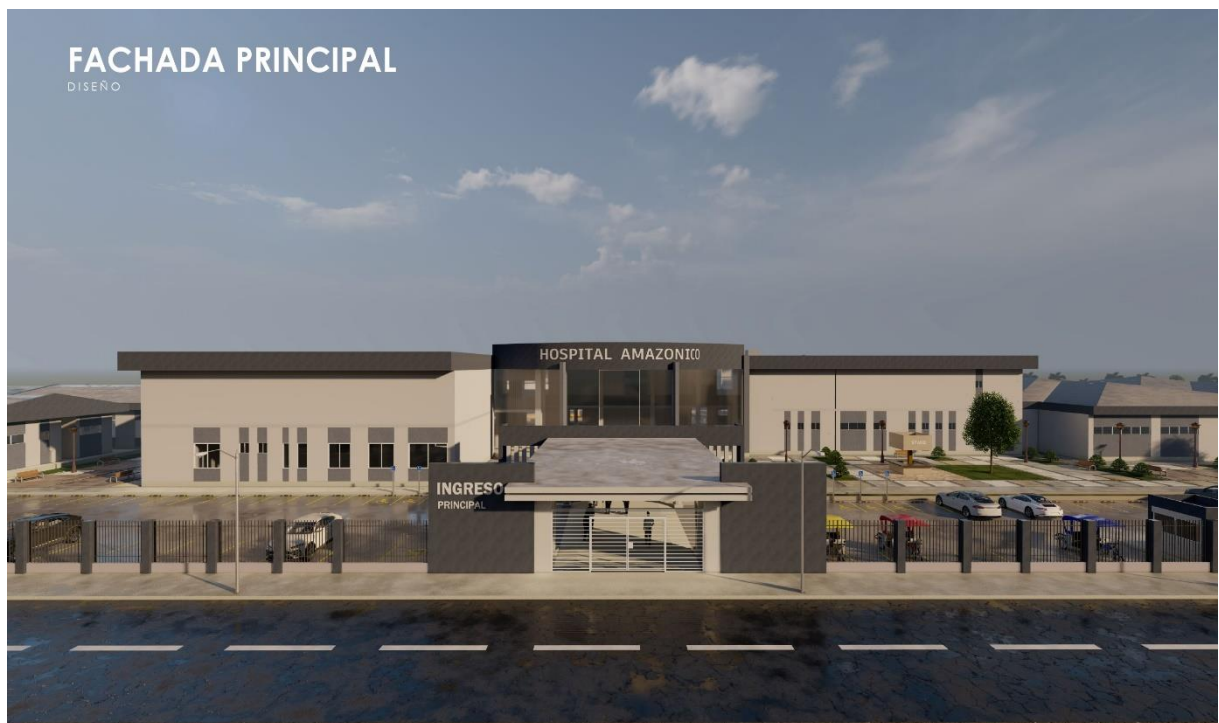
Imagen 04: Fachada Principal - Fuente: Elaborado por el Equipo de Trabajo
