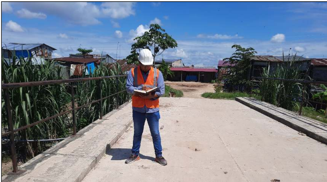
Foto 10: Evaluación superficial de pavimento rígido
