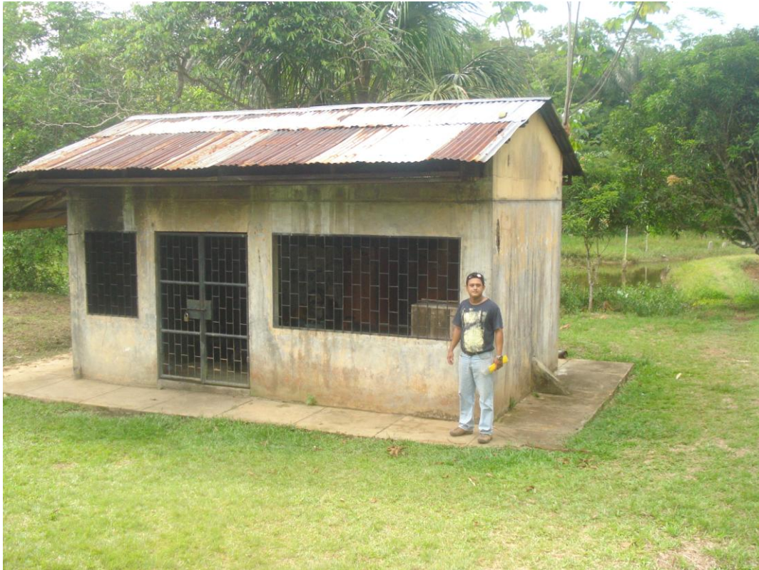
Planta de Potabilización de Agua – Santa Clotilde
