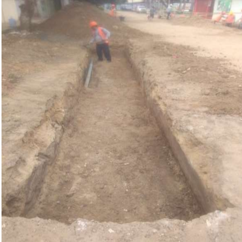
Perfilado de cuneta
