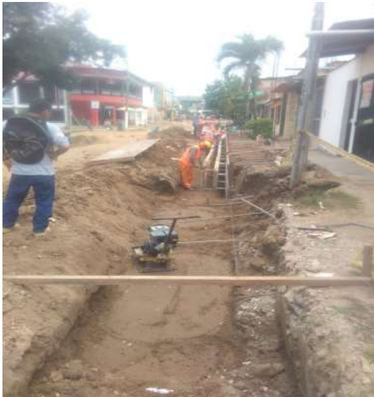
Encofrado de cuneta
