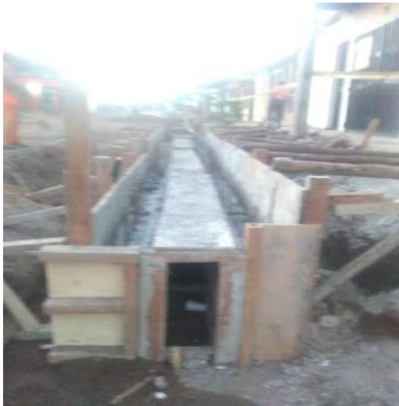
Vaciado de concreto
