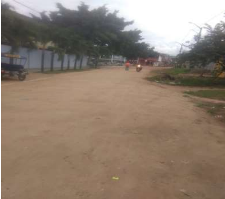
Jr Los Jardines cuadra 1. Antes de iniciada la obra
