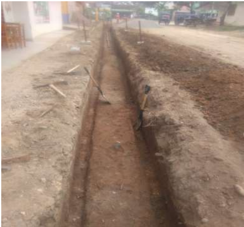
Perfilado de cuneta
