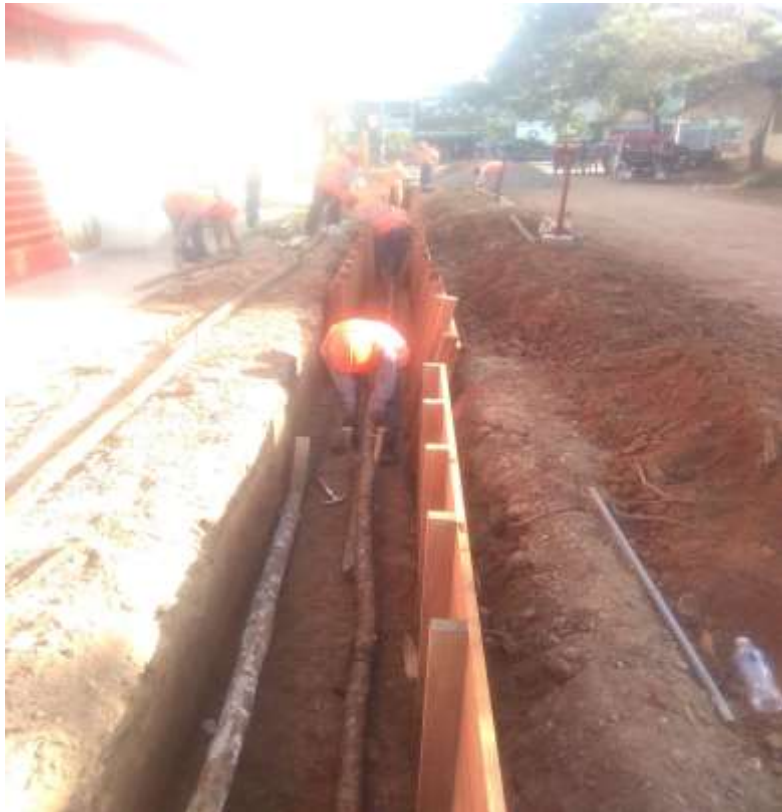
Encofrado de cuneta
