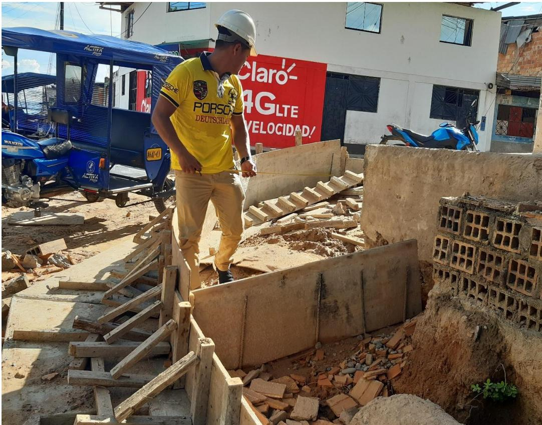
Encofrados de martillos en el jr. Leticia cd. 04 – Morales, para luego proceder a vaciar el concreto  $F_c = 175 \text{ kg/cm}^2$
