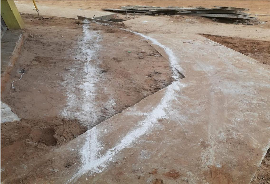
Trazo y replanteo del Martillo para ser encofrado
