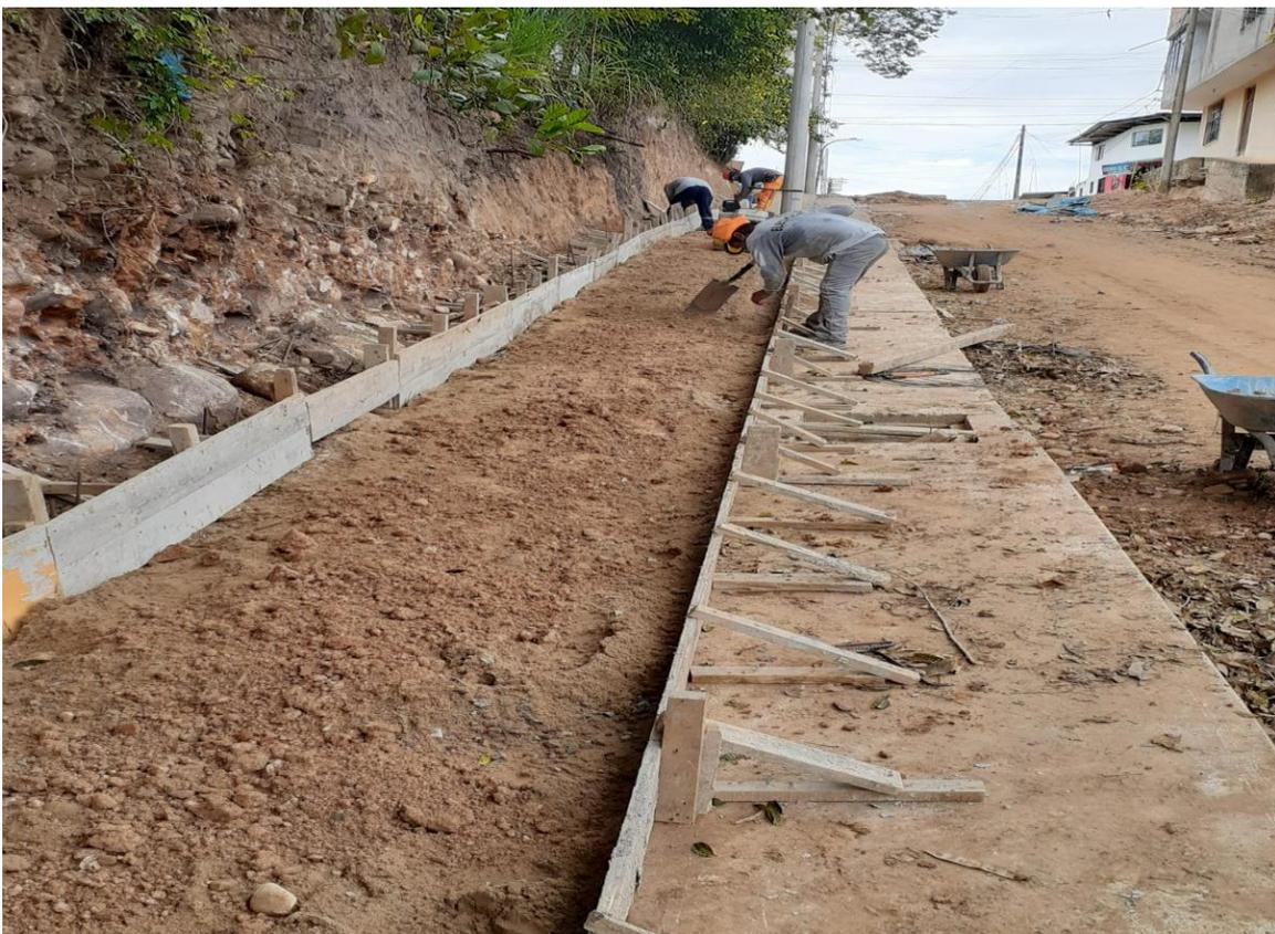
Colocación de material de relleno para la compactación y luego proceder con el vaciado de la vereda.
