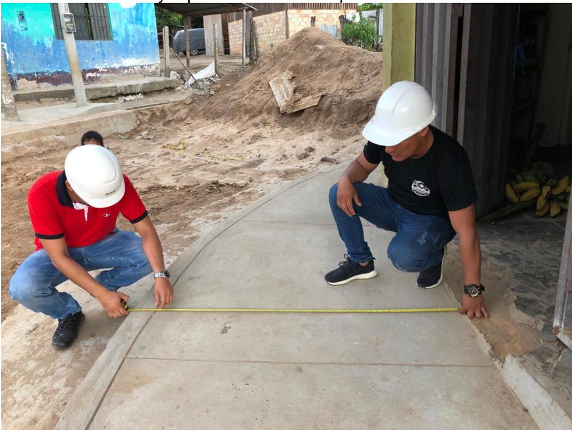
Observamos el vaciado concluido del martillo con un concreto  $f_c = 175 \text{ kg/cm}^2$ .
