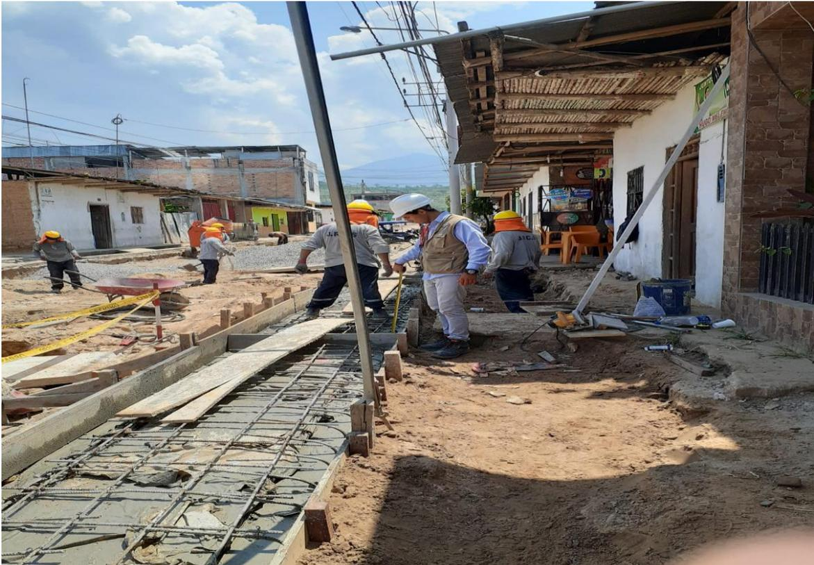
Podemos apreciar en esta imagen los encofrados de losa de alcantarilla y la limpieza de terreno de las veredas respectivamente.
