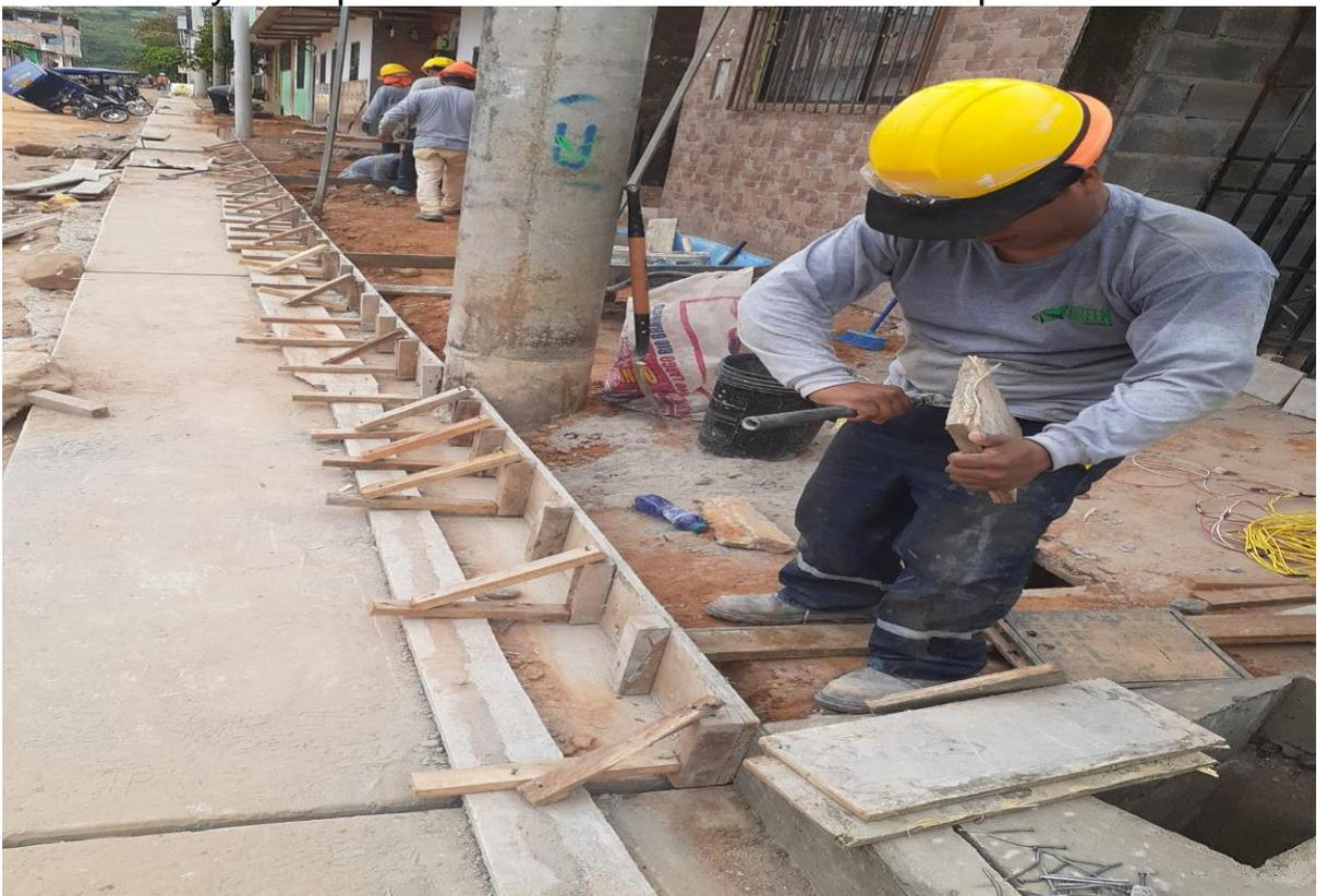
Encofrados de veredas y podemos apreciar las juntas de dilatación cada 3 metros respectivamente, para proceder con el vaciado del concreto  $F_c=175\text{kg/cm}^2$ .
