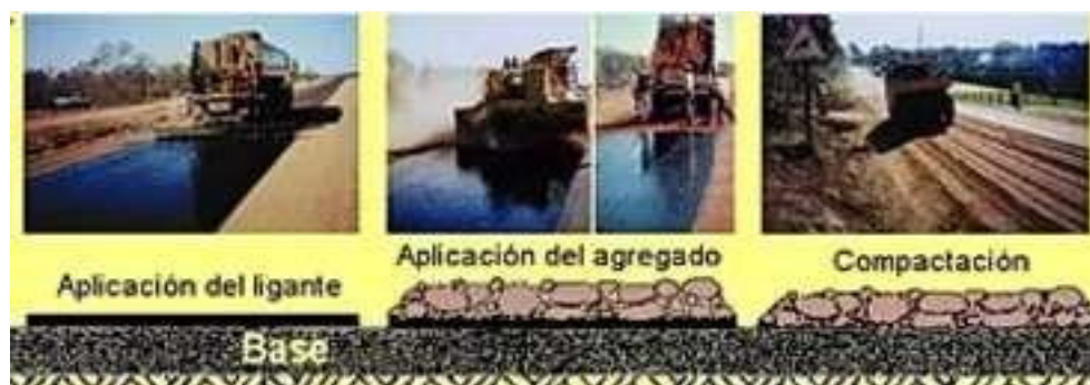
Ilustración 7: Proceso Constructivo Otta Seal
