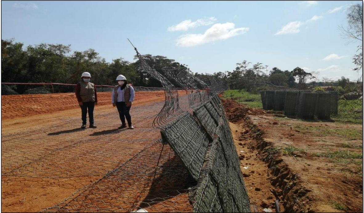
FOTO N°03: Se observa en la imagen la construcción del suelo reforzado, con relleno de suelo A- 2- 4 colocando mallas de gaviones en capas de 50 cm.
