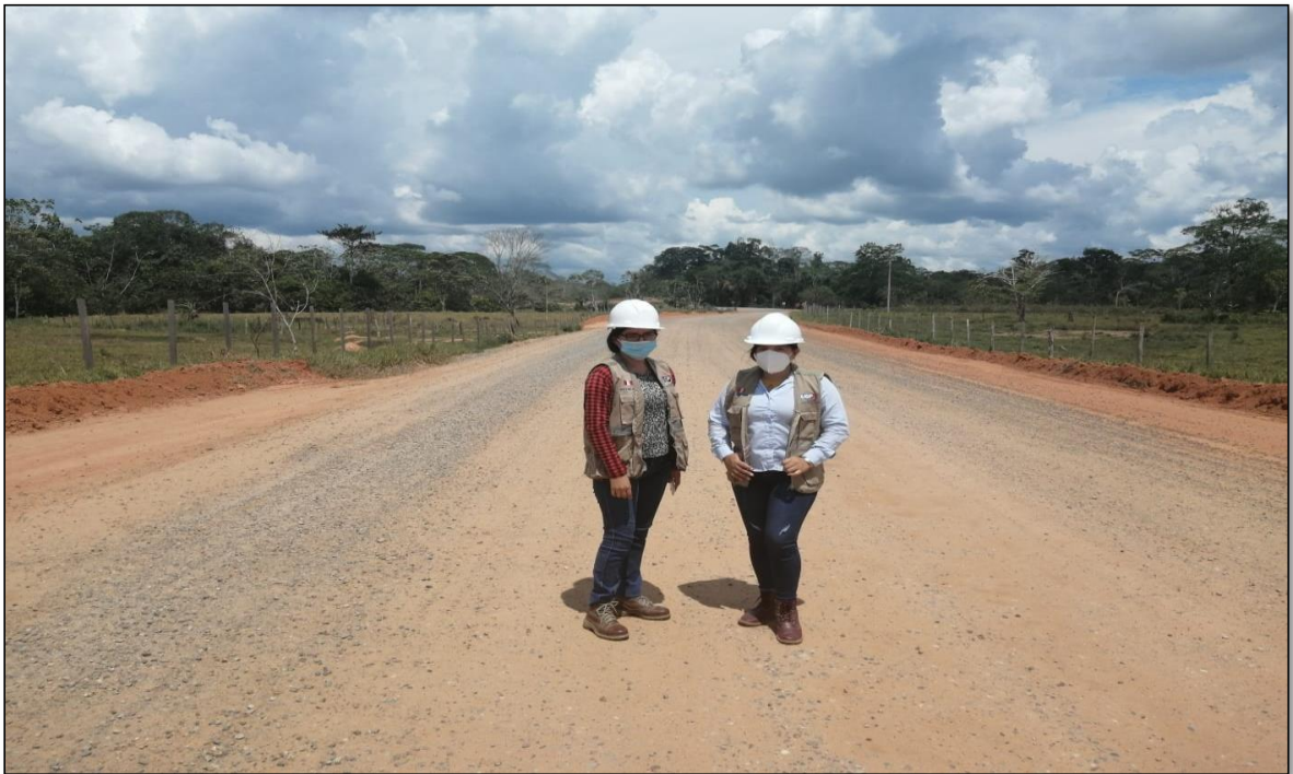
FOTO N°06: Se observa en la imagen la base de la capa de rodadura para luego poner la carpeta asfáltica.
