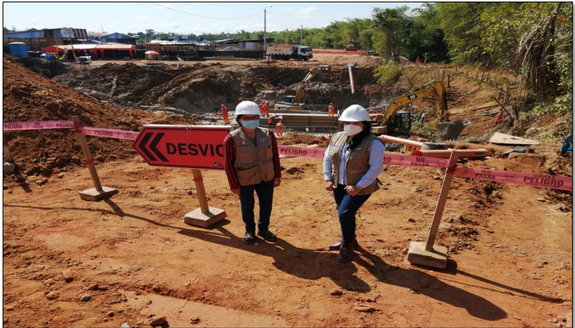
FOTO N°01: En la imagen se observa la excavación y la cimentación de una alcantarilla de gran luz.
