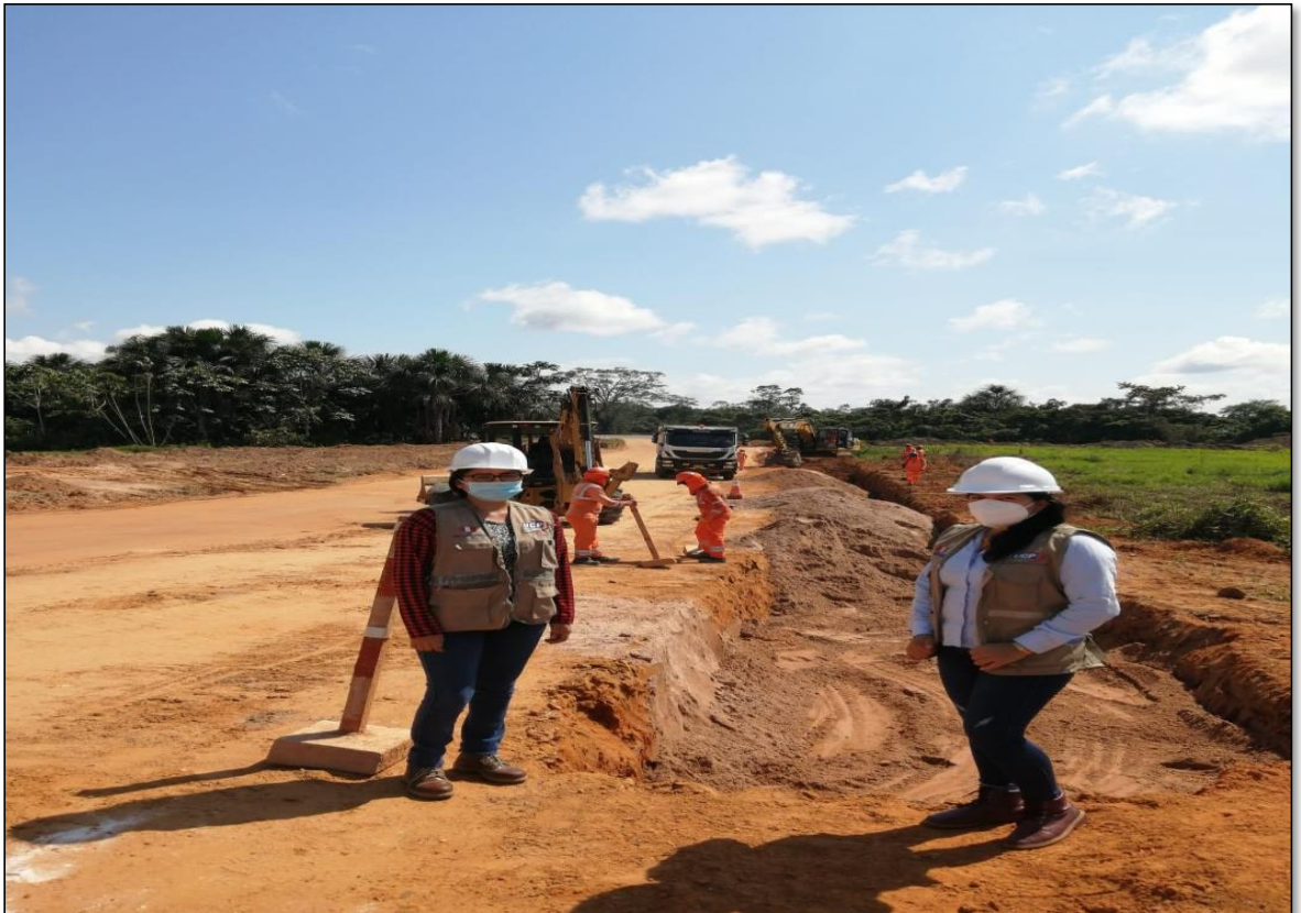
FOTO N°04: Se observa en la imagen el mejoramiento del suelo con material de arena.
