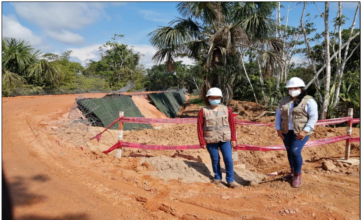
FOTO N°02: En la imagen se observa la construcción de suelos reforzados con geosintéticos, gaviones y terramesh.
