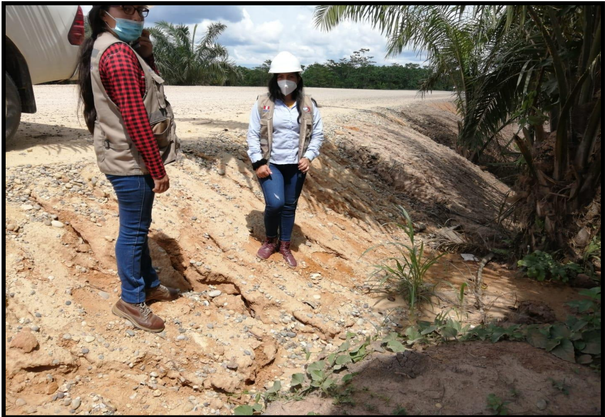
FOTO N°08: Se observa en la imagen la dispersión de suelos, es por ellos que se está haciendo la protección de taludes con geosintéticos, gaviones y terramesh.
