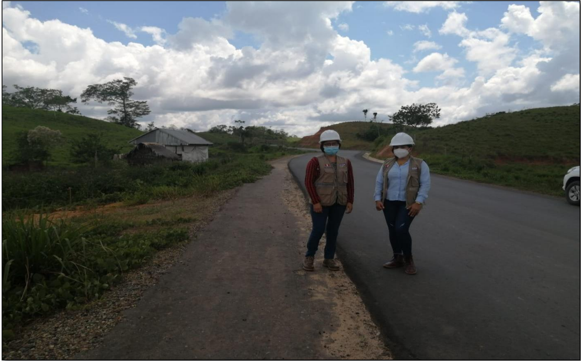
FOTO N°07: Se observa en la imagen el avance de la carpeta asfáltica de 3" (7.5cm).
