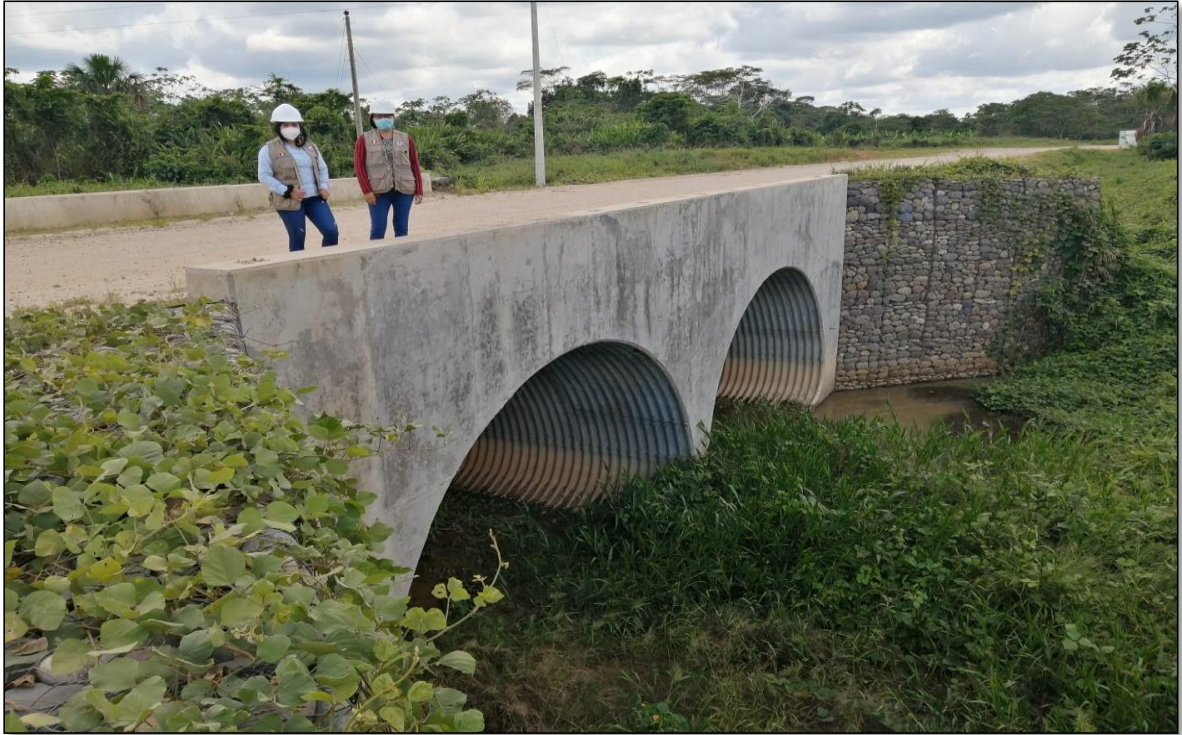
FOTO N°05: Se observa en la imagen las alcantarillas abovedadas de dos ojos.
