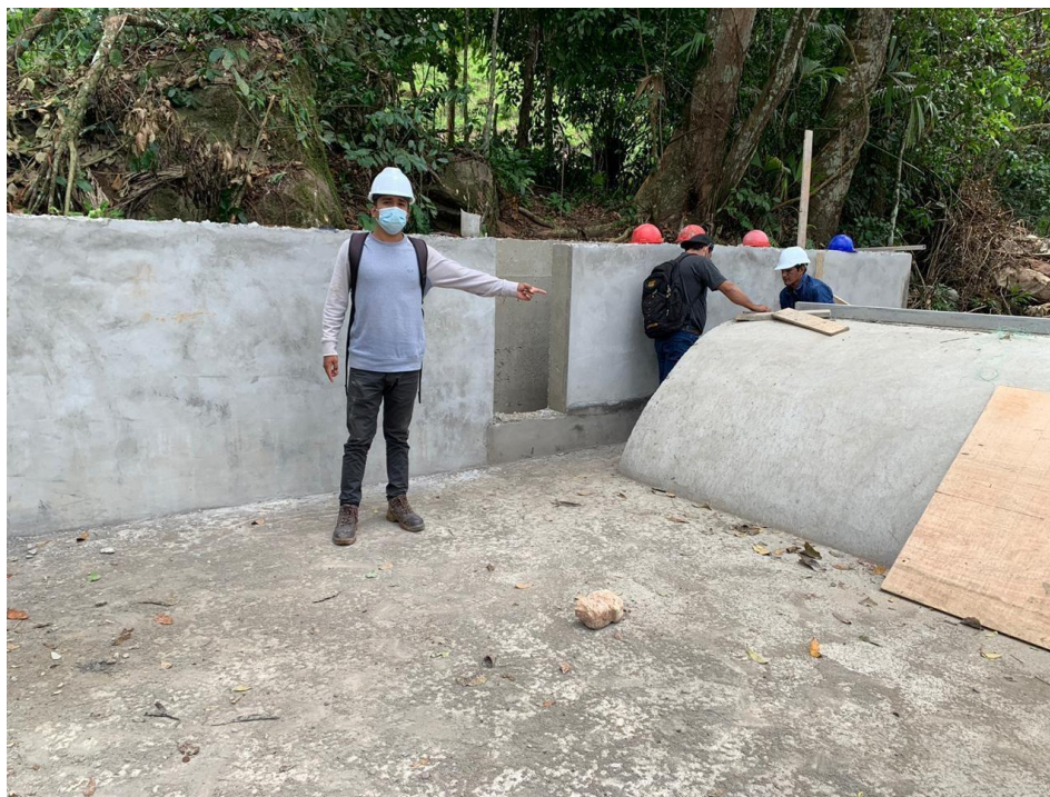
Acabados de la captacion tipo barraje
