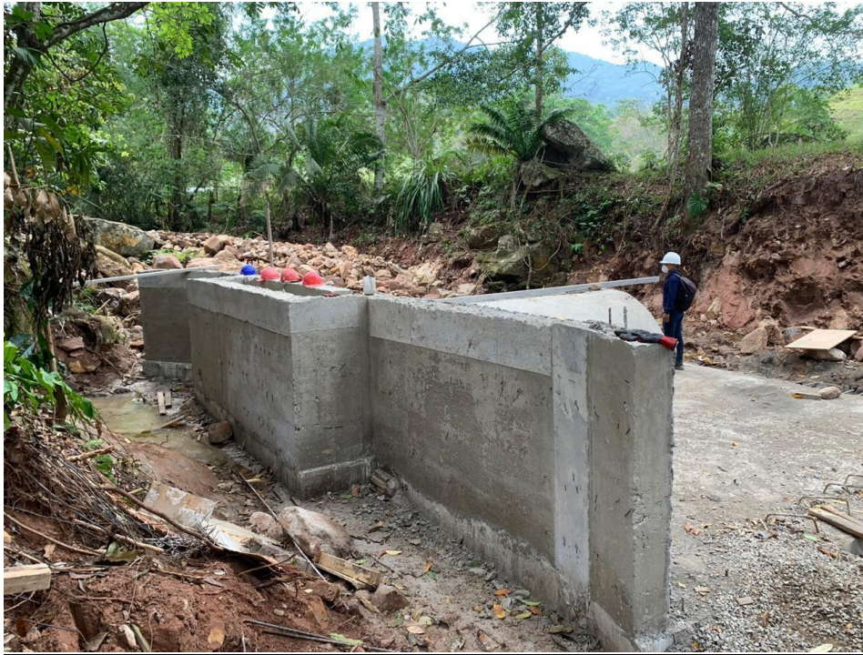
Desenfofrado de todas las partes que pertenecen a la captacion tipo barraje
