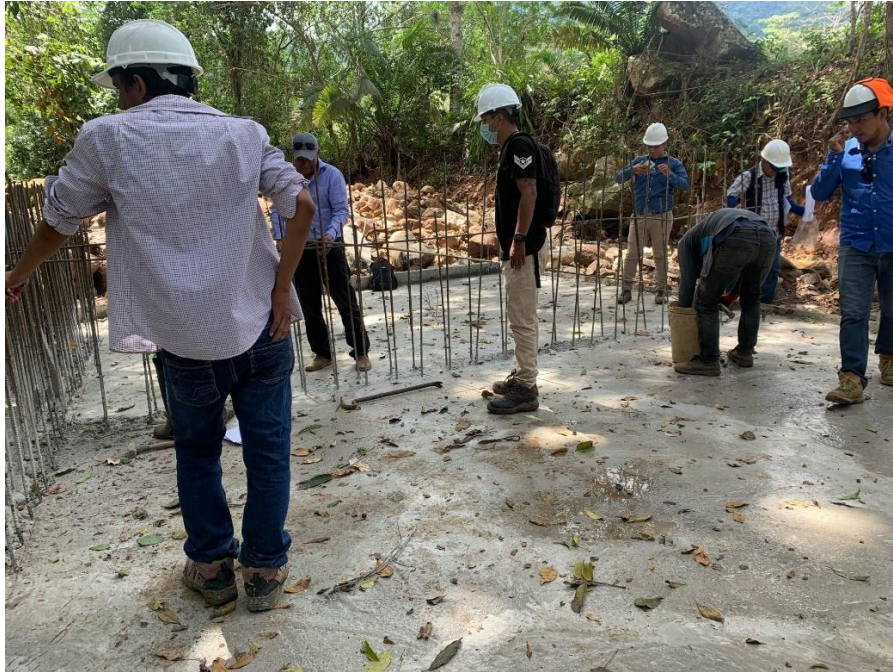
Proceso de armado del barraje, encima de la cimentación para su posterior encofrado.
