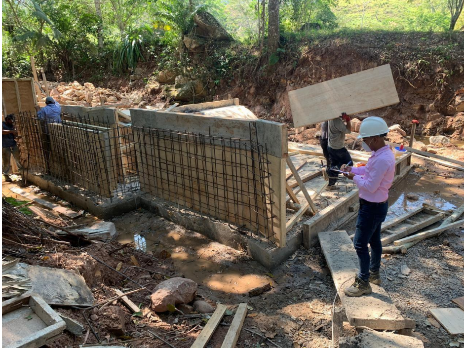
Desenfofrado de los muros laterales
