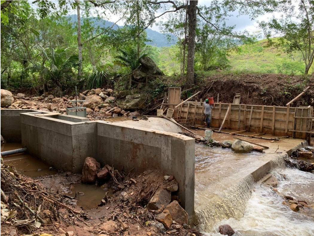
En siguiente imagen se puede observar como ya ha sido puesto en prueba todo lo que concierne a captación tipo barrage.
