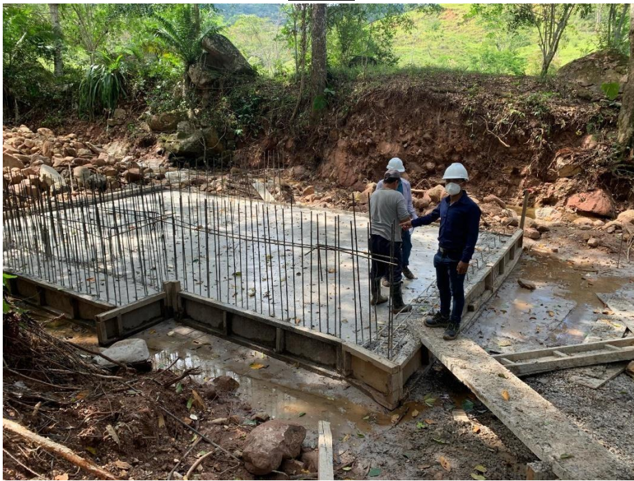
Armatura de los muros de la captacion tipo barraje.
