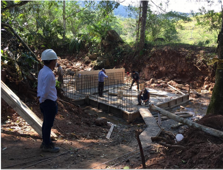
Encofrado del barrage para su posterior vaciado de concreto
