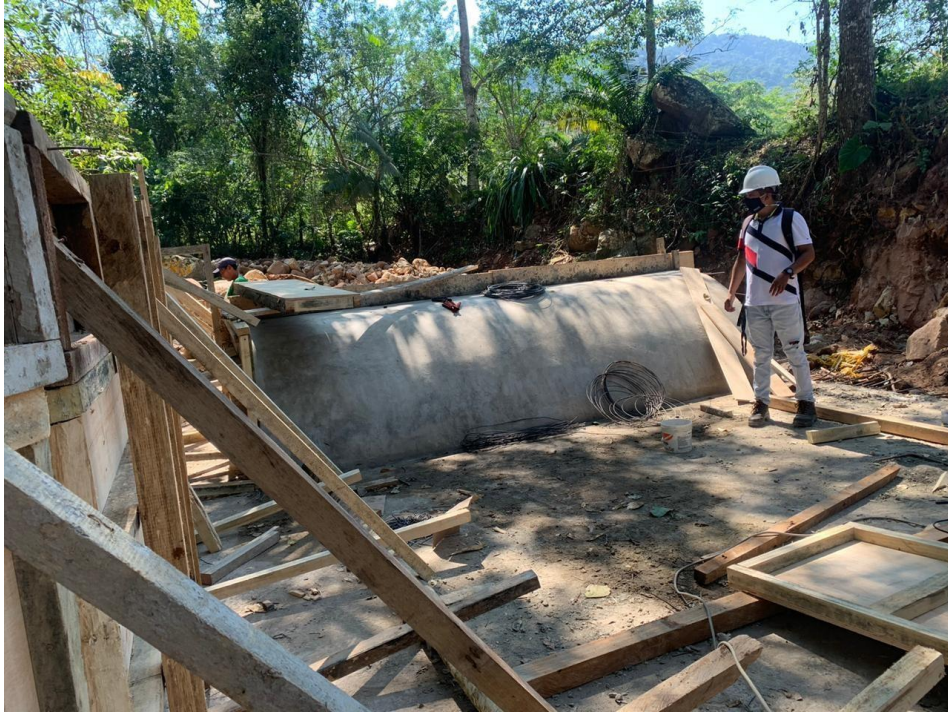
Desenfofrado del barraje, paralelo al encofrado de los muros
