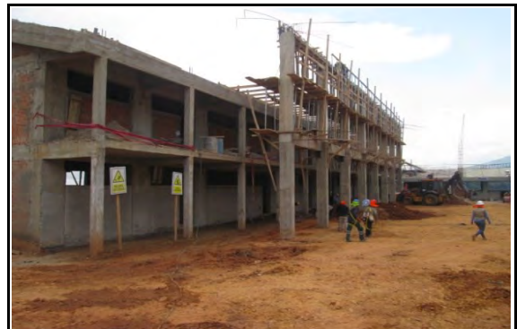
Fotografía N° 04.- Vista panorámica de la Edificación N° 02 materia de estudio al 20-09-2019
