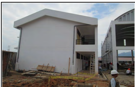
Fotografía N° 17.- Vista panorámica de la Edificación N° 02 materia de estudio al 13-02-2020
