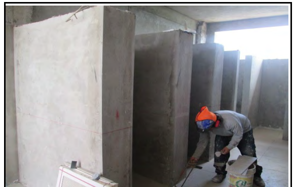
Fotografía N° 22.- Vista de trabajos en partida de enchapado de porcelanato en pisos, seleccionada para evaluación.
