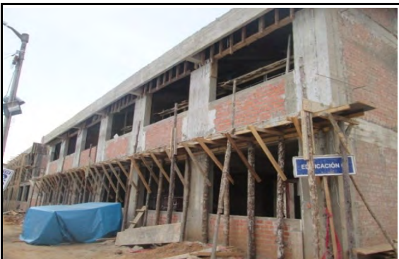
Fotografía N° 03.- Vista panorámica de la Edificación N° 02 materia de estudio al 20-09-2019
