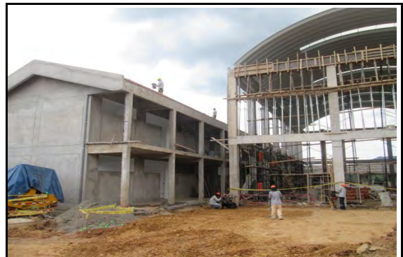
Fotografía N° 10.- Vista panoramica de la Edificación N° 02 materia de estudio al 29-11-2019
