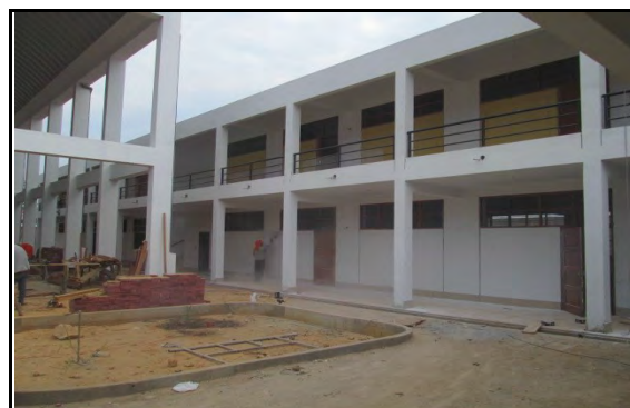
Fotografía N° 18.- Levantamiento de información en partidas de acero, encofrado, concreto zapatas y vigas de cimentación y columnas. Semana 3 (29-11-19).
