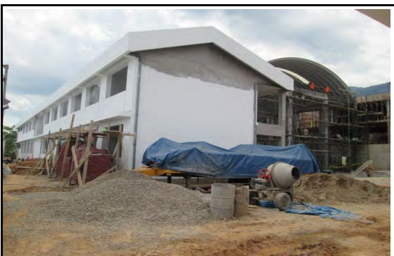
Fotografía N° 11.- Vista panoramica de la Edificación N° 02 materia de estudio al 11-12-2019
