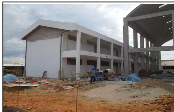
Fotografía N° 14.- Vista panorámica de la Edificación N° 02 materia de estudio al 16-01-2020
