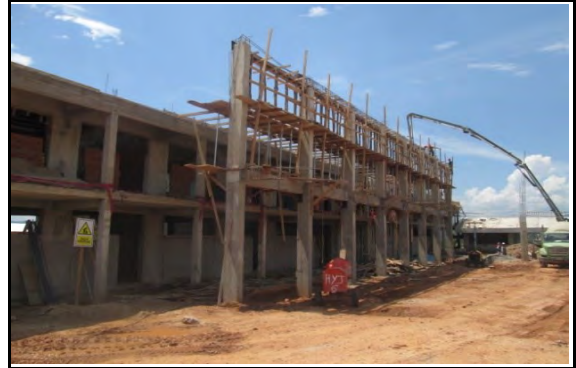
Fotografía N° 02.- Vista panorámica de la Edificación N° 02 materia de estudio al 09-09-2019
