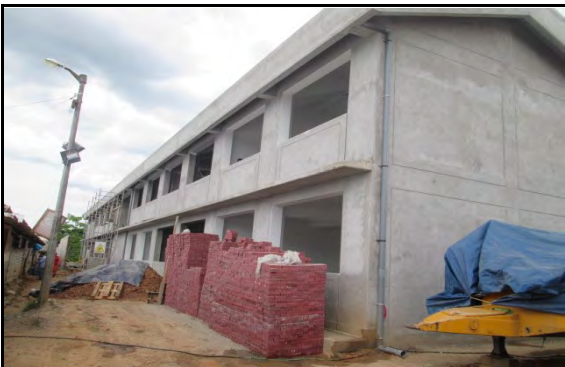
Fotografía N° 09.- Vista panoramica de la Edificación N° 02 materia de estudio al 29-11-2019
