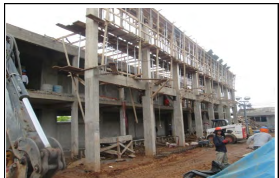
Fotografía N° 06.- Vista panorámica de la Edificación N° 02 materia de estudio al 03-10-2019
