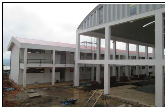
Fotografía N° 16.- Vista panorámica de la Edificación N° 02 materia de estudio al 30-01-2020.
