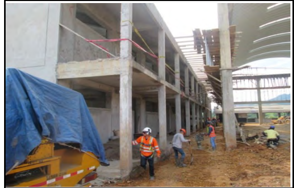
Fotografía N° 08.- Vista panoramica de la Edificación N° 02 materia de estudio al 08-11-2019
