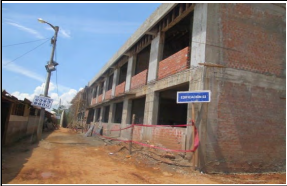
Fotografía N° 01.- Vista panorámica de la Edificación N° 02 materia de estudio al 09-09-2019
