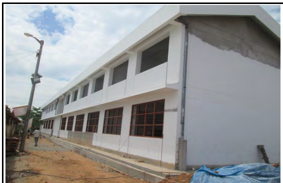
Fotografía N° 13.- Vista panorámica de la Edificación N° 02 materia de estudio al 16-01-2020
