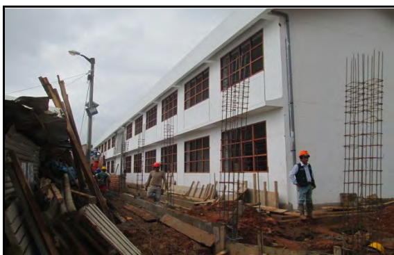
Fotografía N° 15.- Vista panorámica de la Edificación N° 02 materia de estudio al 30-01-2020
