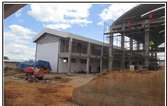
Fotografía N° 12.- Vista panoramica de la Edificación N° 02 materia de estudio al 11-12-2019
