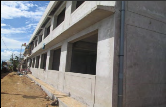
Fotografía N° 07.- Vista panoramica de la Edificación N° 02 materia de estudio al 08-11-2019
