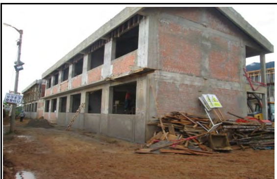
Fotografía N° 05.- Vista panorámica de la Edificación N° 02 materia de estudio al 03-10-2019
