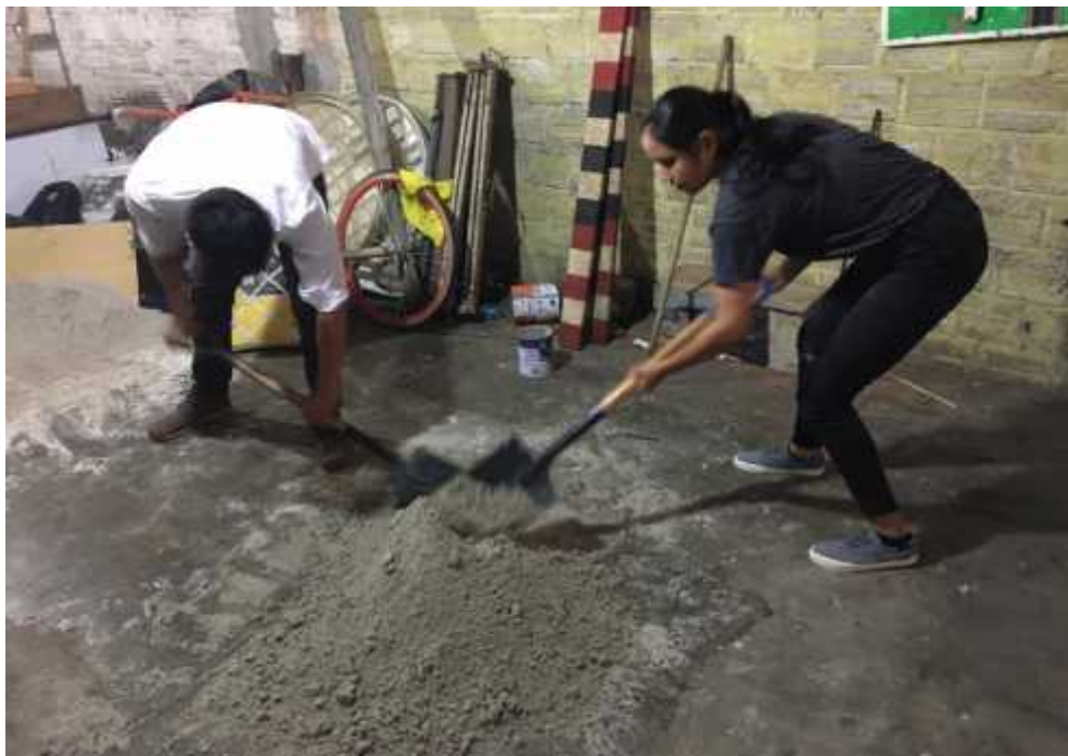
Remoción de mezcla
