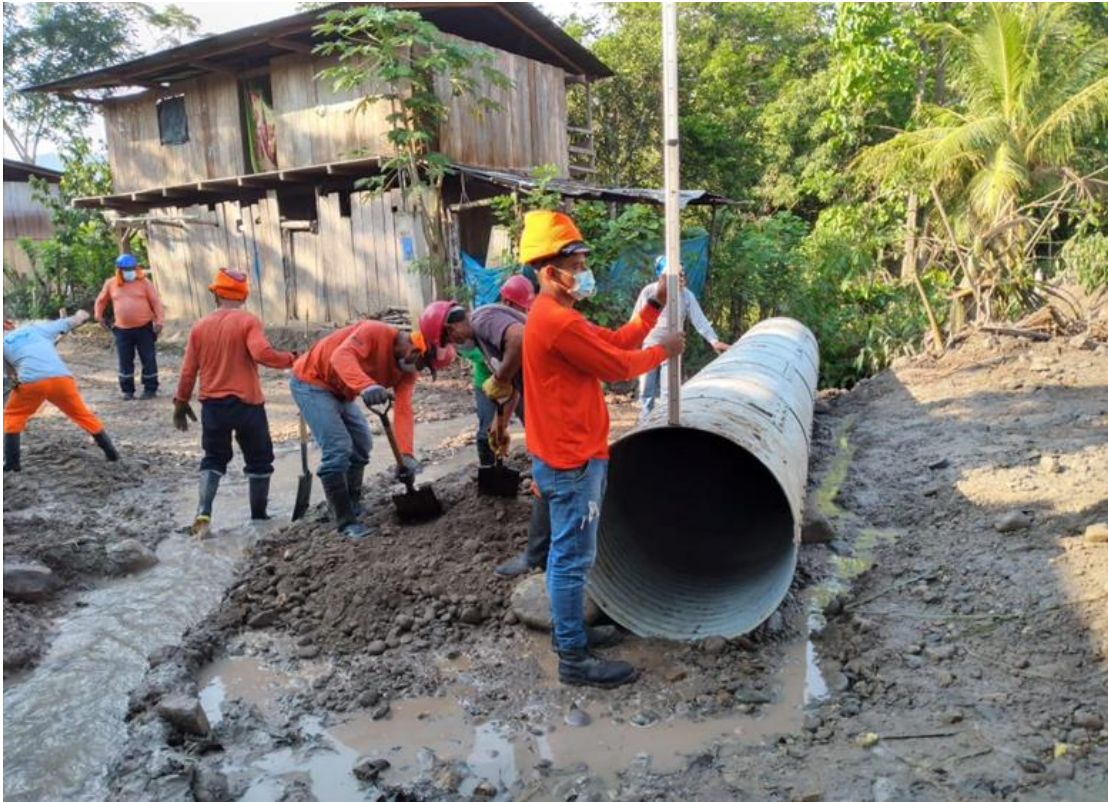
NIVELACIÓN PARA LA COLOCACIÓN DE LA ALCANTARILLA
