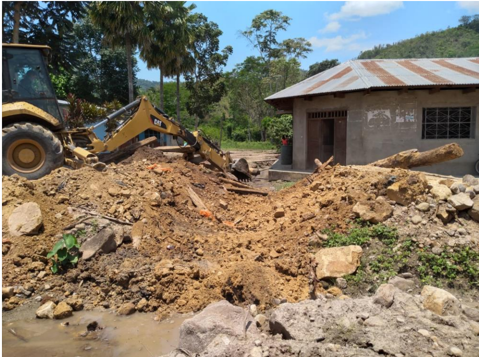
EXCAVACION DEL TERRENO NATURAL
