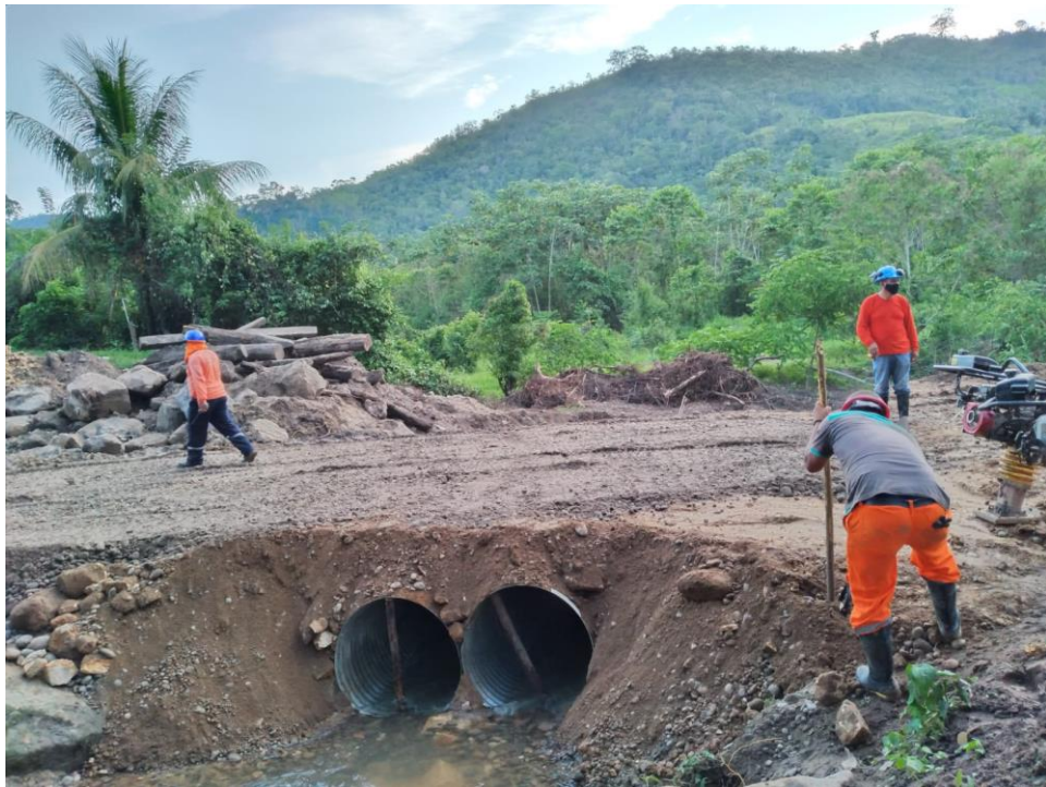
COLOCAIÓN DE LAS ALCANTARILLAS CONCLUIDA
