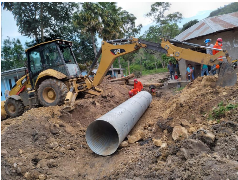
COLOCACIÓN DE ALCANTARILLA TMC Ø 36" C=12
