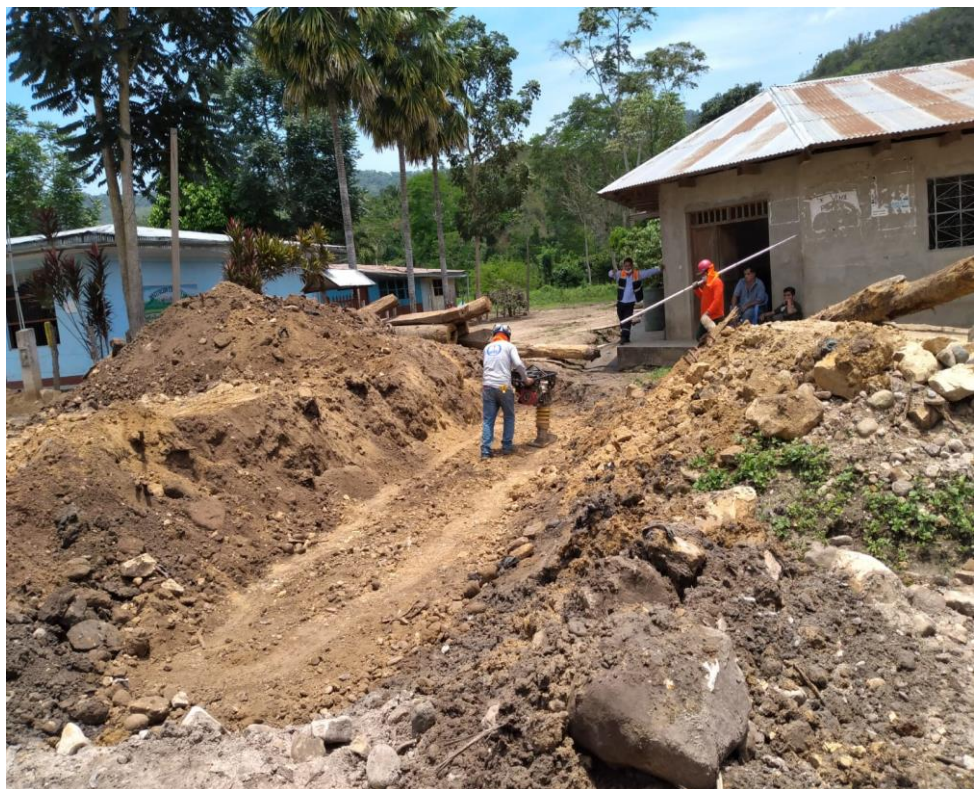
COMPACTACIÓN DEL TERRENO NATURAL
