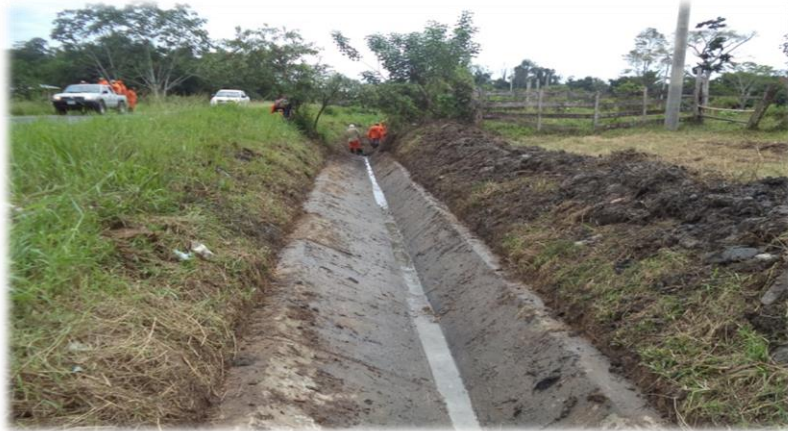
Foto N° 04: Limpieza de Cunetas, Carretera Iquitos – Nauta
