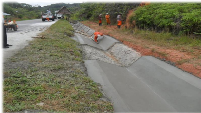
Foto N° 06: Reparación de Cunetas, Carretera Iquitos - Nauta
