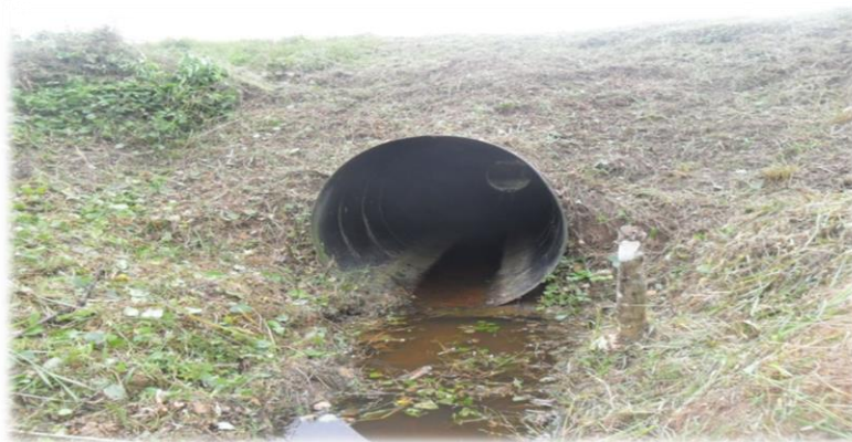
Foto N° 05: Limpieza de Alcantarillas, Carretera Iquitos - Nauta
