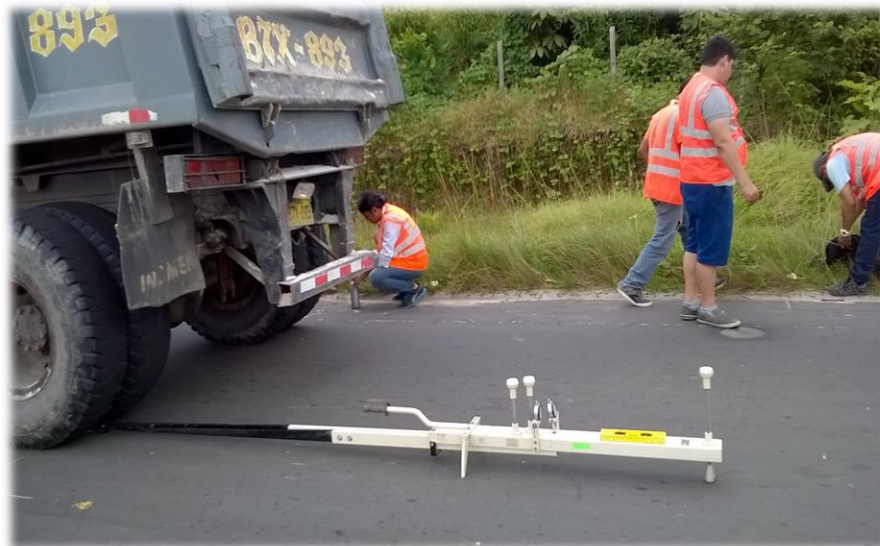
Foto N°10 : Colocación de la Regla en el Punto de ensayo, Elaboración Propia
