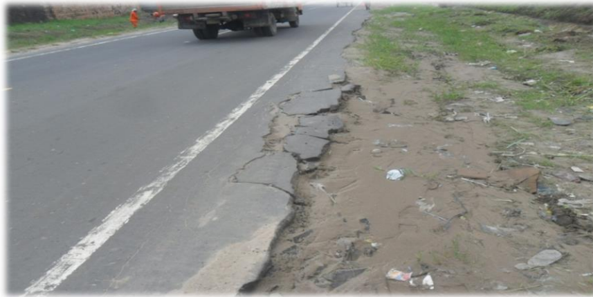
Foto N° 07: Berma en Tramo I, Carretera Iquitos - Nauta
