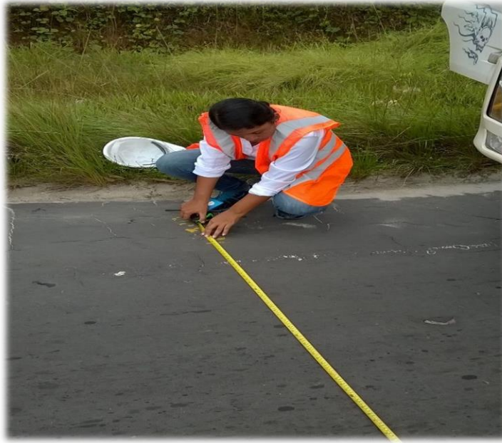
Foto N°09 : Medición y Trazado de Línea Transversal en el Punto de Ensayo, Elaboración Propia
