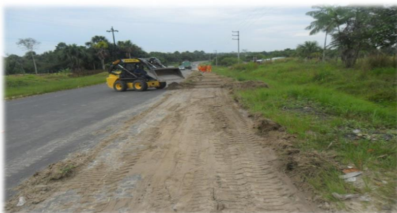
Foto N° 03: Perfilado de Derecho de Vía, Carretera Iquitos - Nauta
