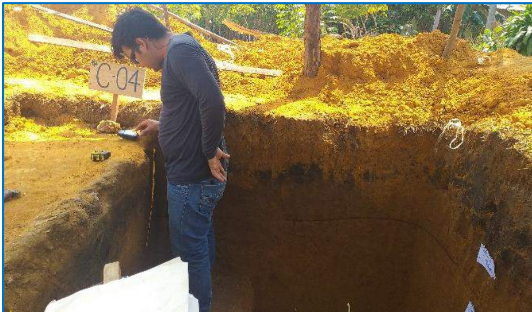
FOTO N° 16. Toma de coordenadas.
