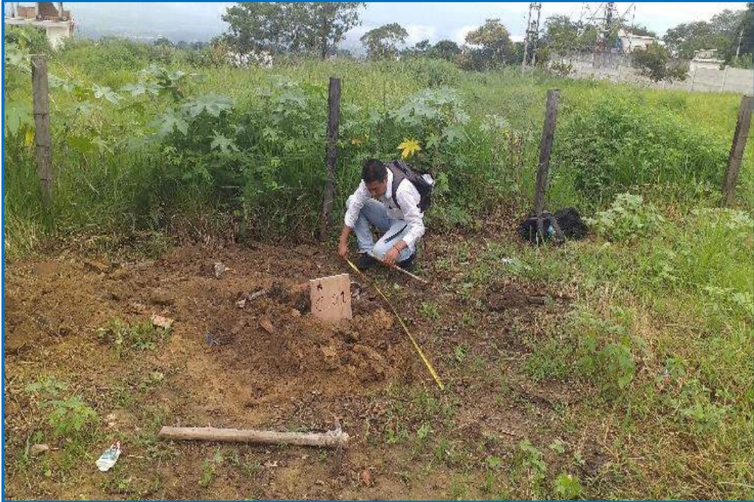
FOTO N° 01 .Trazo para excavación.
