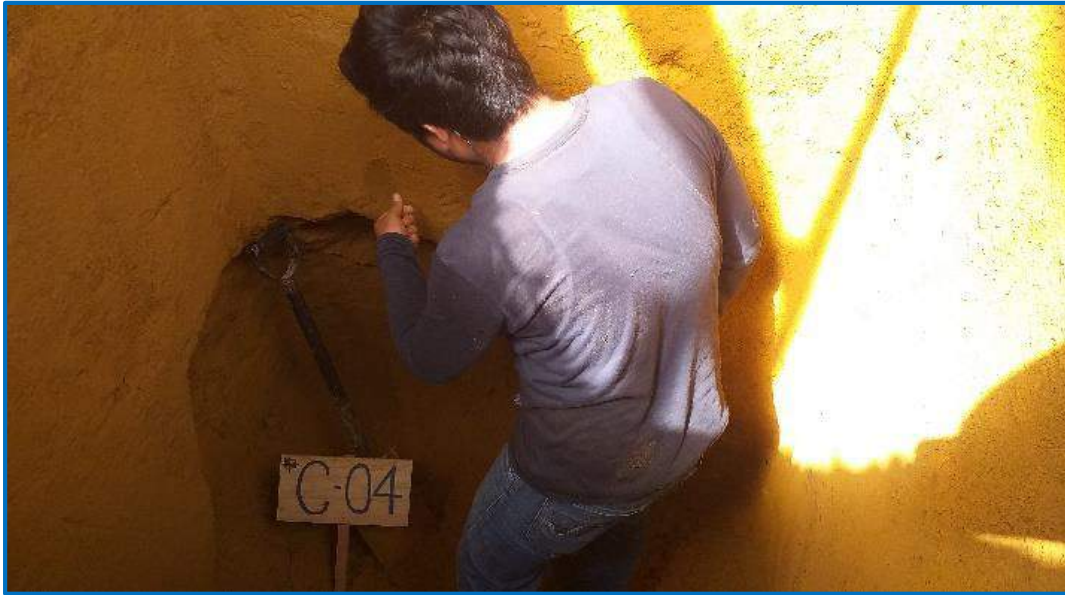
FOTO N° 09. Verificando la consistencia del suelo.
