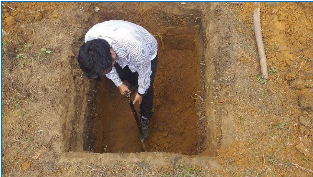
FOTO N° 02 .Excavación de calicata.
