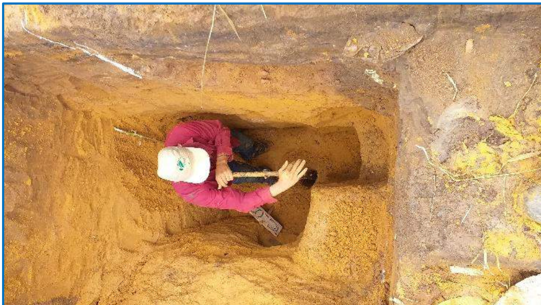
FOTO N° 03. Excavación a partir de 3m de profundidad con perforador manual.
