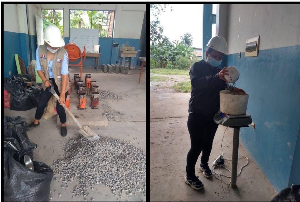
FOTOGRAFÍA N° 22 - VISTA FOTOGRÁFICA DONDE SE MUESTRA LA PREPARACIÓN DE LOS MATERIALES PARA LA ELABORACIÓN DE LAS PROBETAS.
