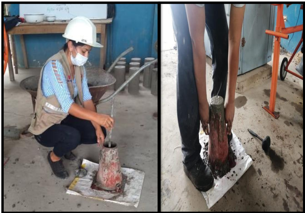
FOTOGRAFÍA N° 24 - VISTA FOTOGRÁFICA DONDE SE MUESTRA EL ENSAYO AL CONCRETO FRESCO
