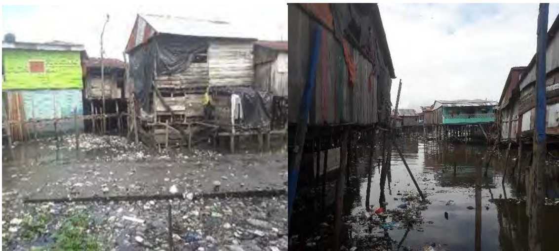
GRÁFICO N° 15: FOTOGRAFIA DEL ESTADO ACTUAL DE LA QURBRADA SACHACHORRO Y LAS VIVIENDAS.
