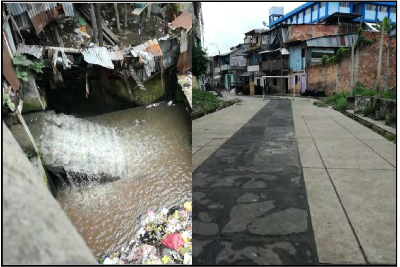
FIGURA 1 Y 2: ESTADO ACTUAL DE LA QUEBRADA SACHACHORRO
