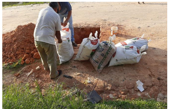
Foto N°06: Excavación Calicata 02
