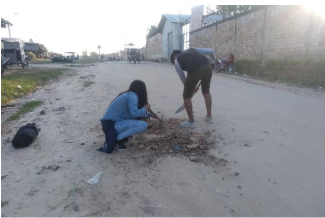
Foto N°03: Excavación Calicata 01
