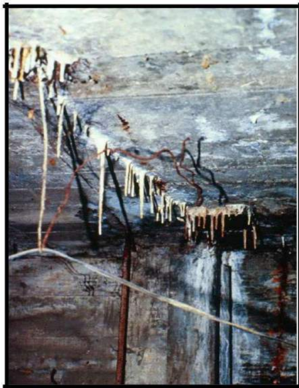
Ilustración 3: Pérdida de sección de acero útil.
