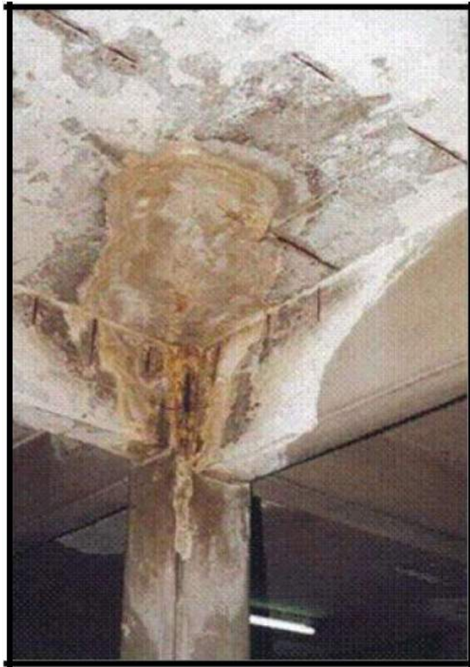
Ilustración 3: Pérdida de sección de acero útil.
