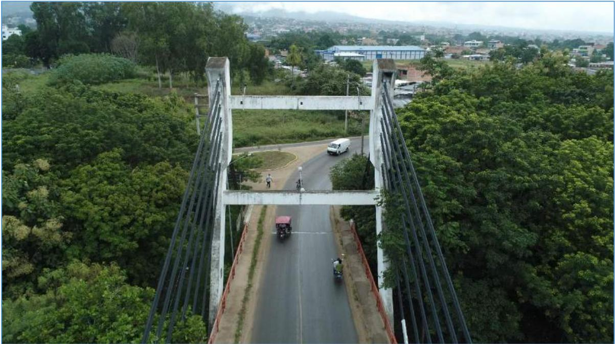
*Fotografía N° 52. Vista aérea de los tirantes en la margen izquierda del puente Atumpampa.*
