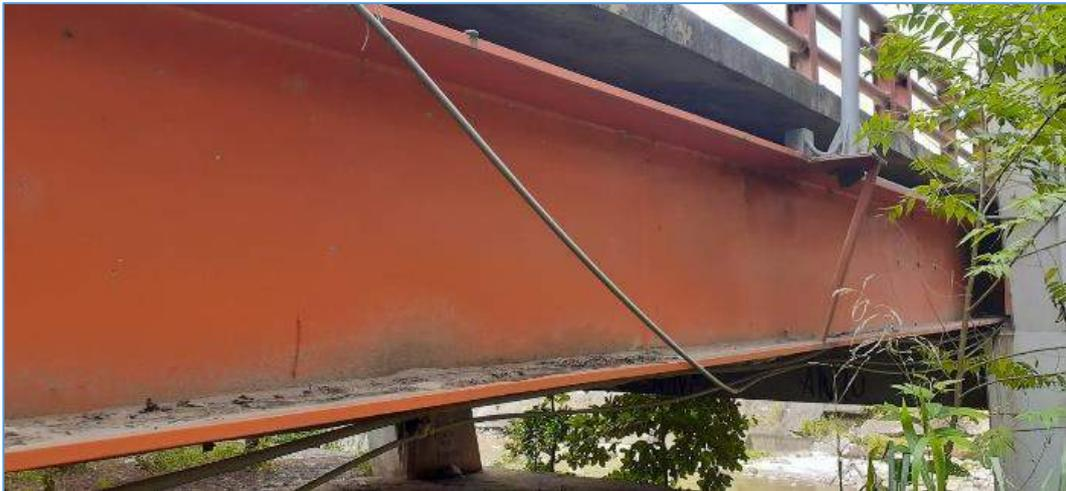
***Fotografía N° 5. Se observa acumulación de sedimentos de arena en las alas de la viga principal.***
