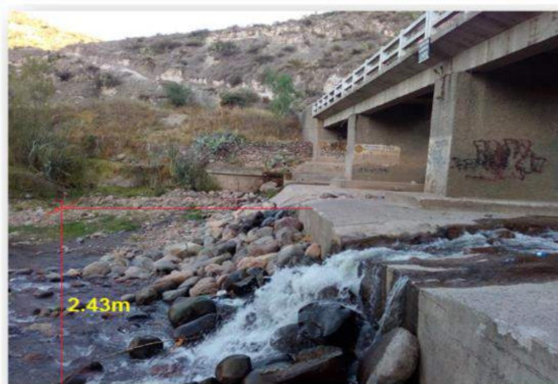
Figura 6.1: Profundidad de socavación en el puente Huatatas .
