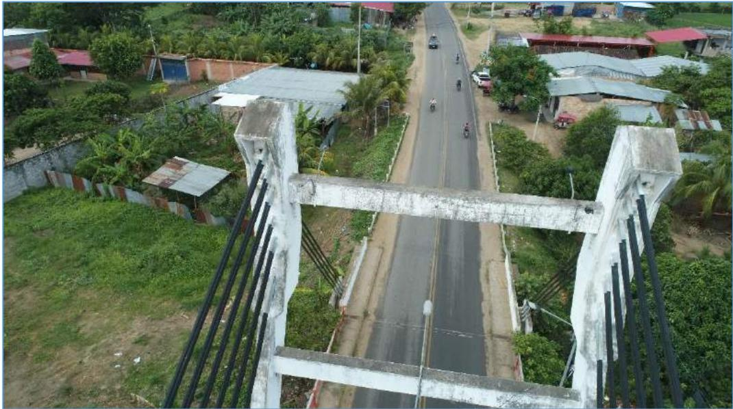
***Fotografía N° 19. Vista aérea de los tirantes conectados a la torre de la margen derecha con dispositivos de anclajes activos.***
