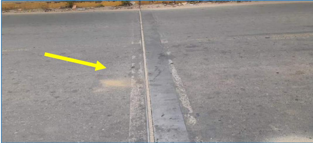
***Fotografía N° 29. Se observa plancha deslizante en la margen derecha del puente***
