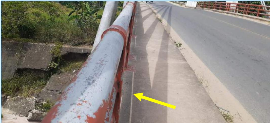
***Fotografía N° 32. Se observa oxidación intermedia del acero en las barandas.***
