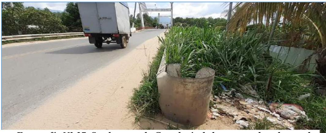
***Fotografía N° 37. Se observa a la Guardavía de la margen derecha con la estructura colapsada y presencia de suciedad y malezas***
