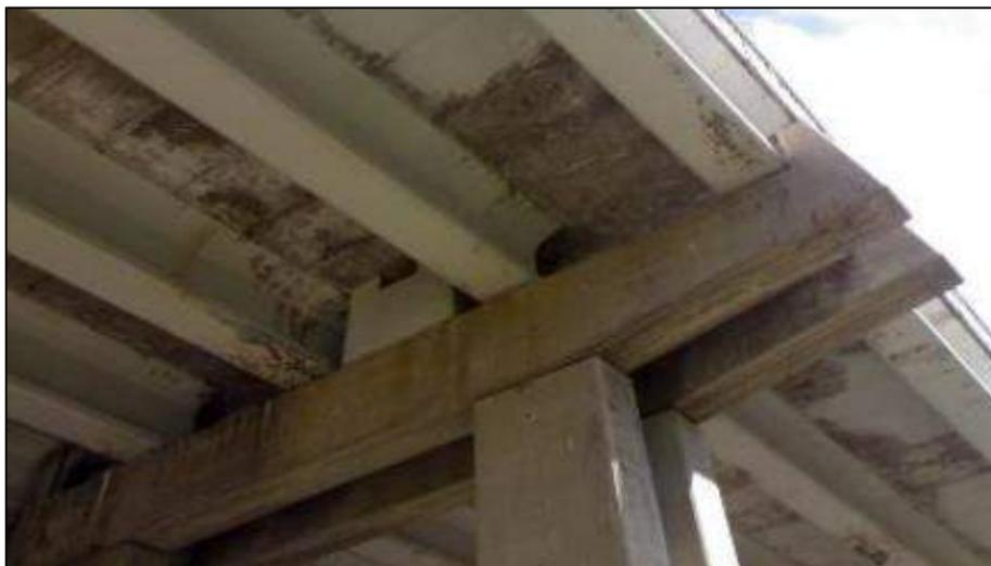
*Imagen N° 3. Patologías Estructural de la viga*
