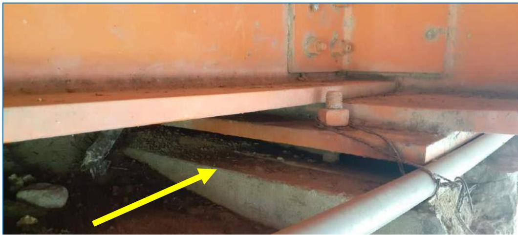
*Fotografía N° 27. Se puede observar el apoyo móvil tipo rodillo en la torre de la margen derecha*
