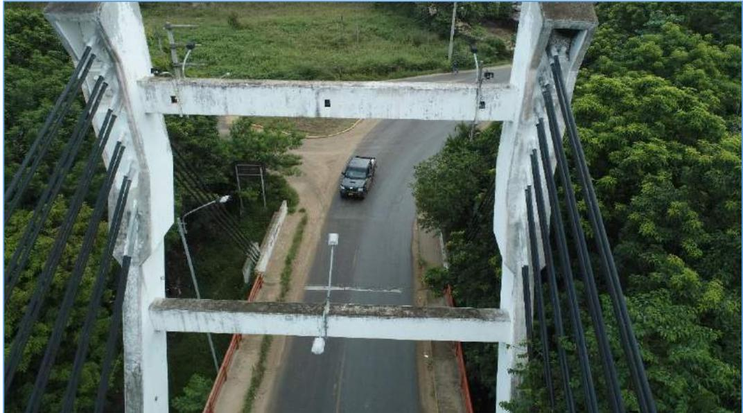
*Fotografía N° 20. Vista aérea de los tirantes conectados a la torre de la margen izquierda con dispositivos de anclajes activos.*
