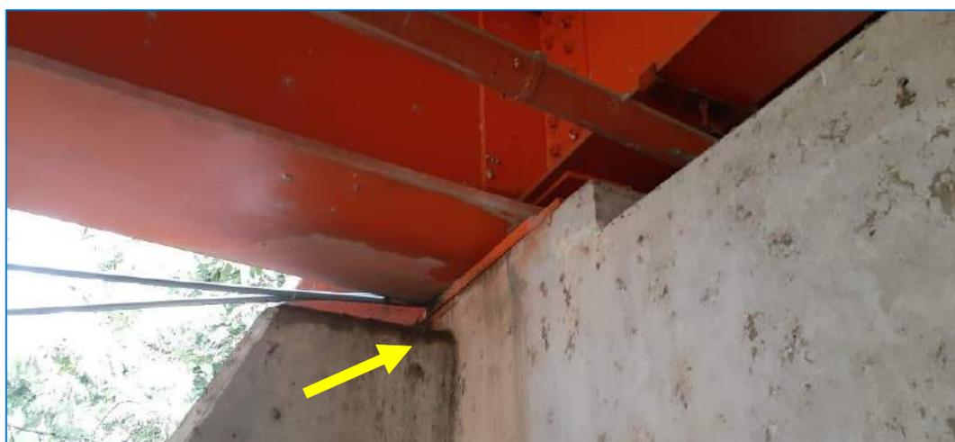
*Fotografía N° 28. Se puede observar el apoyo fijo tipo basculante en la torre de la margen izquierda*
