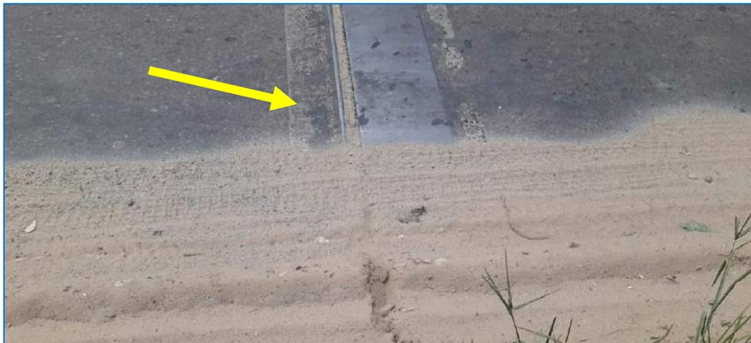
***Fotografía N° 30. Se observa sedimentos de arena y suciedad en la plancha deslizante en la margen derecha del puente***
