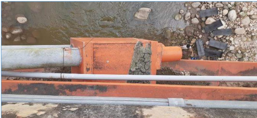
***Fotografía N° 7. Se observa dispositivos de anclaje en la viga principal con presencia de sedimentos de arena.***
