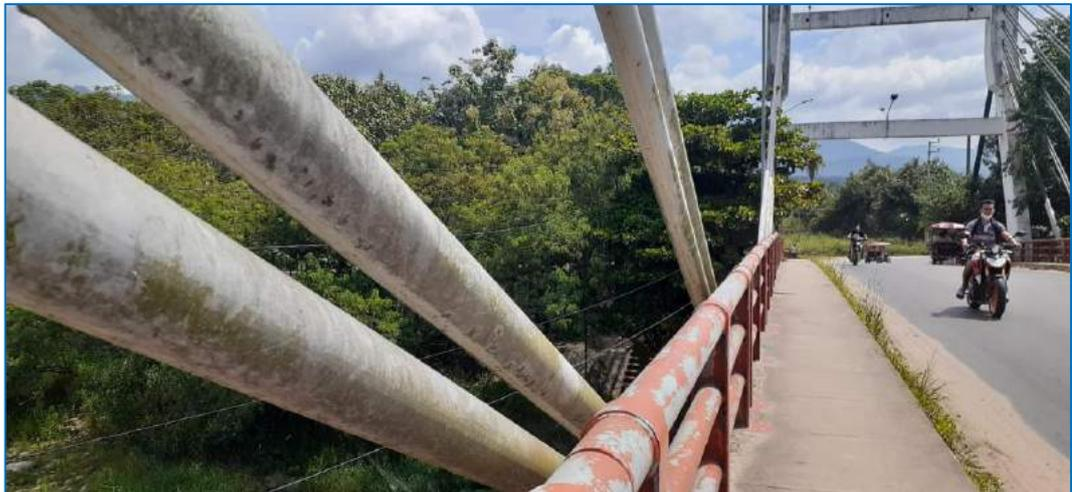
*Fotografía N° 21. Se observa las trompetas de los tirantes con desprendimiento de la pintura.*
