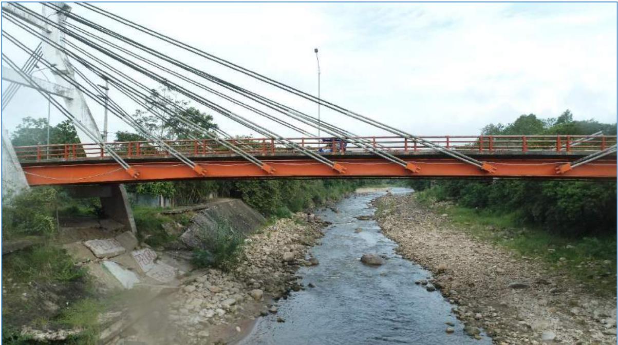
*Fotografía N° 51. Vista de la superestructura y tirantes del puente Atumpampa.*
