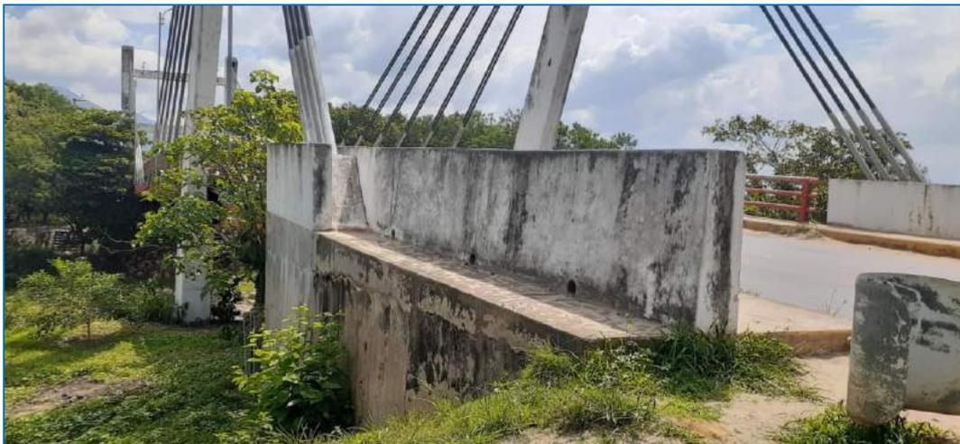
***Fotografía N° 15. Se observa eflorescencias y desprendimiento de pintura y eflorescencias en el anclaje – estribo en la margen derecha.***
