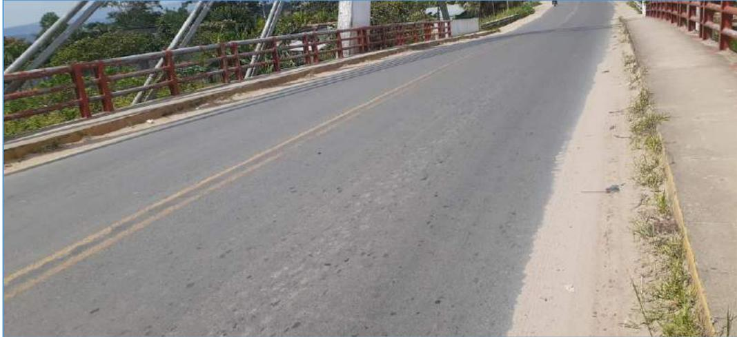
***Fotografía N° 42. Se observa desgaste de pintura en la señalización horizontal.***
