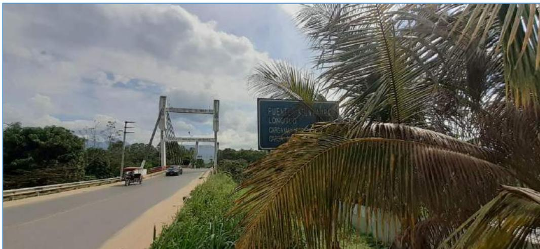
***Fotografía N° 45. Se observa falta de visión de señalización informativa en la margen derecha***
