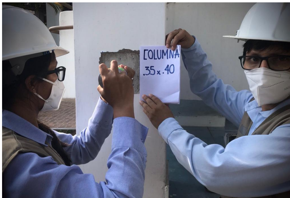
Ilustración 17: Ensayo de esclerometría aplicado a la columna de 35x40 cm
