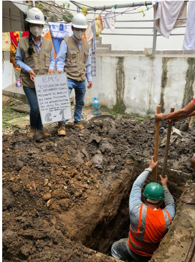
Ilustración 16: Calicata 01 - Ensayo de Mecánica de Suelos
