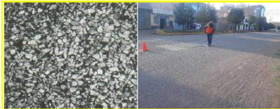
*Ilustración 15: Pulimiento de agregados. Fuente: Vásquez (2002)*
