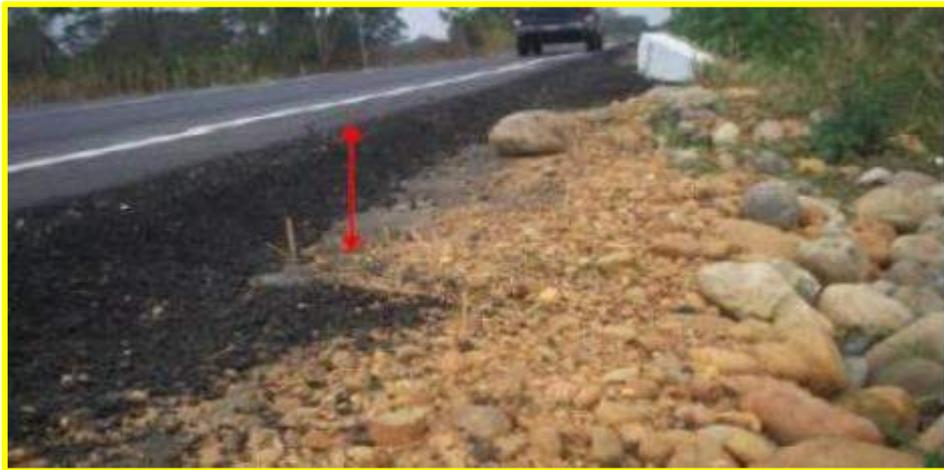
*Ilustración 12: Desnivel carril. Fuente: Corros et al. (2009)*
