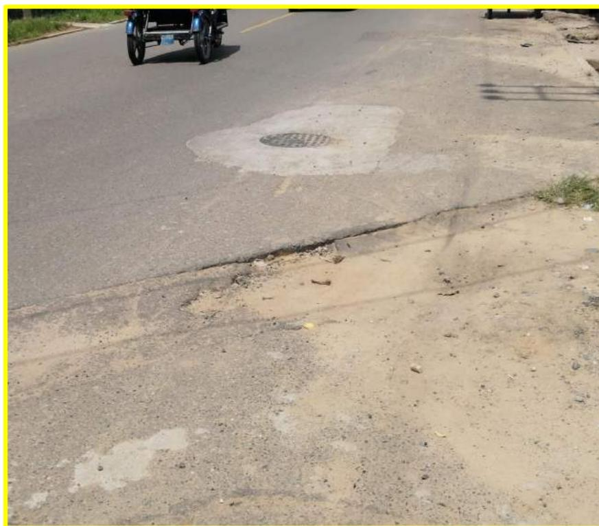
**Ilustración 7: Abultamientos y hundimientos de alta severidad. Fuente: Propia**
