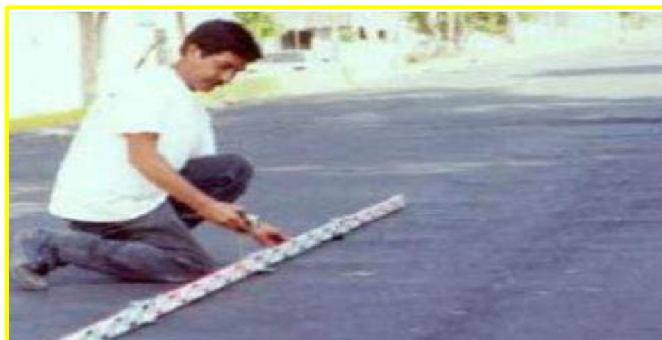
**Ilustración 8: Corrugación de baja severidad. Fuente: Vásquez (2002)**
