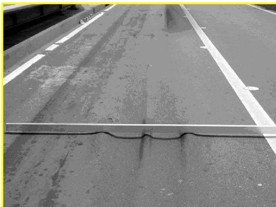
*Ilustración 16: Ahuellamiento alta severidad.*
