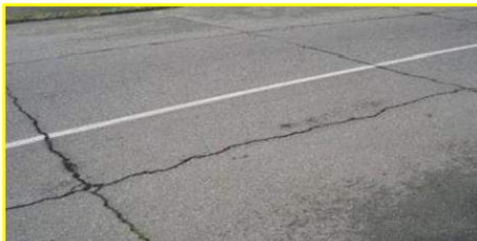
*Ilustración 11: Grieta de reflexión de junta de alta severidad. Fuente: Corros et al. (2009)*
