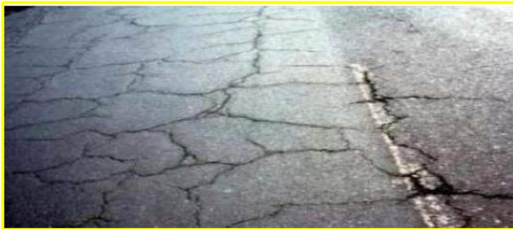
*Ilustración 6: Grietas en bloque de alta severidad. Fuente: INVIAS (2007)*
