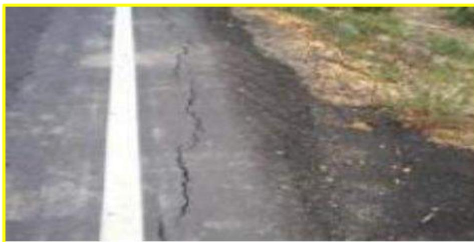
**Ilustración 10: Grieta de borde de baja severidad. Fuente: Corros, Urbáez y Corredor. (2009)**
