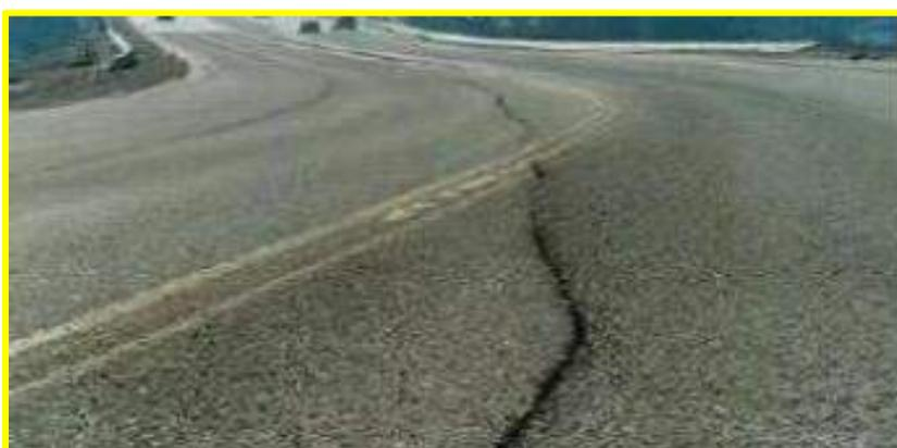
*Ilustración 13: Grietas longitudinales y transversales (No PCC) de baja severidad.
