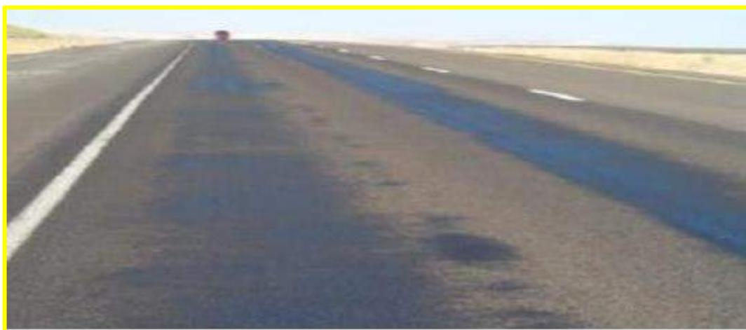
*Ilustración 5: Exudación en baja severidad. Fuente: Invias (2007)*
