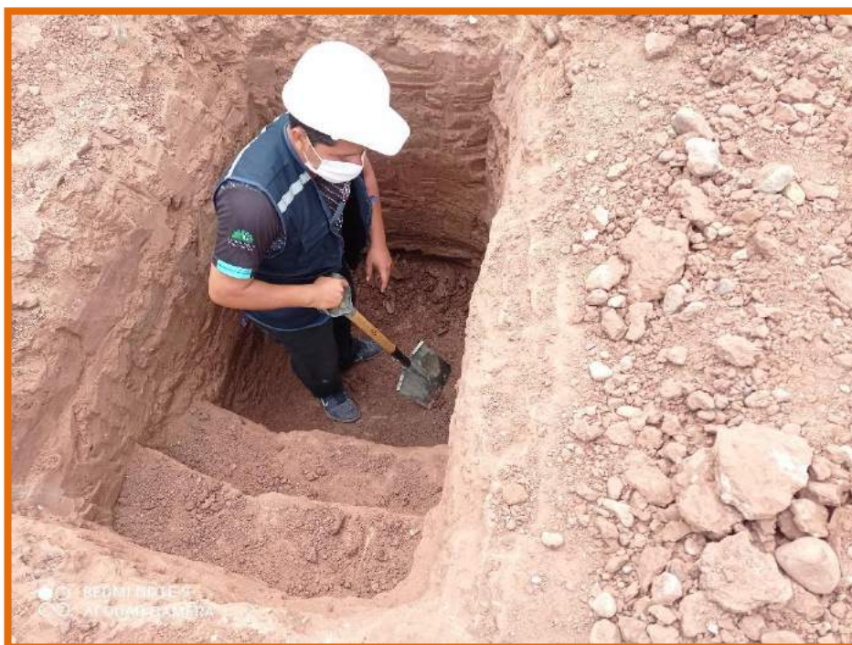
Img. N° 01: Excavación de calicatas
