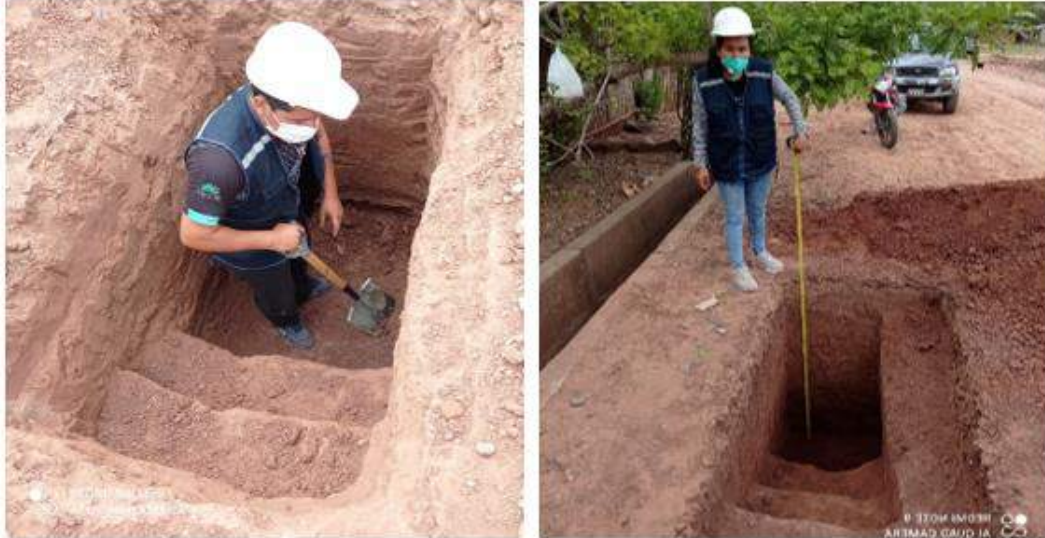
Figura 11: Excavación de calicatas
