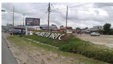
Foto N° 01: Actual explanada de buses
