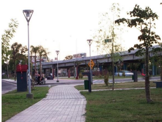
Imagen 20: Viaducto y paseo
