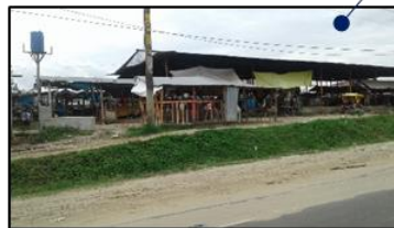
Foto N° 05: Mercadillo existente Fuente: Elaboración propia
