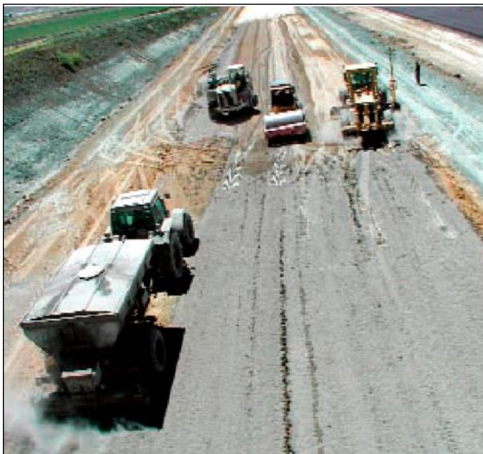
Ilustración 4: Estabilización de suelo con cemento.
