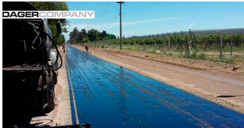
Ilustración 5: Estabilización de suelo con emulsión asfáltica.
