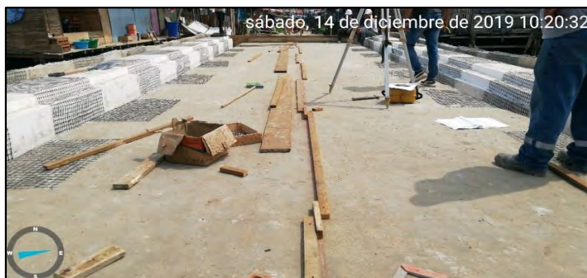
Imagen 88: Encofrado De Pavimento Rígido Fuente: Propia
