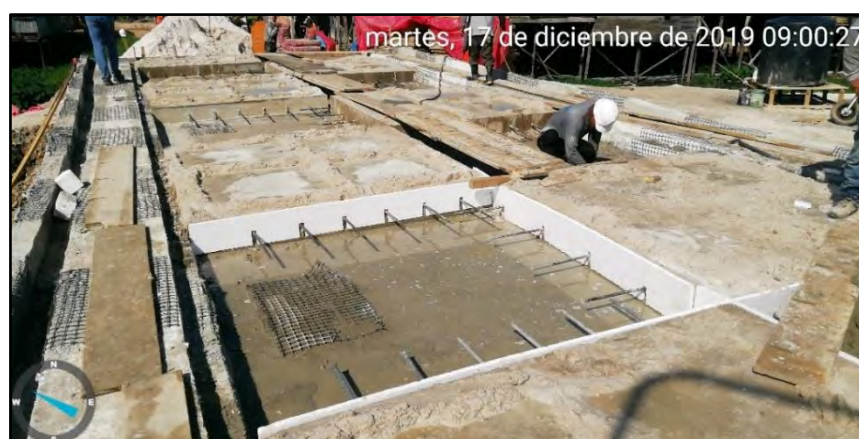
Imagen 90: Vaciado De Mortero F'C=210\text{kg}/\text{Cm}^2 En Losa De Rodadura (Etapa2) Fuente: Propia
