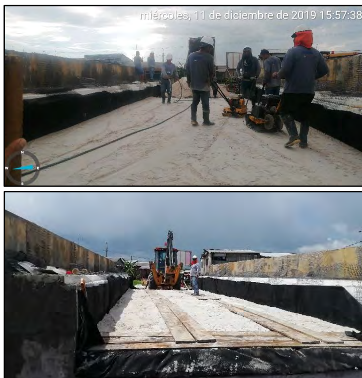
Imagen 83: Relleno Con Material De Préstamo Y Compactado Fuente: Propia
