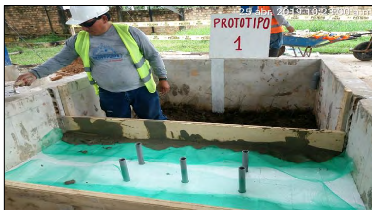
Imagen 25: Construcción del Prototipo 01 Fuente: Propia
