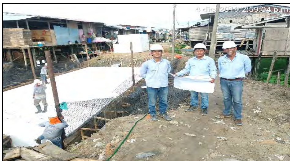
Imagen 76: Vaciado De Uña De Pantalla De Confinamiento Y Colocación De Capa N°01 De Geoespuma Fuente: Propia
