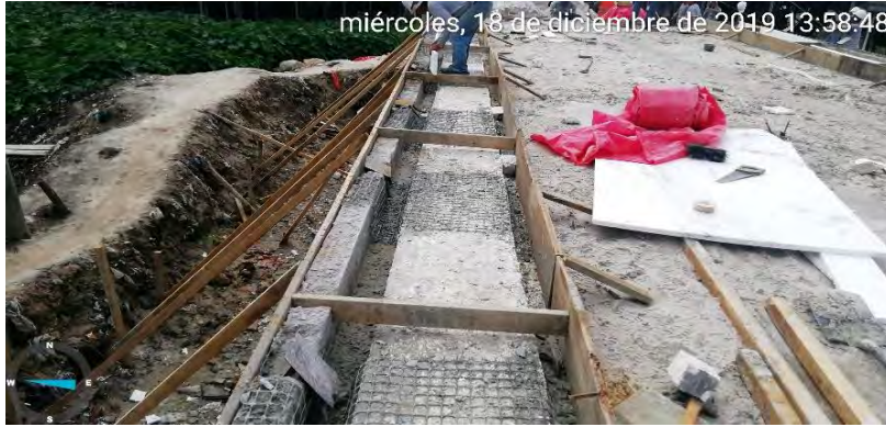
Imagen 91: Encofrado De Veredas Fuente: Propia
