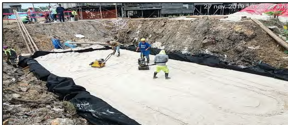
Imagen 70: Base del Terraplén Fuente: Propia
