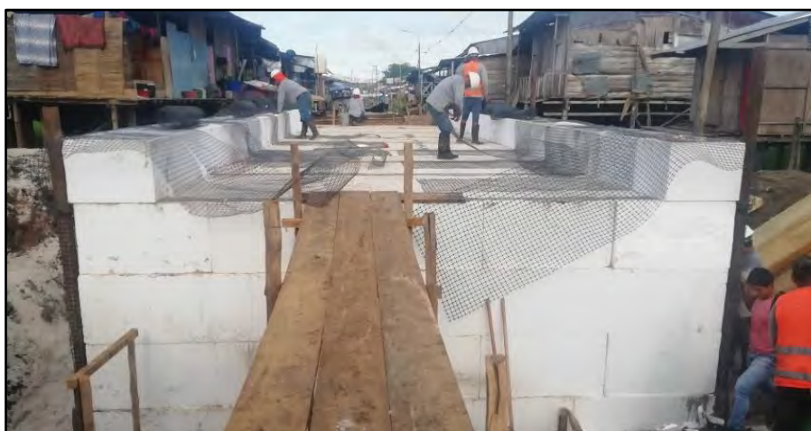
Imagen 79: Colocación De Bloques De Geoespuma En Veredas (Capa 01) Fuente: Propia
