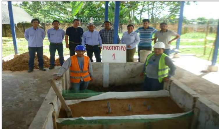
Imagen 26: Construcción del Prototipo 01 Fuente: Propia
