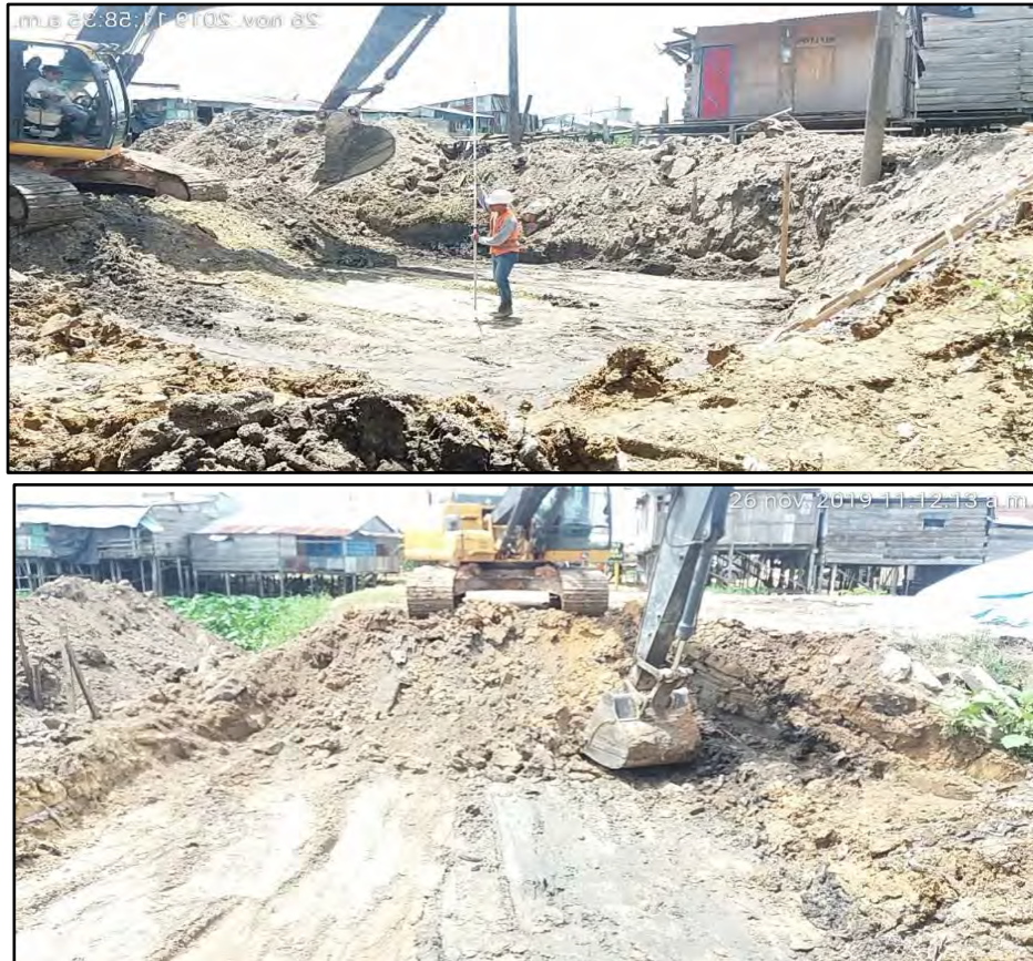
Imagen 69: Movimiento De Tierras Fuente: Propia
