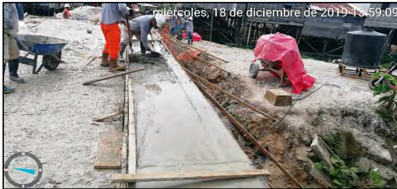
Imagen 92: Vaciado De Mortero F'C = 175\text{kg/Cm}^2 En Veredas (Etapa1) Fuente: Propia
