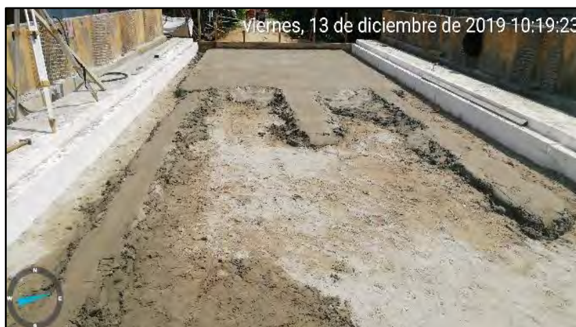
Imagen 86: Base De Pavimento Rígido Fuente: Propia
