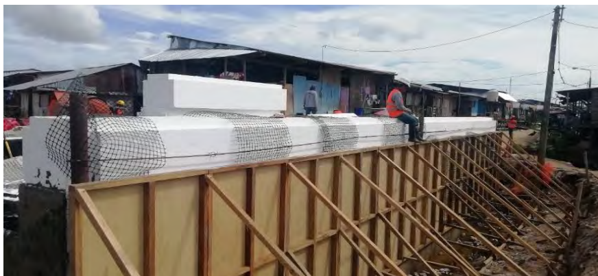
Imagen 82: Colocación De Bloques De Geoespuma En Veredas (Capa 02) Y Geomalla En Vereda Fuente: Propia
