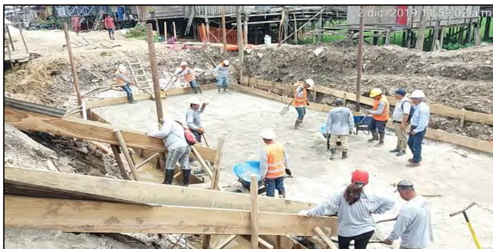
Imagen 73: Mejoramiento Suelo Cemento 1:20 E=0.10m Fuente: Propia
