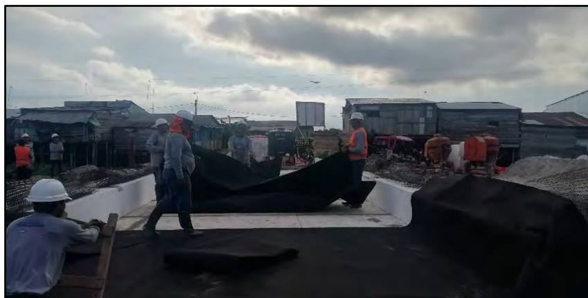
Imagen 80: Colocación De Manta Geotextil Fuente: Propia
