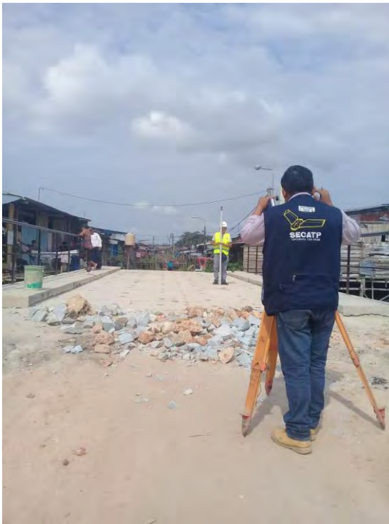
Imagen 97: Toma de datos de Nivelación Fuente: Propia
