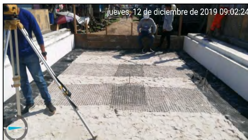
Imagen 84: Traslape De Geomalla Biaxial En Eje De Vía Fuente: Propia
