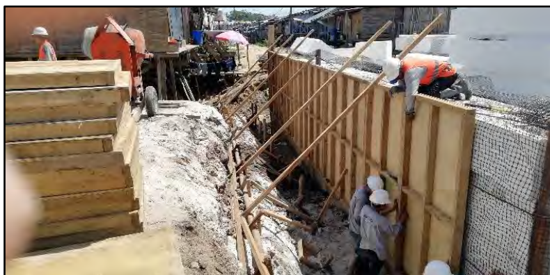
Imagen 81: Encofrado De Pantalla De Confinamiento Fuente: Propia
