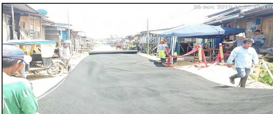
Imagen 71: Colocación De Geotextil Fuente: Propia
