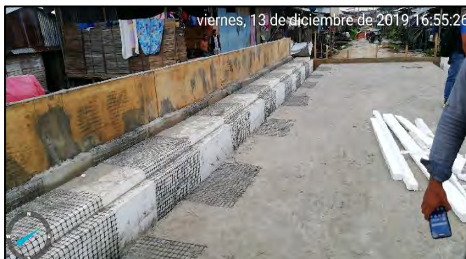
Imagen 87: Excavación De Zanja Para Uña De Pavimento Rígido Y Engrampe De Geomalla Fuente: Propia
