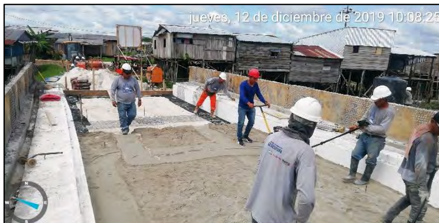
Imagen 85: Sub Base De Pavimento Rígido Fuente: Propia
