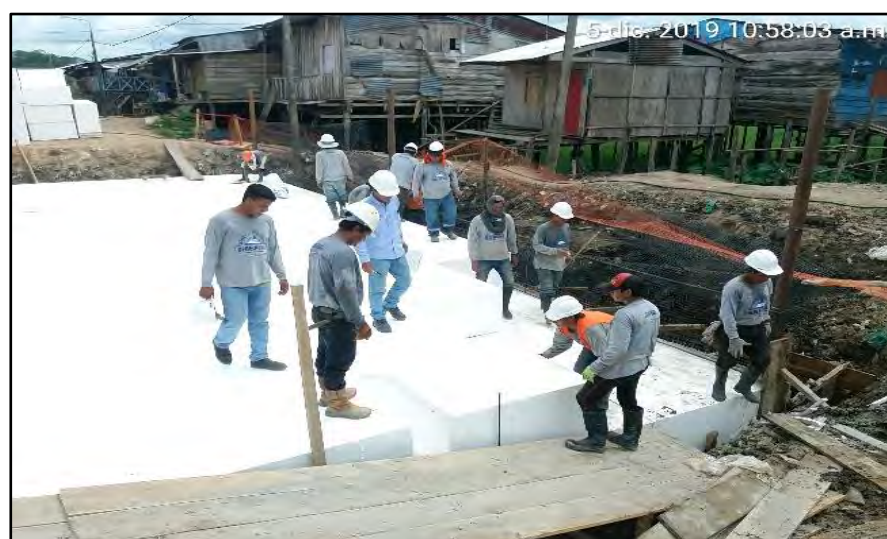
Imagen 77: Colocación De Capa N° 02, 03 Y 04 De Geoespuma Fuente: Propia
