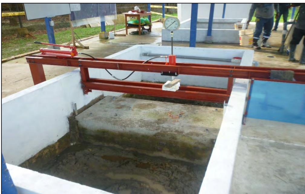
Imagen 42: Prensa hidráulica instalada en el pozo de prueba N° 02 Fuente: Propia
