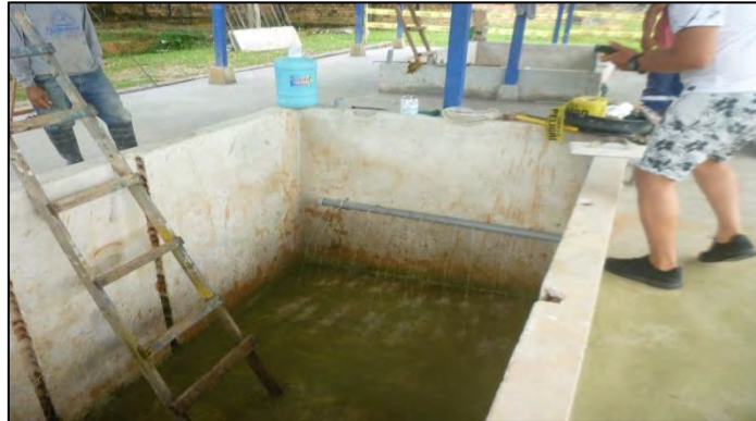
Imagen 23: Prueba de inundación para identificar fugas de agua Fuente: Propia
