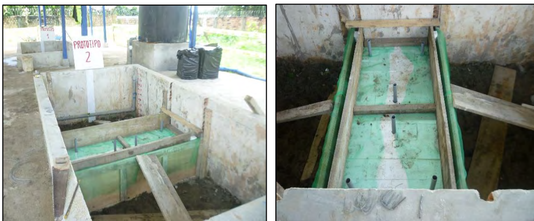
Imagen 27: Construcción del Prototipo 02 Fuente: Propia
