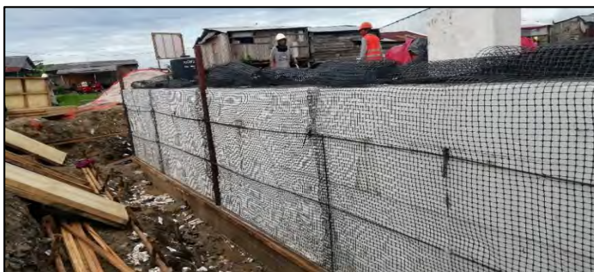
Imagen 78: Colocación De Tensor Transversal Fuente: Propia
