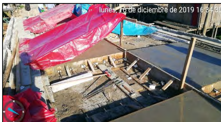
Imagen 89: Vaciado De Mortero F'C=210\text{kg}/\text{Cm}^2 En Losa De Rodadura Fuente: Propia
