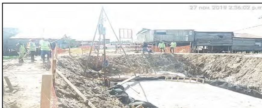
Imagen 72: Trazo Para Hincado De Pilotes Fuente: Propia
