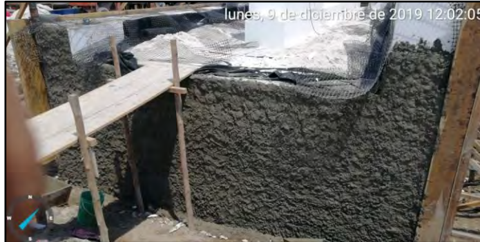
Imagen 94: Sellado Con Mortero De Sección Transversal De Terraplén Fuente: Propia
