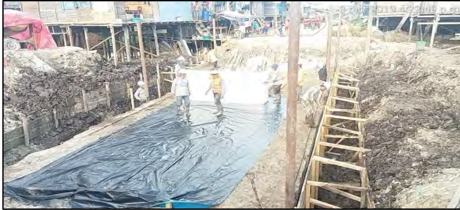
Imagen 74: Entibado Y Excavación De Zanja Para Uñas De Pantalla De Confinamiento Fuente: Propia
