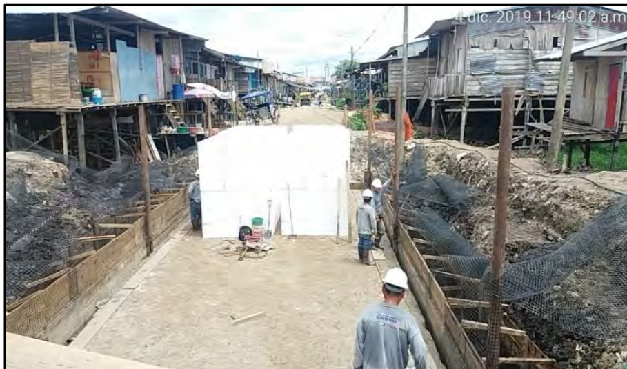
Imagen 75: Colocación De Anclaje Longitudinal Y Geomalla Biaxial (Primera Etapa En La Base De Terraplén) Fuente: Propia
