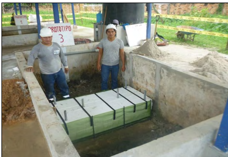
Imagen 28: Construcción del Prototipo 03 Fuente: Propia
