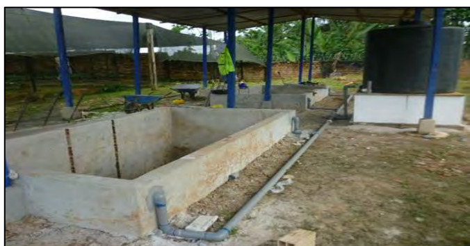
Imagen 21: Instalación De Sistema De Abastecimiento De Agua Fuente: Propia
