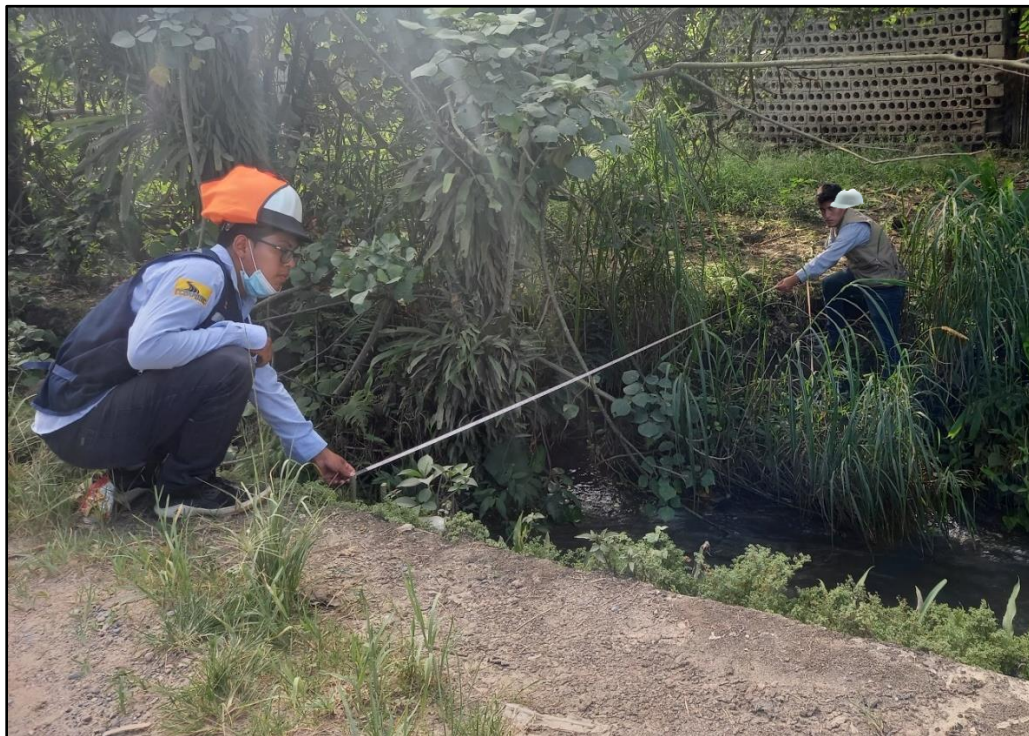
Foto 6: Se aprecia a los Bachilleres inspeccionando las irregularidades en el actual sistema de riego del canal Michuco.
