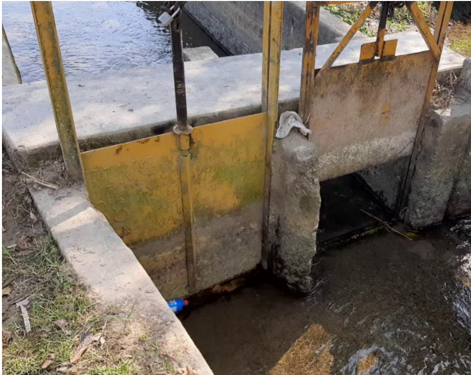
Foto 5: Compuerta de regulación existente en la alcantarilla de progresiva 4+400.
