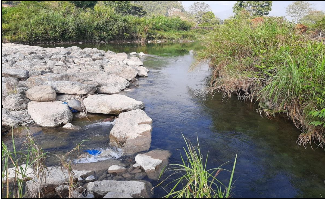
Foto 3: Condición actual en la que se encuentra la captación del sistema de riego del canal Principal Michuco.
