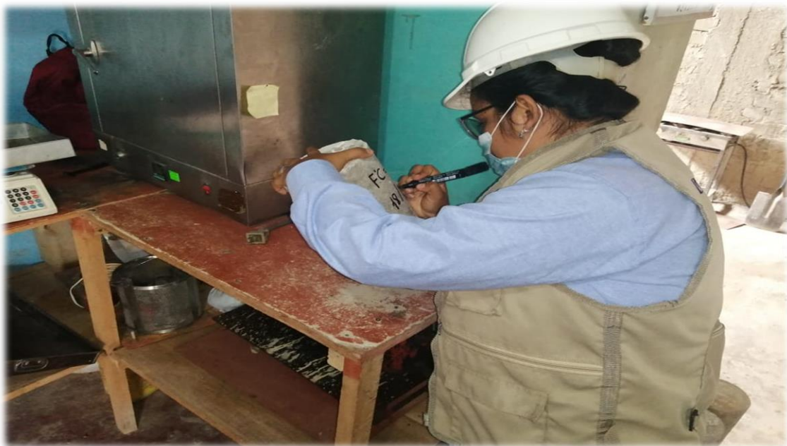
FOTOGRAFÍA N° 12: nomenclatura de los testigos de concreto para proceder a su rotura.
