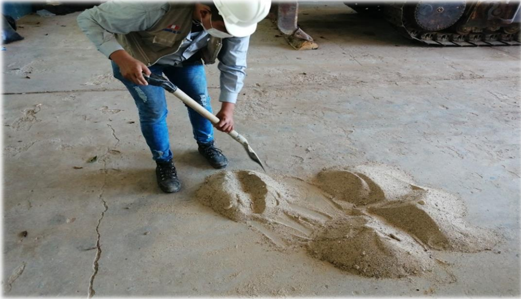
FOTOGRAFÍA N° 01: Cuarteo de la muestra extraída para los ensayos respectivos del agregado fino como el grueso
