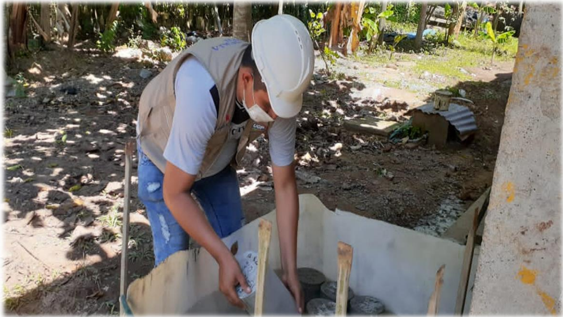
FOTOGRAFÍA N° 11: Proceso de curado de los testigos de concreto
