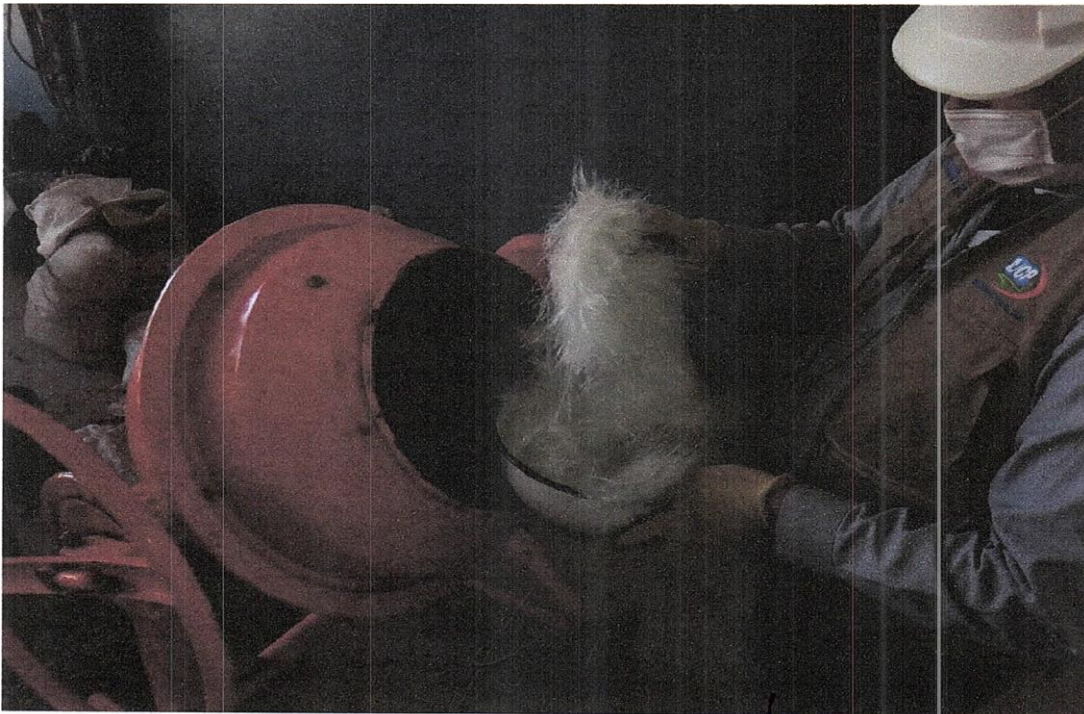
FOTOGRAFÍA N° 08: elaboración de la mezcla de concreto en combinación con la fibra de vidrio tipo "e".
