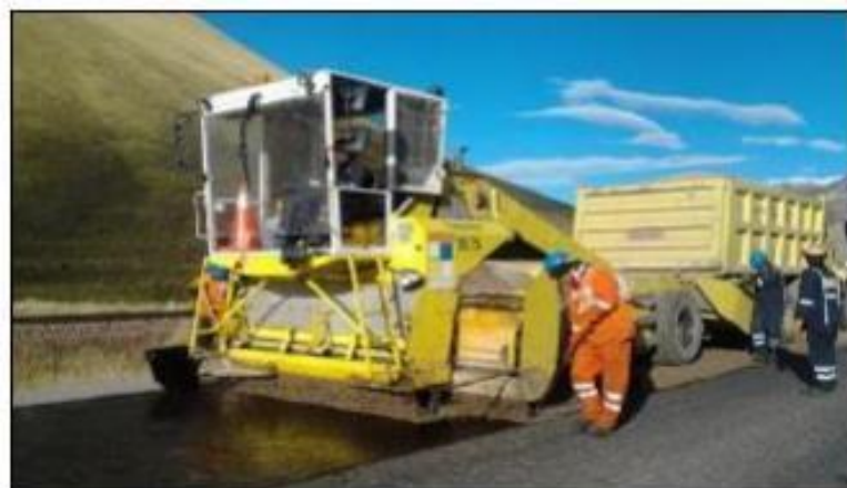
Ilustración 5: Tratamiento superficial bicapa, Km 1087 carretera Sicuani-La Raya
