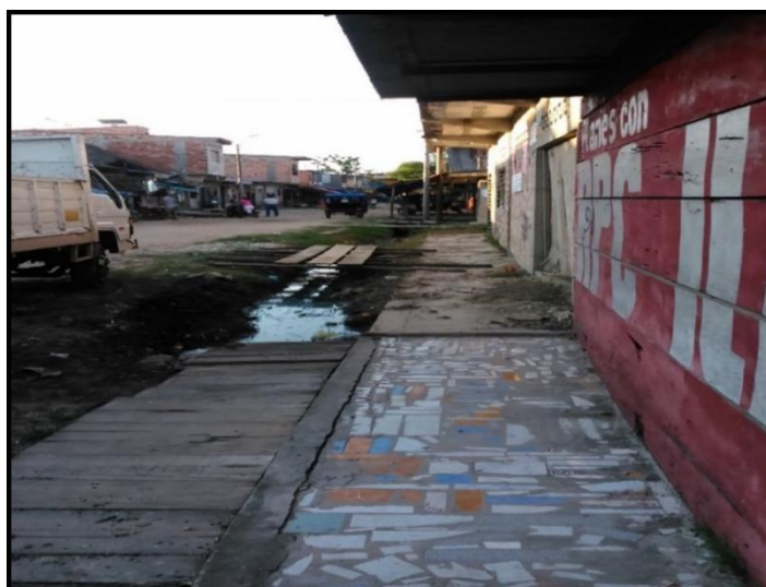
Foto N° 1. Sistema de Red de Agua Potable, con Tubería de PVC SAP Ø 2" en el eje de las calles del AAHH Juan Carlos del Águila Cárdenas
