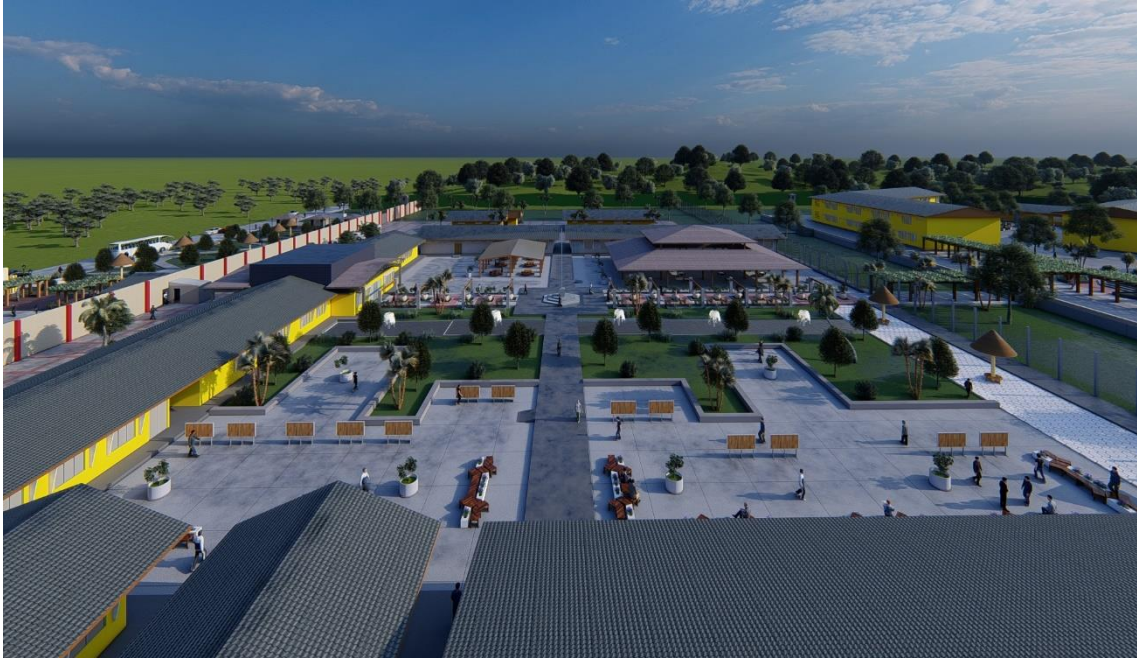
Patio central: zonas administrativas, consultorios, zona de seguridad y recibo de familiares - Centro Juvenil de Rehabilitación y Reintegración Social.
