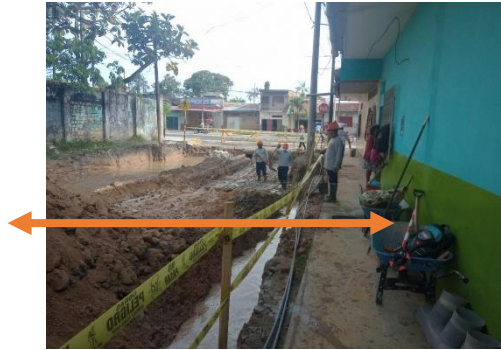
Figura 5. Trabajos en sardinel
