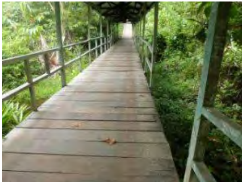
Gráfico 55:PUENTE DE MADERA SOBRE PILOTES
