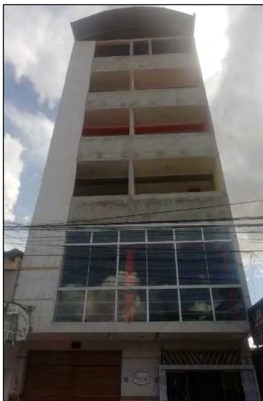
Imagen N° 01: Vista panorámica del edificio de seis niveles.
