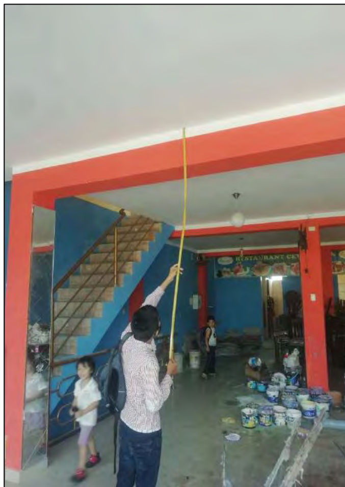
Figura N° 15: Sistema aporcado viga-columna.
