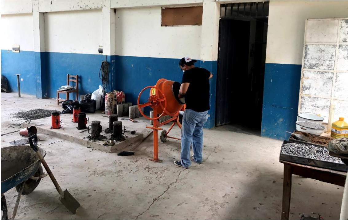
Fotografía 09. Elaboración de la mezcla de concreto.
