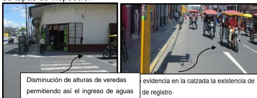
Figura 09: Pérdida de la altura de las veredas y Clausura de tapas de inspección
