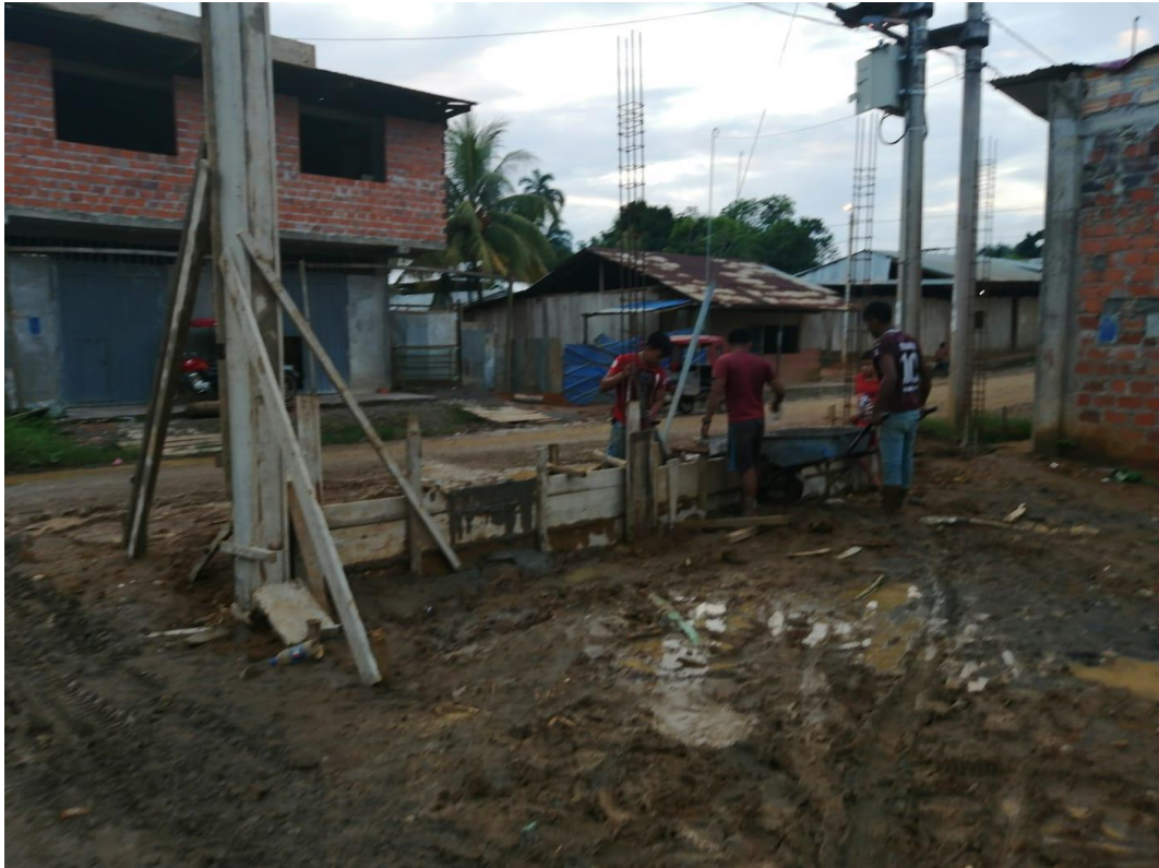
Uso de concreto en sobrecimientos y columnas.
