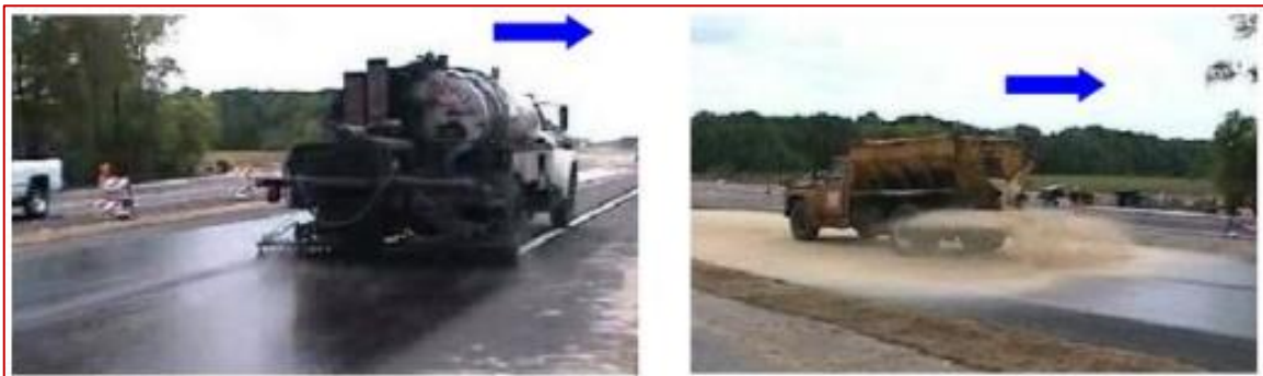
Ilustración 32: Procedimiento Típico de sello de arena – asfalto
