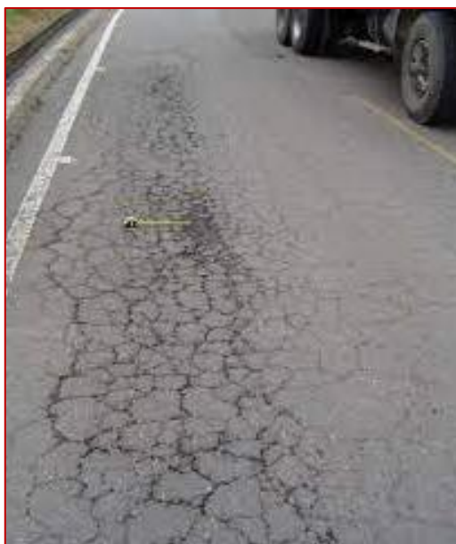
Ilustración 12: Piel de Cocodrilo en el pavimento flexible
