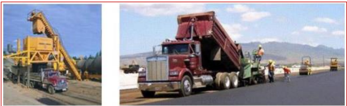
Ilustración 34: Sobre carpeta de asfalto
