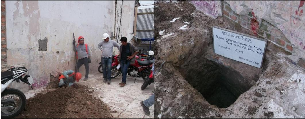
❖ Exploración de cimentación de muro colindante mediante calicatas
