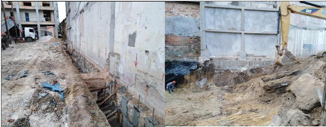
❖ Trabajo de excavación luego del reforzamiento con calzada no convencional
