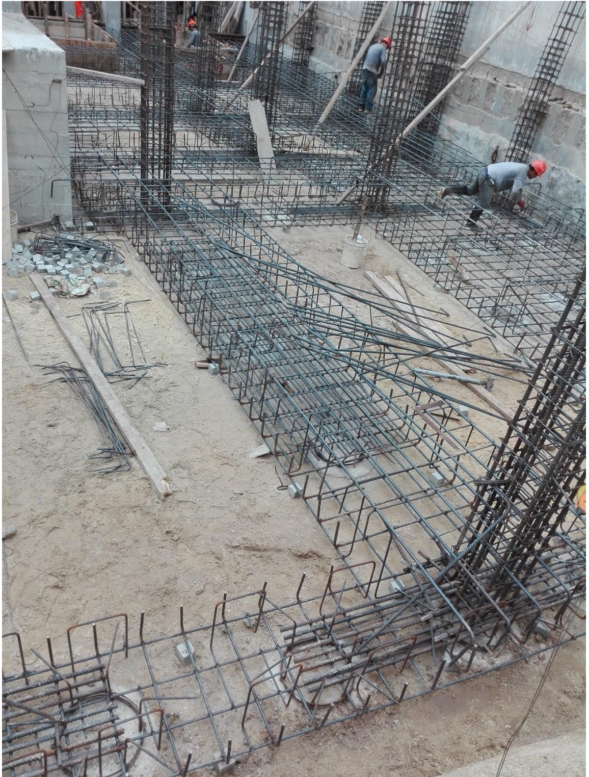
Se deja el anclaje respectivo para el empalme con el acero de las zapatas de la cimentación de toda la estructura.
