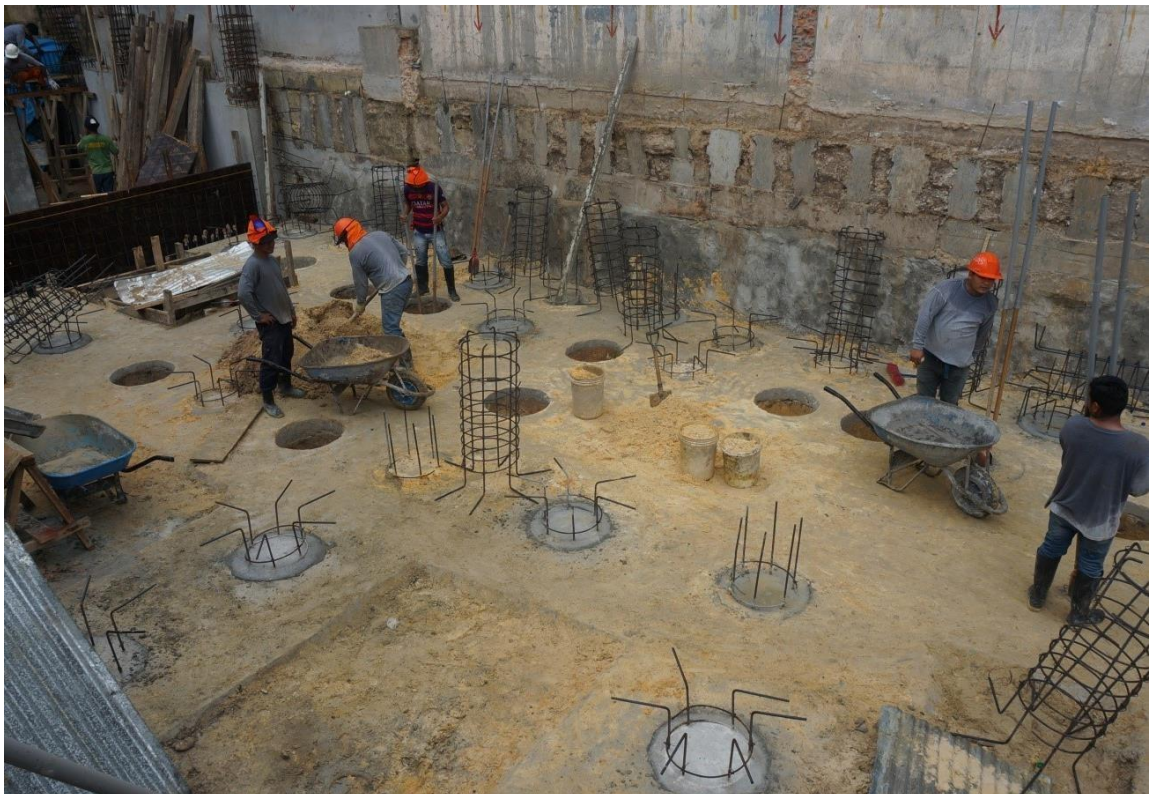
Proceso de trazos de ubicación de pilastras de acuerdo a distribución dada por la memoria de cálculo.
