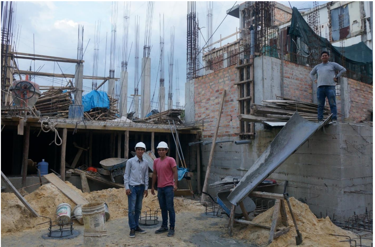
Tesistas. Alex Saavedra y Gerardo Guillen, presentes en los procesos constructivos de las pilastras de concreto armado (Zona ZPT 4)
