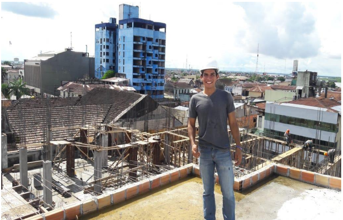
Tesista Alex Saavedra en el último nivel de la infraestructura.
