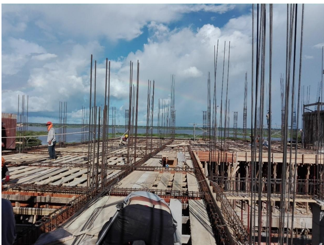
Proceso constructivo de la losa aligerada del tercer nivel de la edificación.
