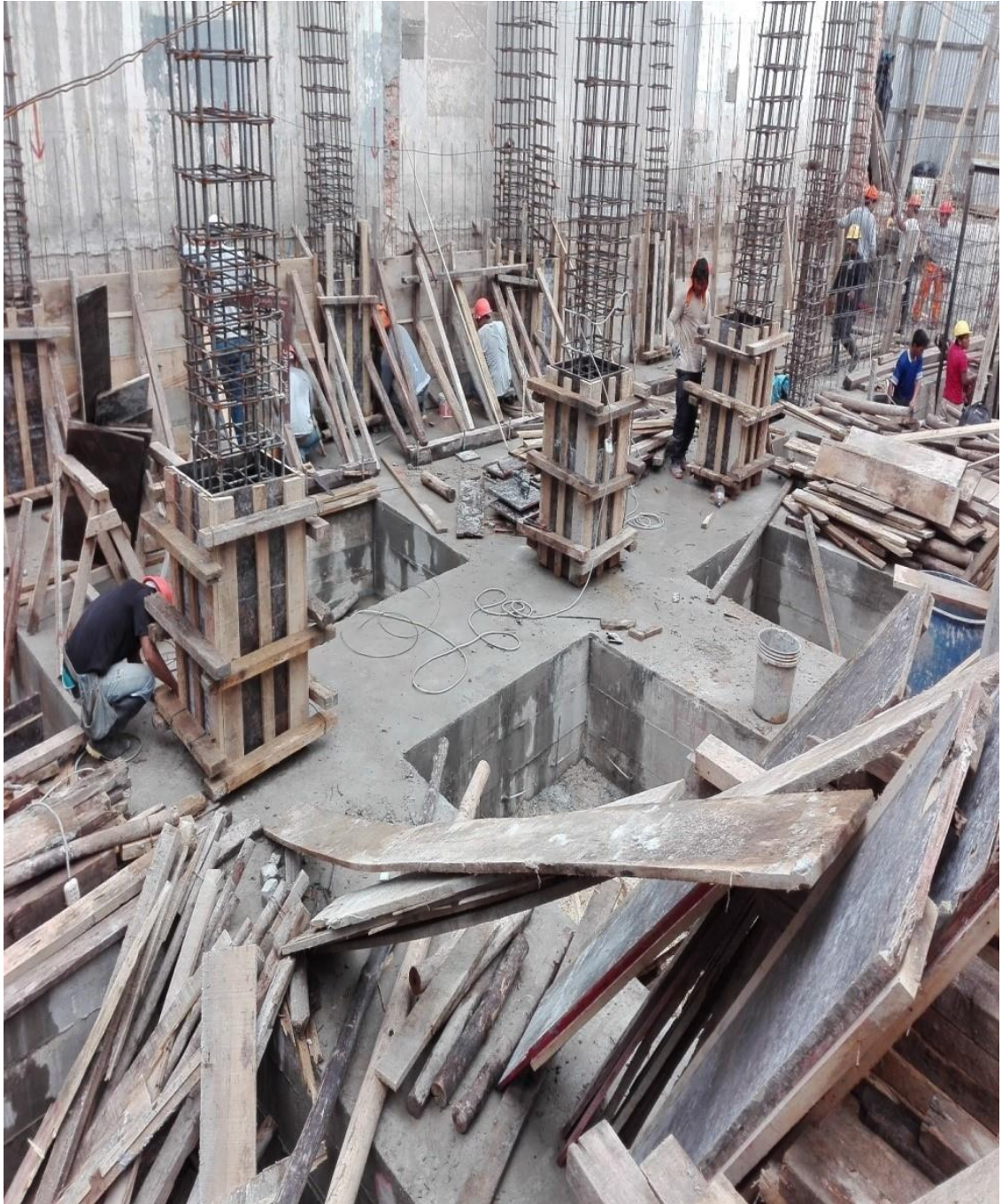
Inicio de trabajos de habilitación de acero para las columnas proyectadas desde la cimentación.
