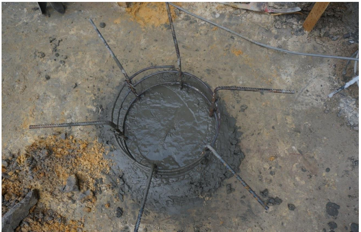
Pilastras vaciadas con su anclaje en la parte superior
