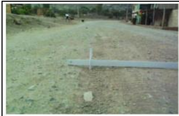
Ilustración 1: Huellas / hundimiento sensible al usuario, pero < 5 cm
