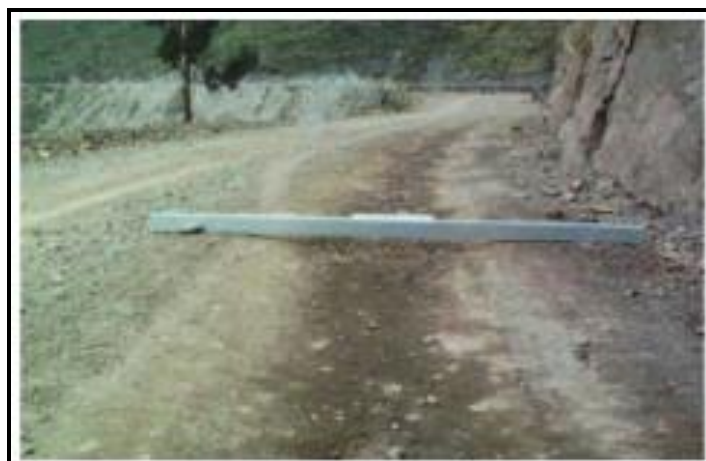
Ilustración 3: Huellas/hundimientos \geq 10 cm
