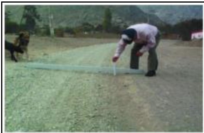
Ilustración 2: Huellas/hundimientos entre 5 cm y 10 cm
