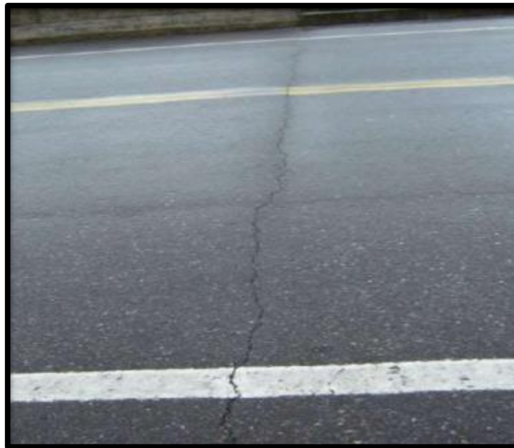
Ilustración 5: Fisura Transversal
