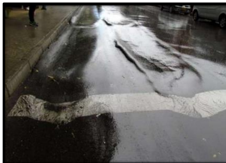
Ilustración 1: Ahuellamiento
