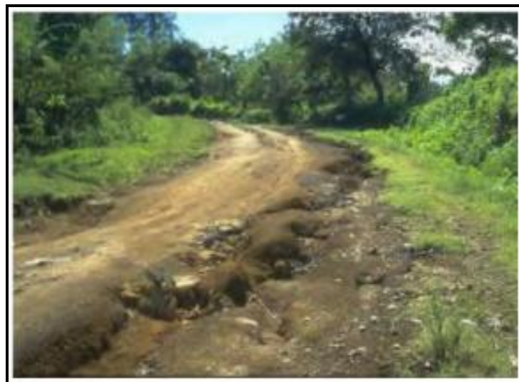
Ilustración 6: Drenaje inadecuado
