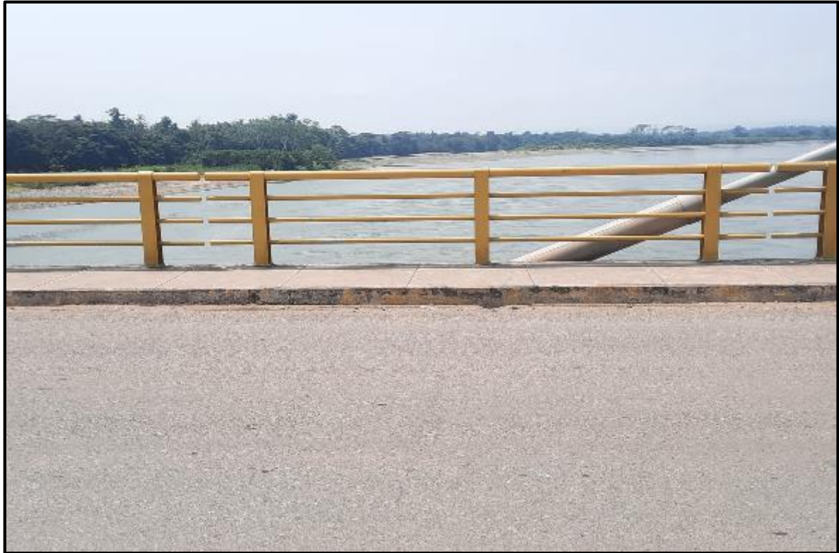
Foto N° 35: Se aprecia las veredas en buen estado y desgaste de pintura en vereda.
