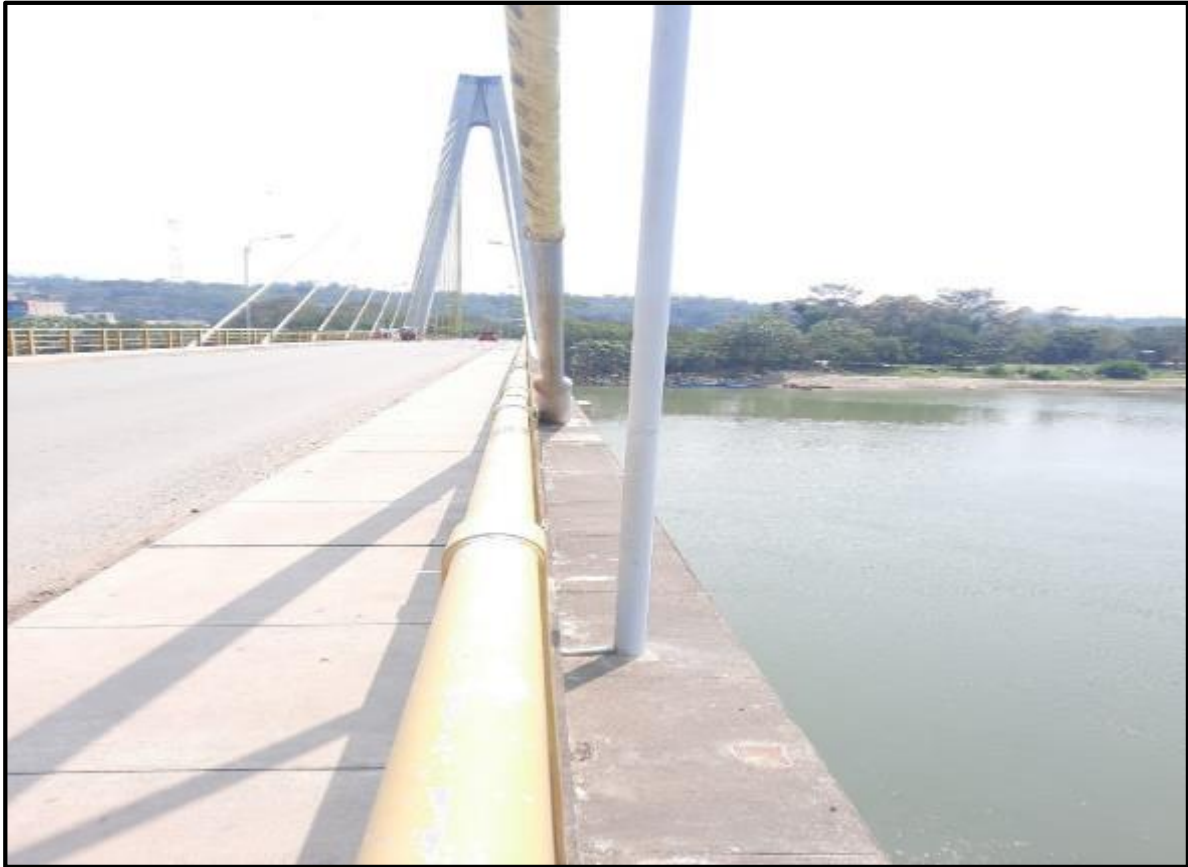
Foto N° 33: Se aprecia las veredas en buen estado margen derecha.
