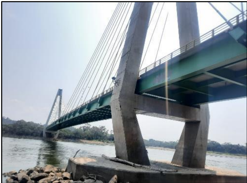
Foto N° 03: Se aprecia que las cimentaciones se encuentran en buen estado, Margen derecha.
