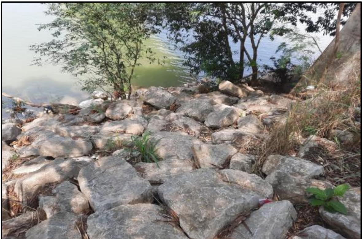
Foto N° 54: Se aprecia enrocado para protección en la ribera del río Huallaga, en buen estado, margen izquierda.
