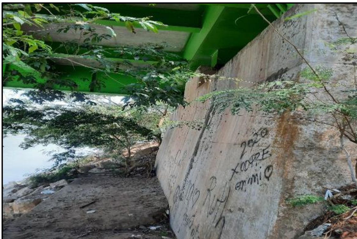
Foto N° 55: Se aprecia vegetación en la parte inferior del puente, los cimientos y pilar en buen estado, margen izquierda.
