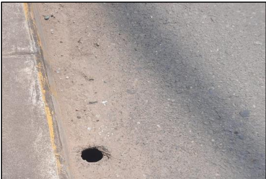
Foto N° 22: Se aprecia el drenaje pluvial en buen estado.
