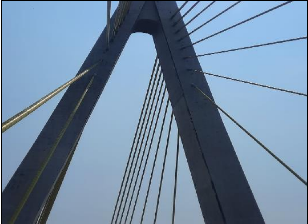
Foto N° 40: Se aprecia los pilones en buen estado.
