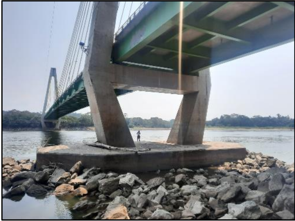
Foto N° 03: Se aprecia que las cimentaciones se encuentran en buen estado, Margen derecha.
