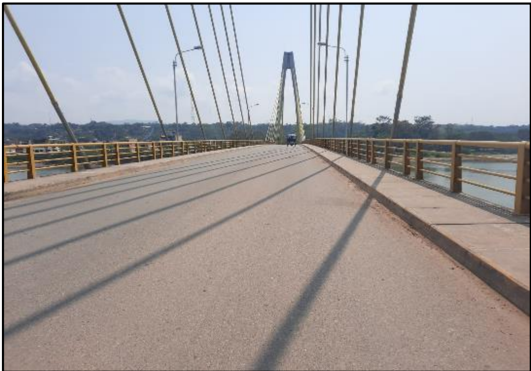
Foto N° 28: Se aprecia la carpeta de rodadura del puente en buen estado.
