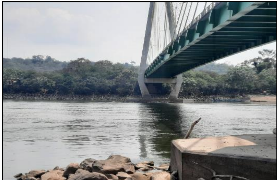
Foto N° 08: Se aprecia protección con enrocado a la margen izquierda del río Huallaga.
