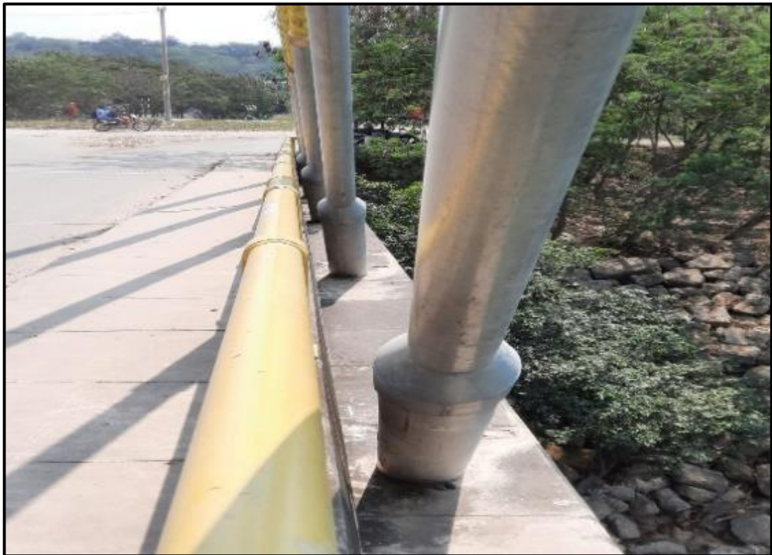
Foto N° 46: Se aprecia vereda y cables en buen estado.
