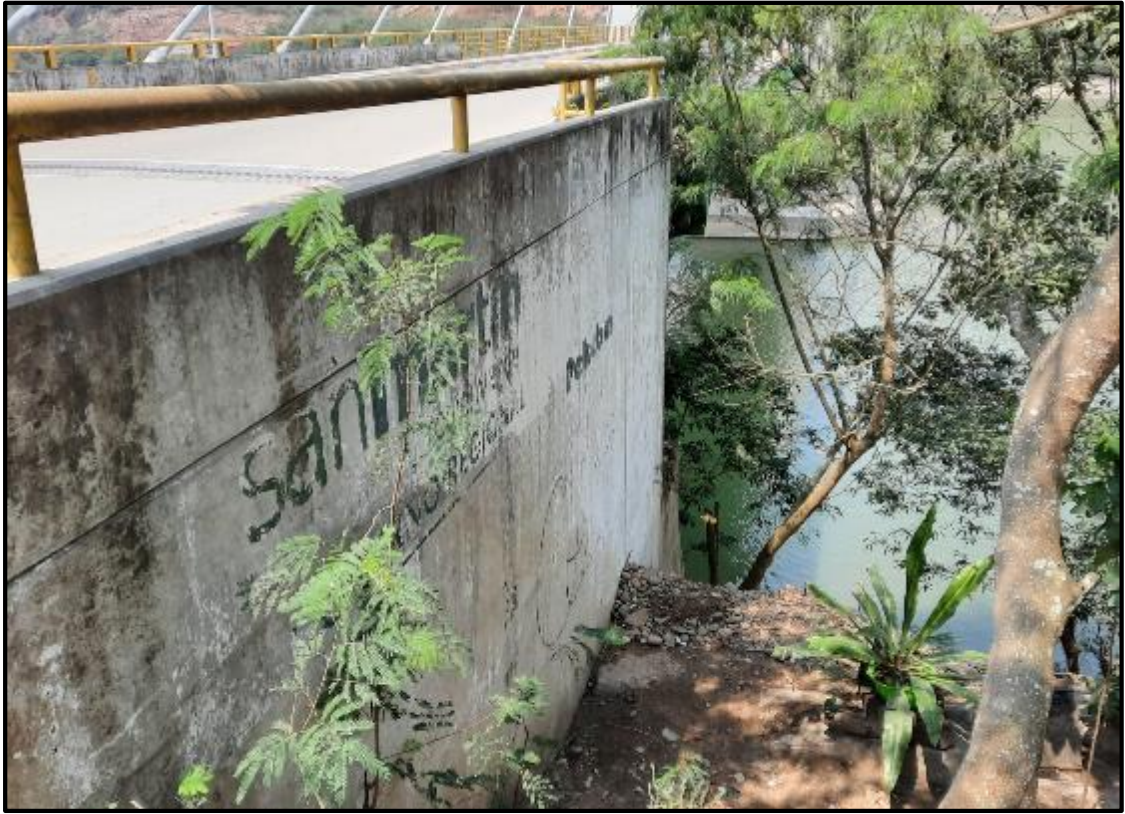
Foto N° 51: Se aprecia vegetación en margen derecha del puente.
