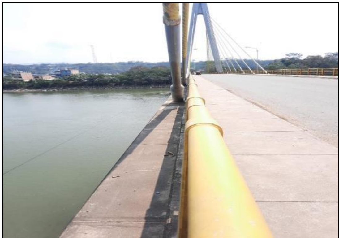
Foto N°32: Se aprecia las veredas en buen estado margen izquierda.
