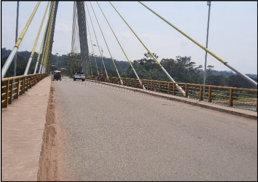
Foto N° 37: Se aprecia la carpeta de rodadura en buen estado.
