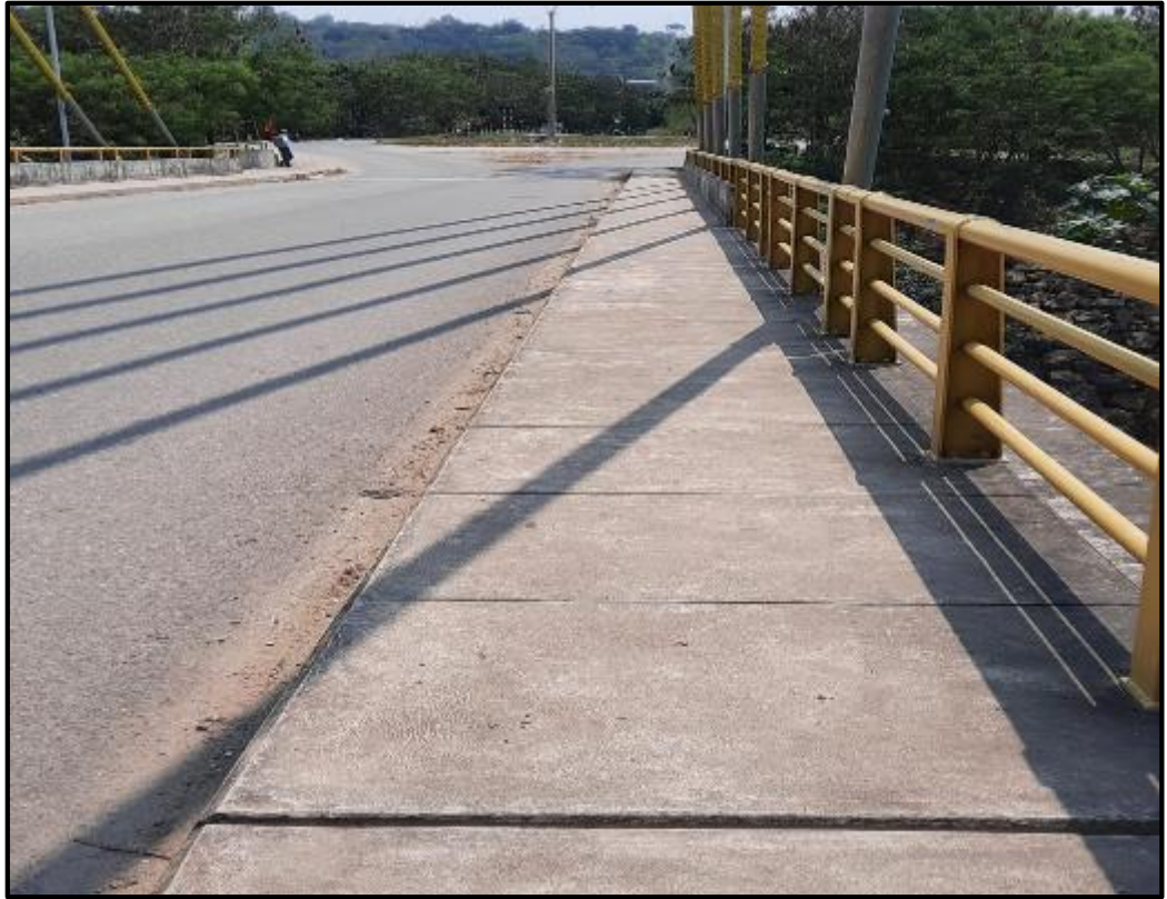
Foto N° 43: Se aprecia las veredas en buen estado.
