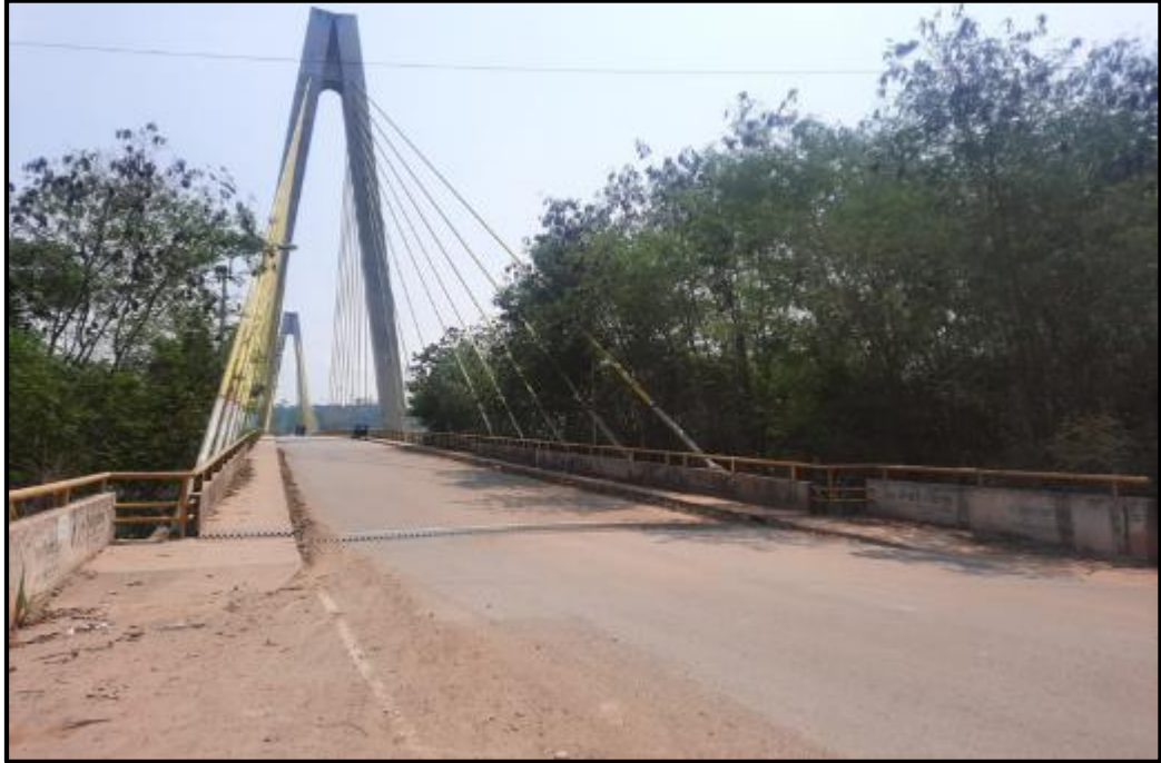
Foto N° 01: PUENTE ATIRANTADO – PROVINCIA DE BELLAVISTA
