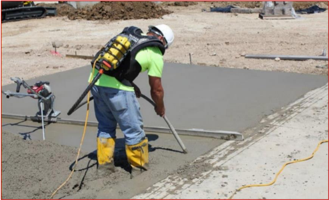
Ilustración 4: Vibración para asentado del concreto
