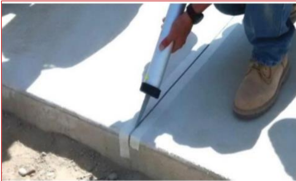
Ilustración 11: Sellado de Juntas
