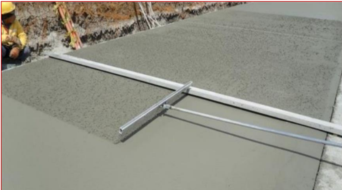
Ilustración 5: Acabado del Concreto
