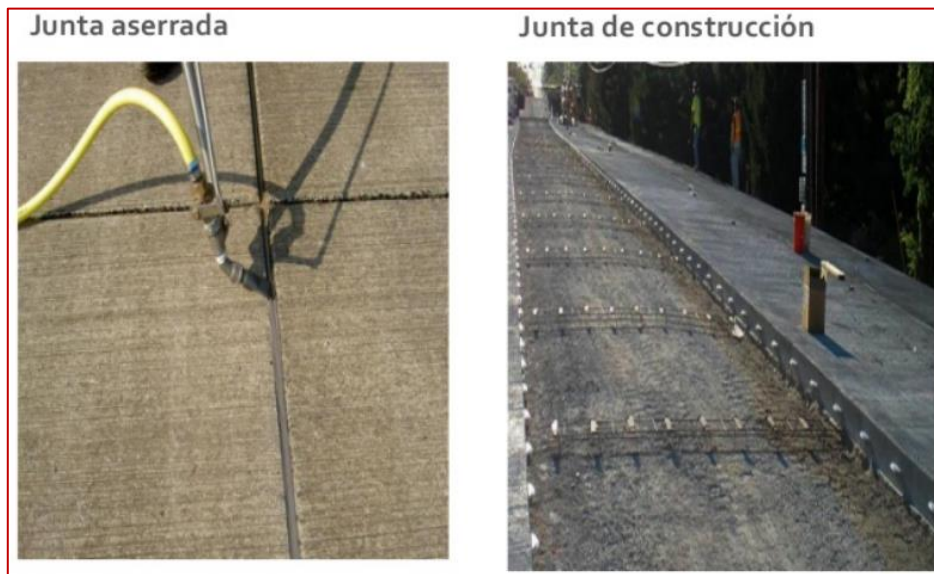
Ilustración 8: Colocación de juntas
