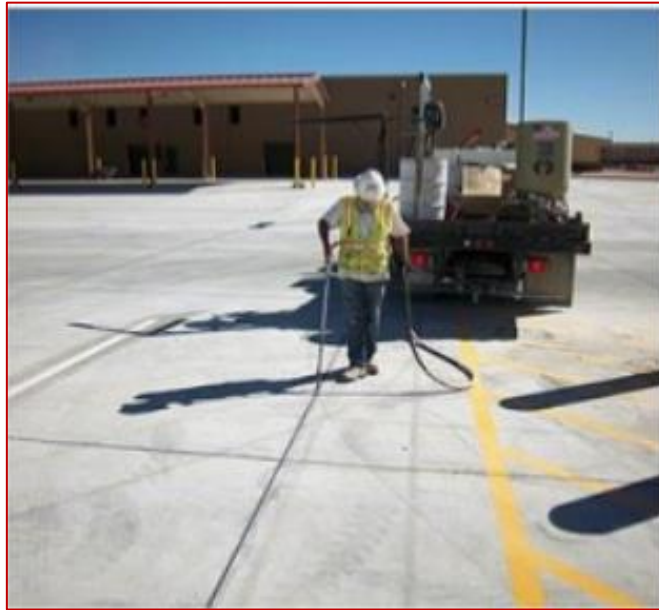
Ilustración 10: Limpieza de pavimento y juntas
